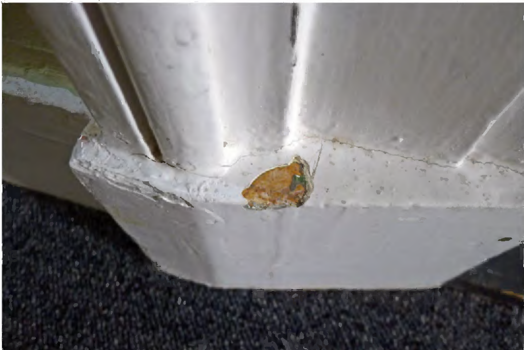
34 Neut van deurkozijn. Hierop is eenzelfde verfpakket aangetroffen als op het deurkozijn. De eerste afwerking is een houtimitatie, gevolgd door grijze, groene en roomwitte verflagen. De huidige afwerking is een witte verf.
