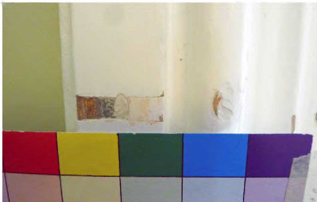
67 Het verfpakket op platstuk van het kozijn bestaat uit roodbruine houtimitatie als eerste afwerking, lichte grondlaag, gelig groene verflaag, groene verflaag (NCS S 6040-G40Y), roomwitte grond- en verflaag, heel lichtroze (grond)laag, als laatste huidige witte verf.
