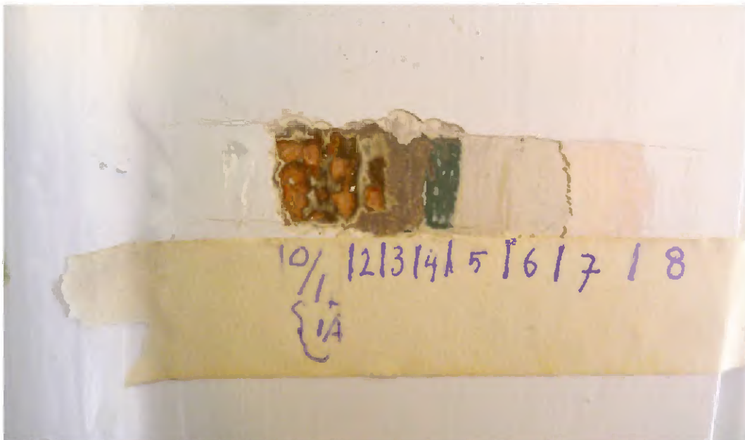
66 Het verpakket bestaat uit (1/1a) roodbruine houtimitatie als eerste afwerking, (2) lichte grondlaag, (3) g g groene verflaag, (4) groene verflaag (NCS S 5040-G40), (5, 6) roodwitte grond- en verflaag, (7) heel lichtroze (grond)laag, (8) als laatste huidige witte verf.
