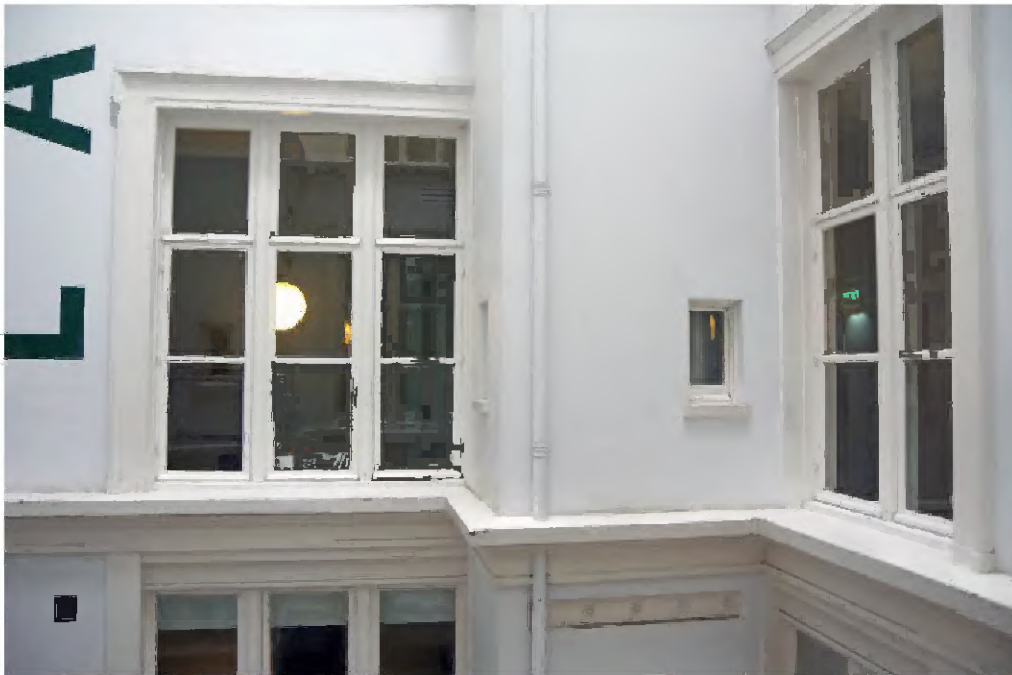
8 Wit geschilderde vensters in de rondesloek van de noordelijke binnenplaats en inbouw met toiletten (1938 of later). De witte afwerking van gevels en vensters dateert van 1997-1998.
