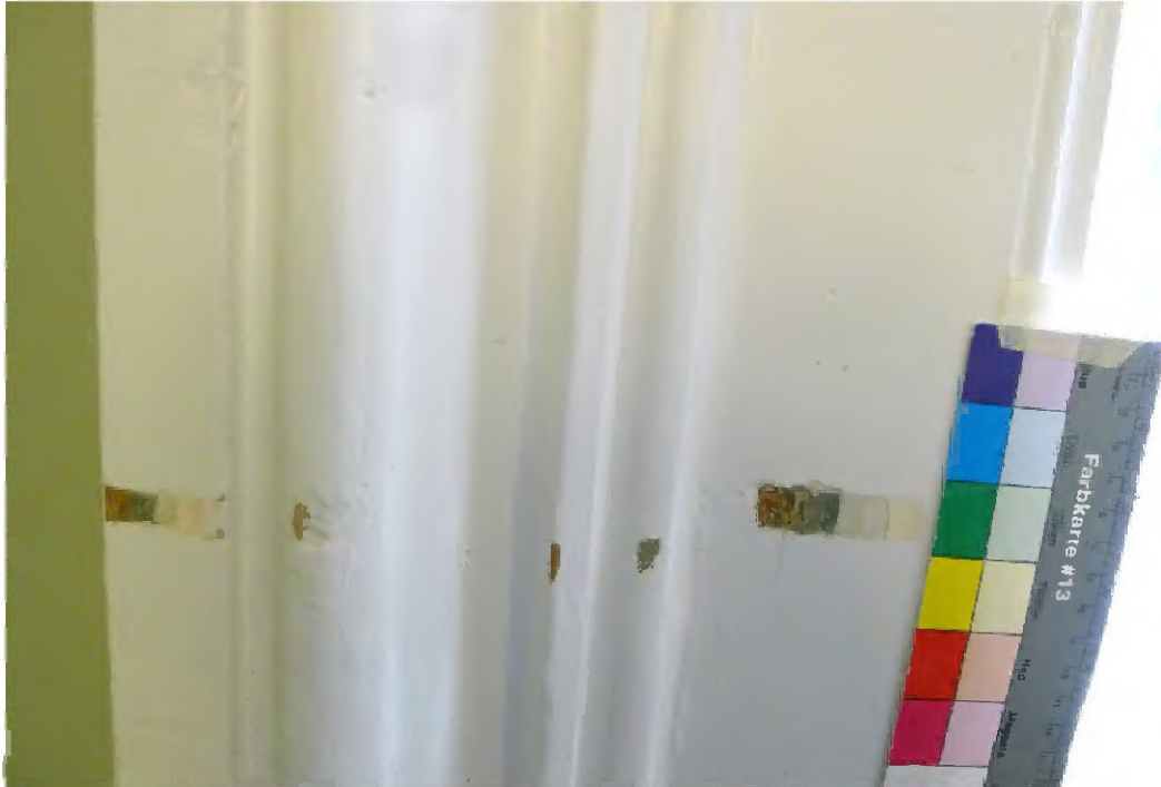
65 Verschillende onderzoekspunten op het kozijn.
