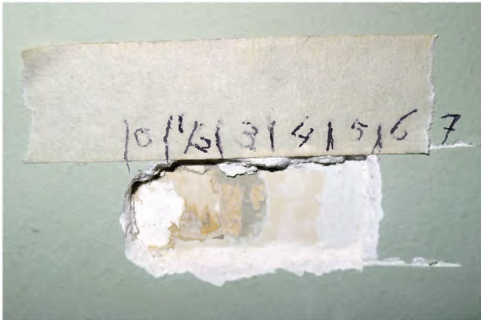
45 De afwerking van de wand bestaat uit gips stucwerk, dat meerdere malen gesausd is (muurverf). De eerste afwerking (1/2 moeilijk vrij te leggen) is een okergele kleur en een iets grijzere laag, (3) lichtgrijze laag, (4) lichtroze laag, (5) witte laag, (6) dikkere laag gipsstuc en (7) huidige groenige grijze afwerking.
