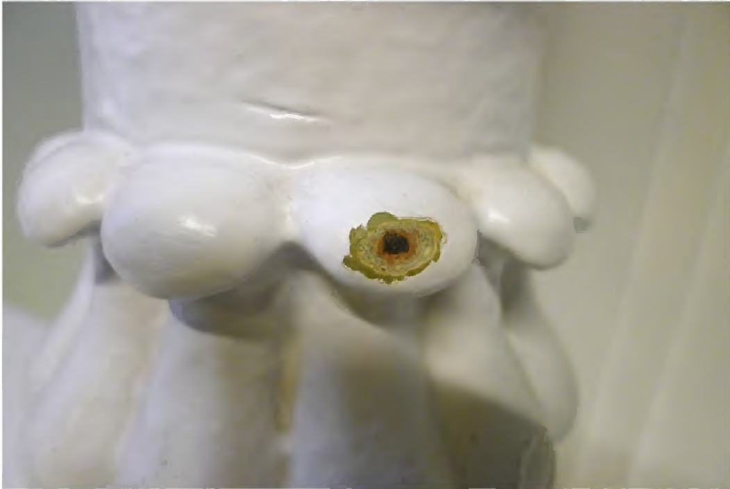
42 Toverbal op bladuiteinde van de voet van de kolom. De eerste afwerking op een rode menie is een roze verf; deze komt later nog een keer, iets lichter, terug voordat een olijfgroene verf werd aangebracht; de laatste afwerkingen zijn een witte, lichtgroene en witte verf.
