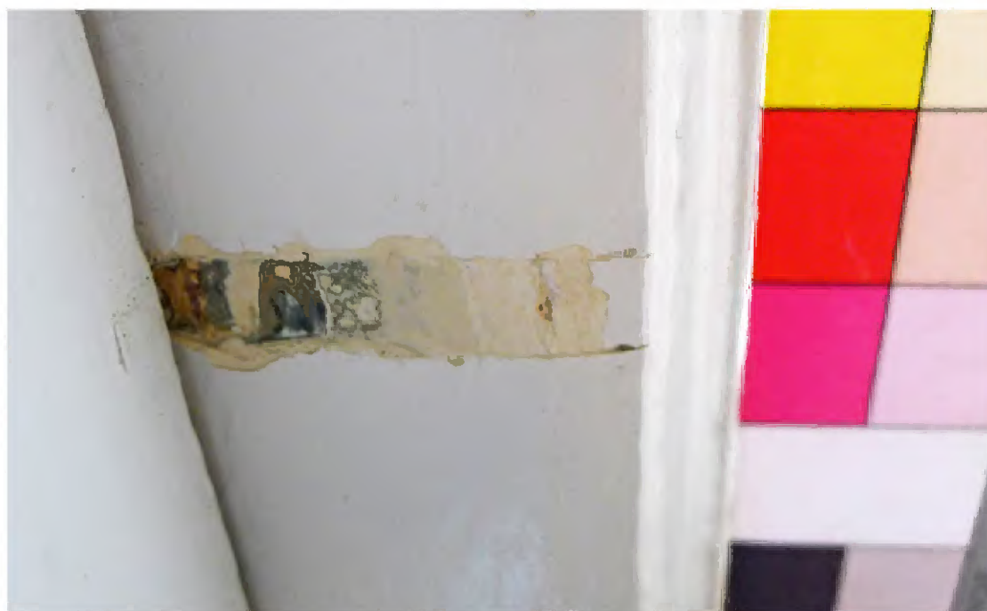
68 Het verfpakket op het raam bestaat uit roodbruine houtimitatie als eerste afwerking, gevolgd door een heel donkergroene (?) laag, groene verflaag op een grijze grondlaag, roomwitte grond- en verflaag, heel lichtroze (grond)laag, als laatste huidige witte verf.
