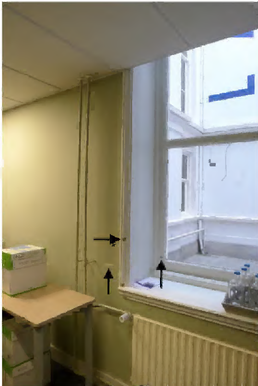
12 Interieur begane grond met onderzoekspunten wand (1) en venster (2) aan oostzijde van noordelijke binnenplaats. De wand (1859) is altijd een binnenwand geweest. De vensterpartij is in aanleg uit de bouwtijd. Mogelijk is het raam of zijn delen ervan verbouwd.
