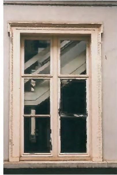
7 Foto 1996. Venster (1859) in zijgevel van het trappenhuis op de tweede verdieping met gietijzeren omlijsting. Het gehele venster is lichtroze van kleur. (Herkomst foto: Kamphuis & Vlaardingh 1996)
