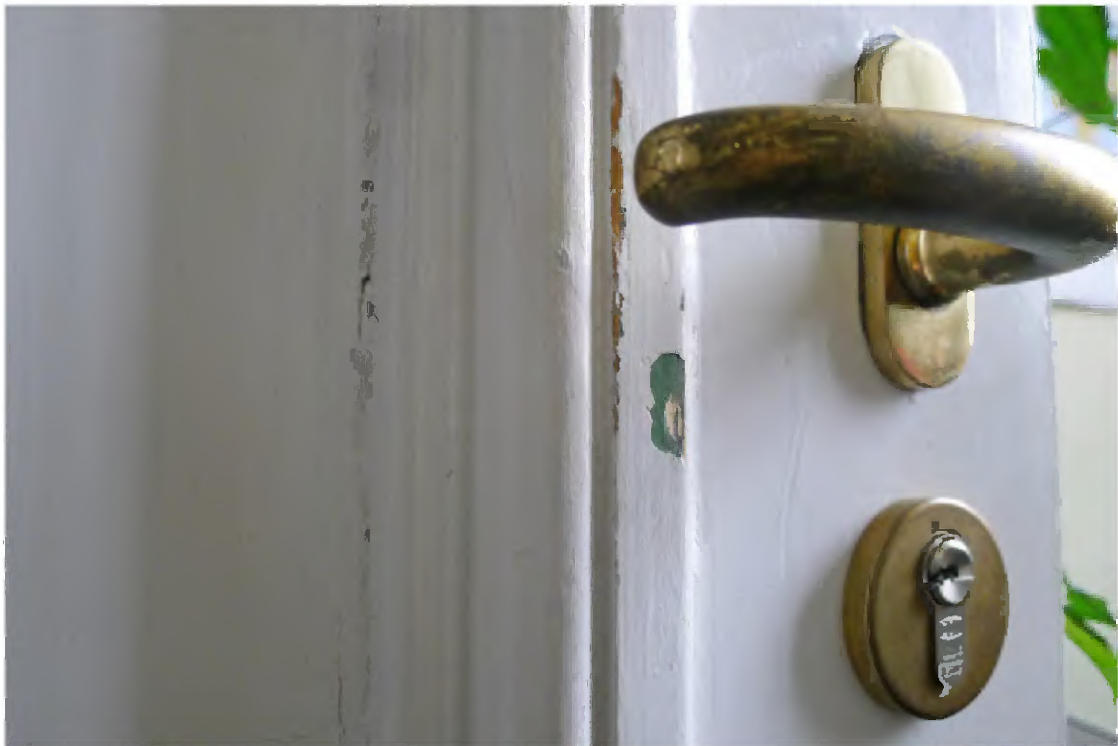
60 Deur in tweede kozijn. Hierop is ook een groene verf aangetroffen. Of de deur allereerst een houtimitatie als afwerking heeft gehad, is niet vastgesteld, maar goed mogelijk.
