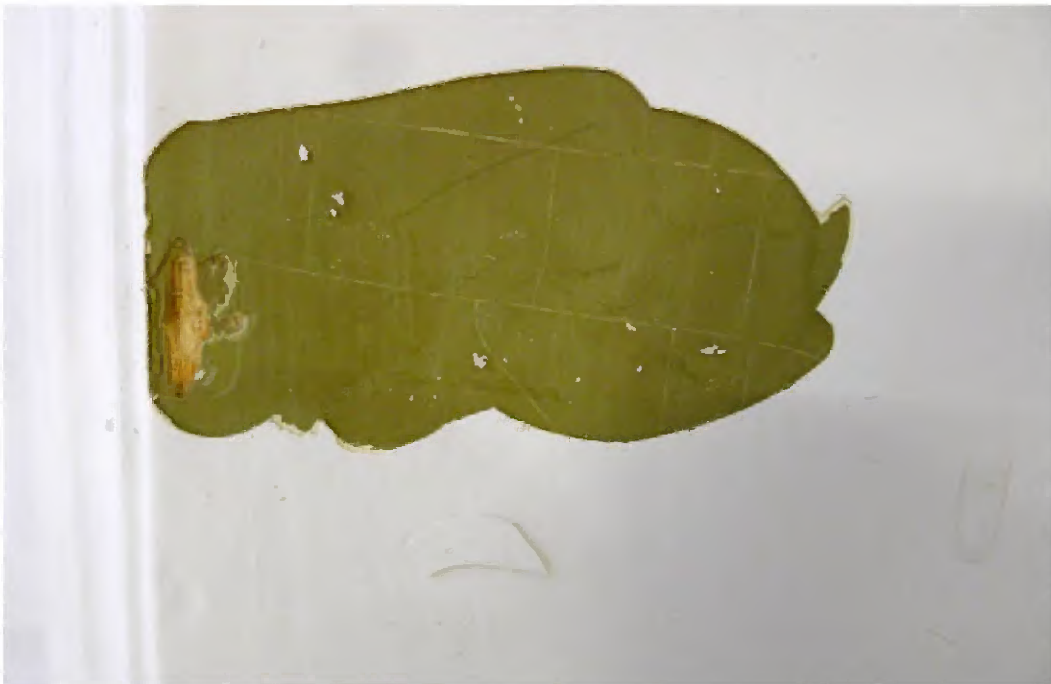
43 Op de stijen van het houten raam is behalve de huidige witte verf afwerking een olijfgroene verf in twee lagen aangetroffen, die ook op de gietijzeren onderdelen is gevonden. Als eerste is een lichte grondlaag voor een houtimitatie zichtbaar. De bijbehorende vernis is niet vrij gelegd.
