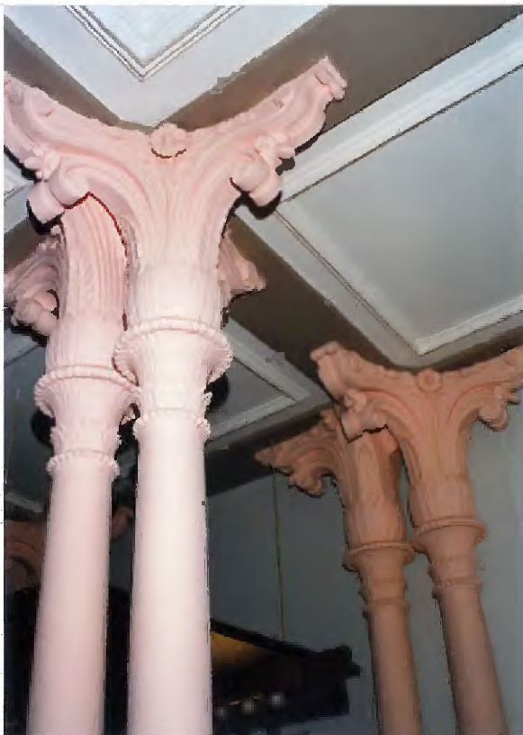
10b De hal in 1997. De kolommen zijn roze geschilderd. Of dit een op dat moment bestaande afwerking is of een grondlaag voor een toekomstige afwerking is onduidelijk. Het plafond heeft een polychrome afwerking. (Herkomst foto: Kamphuis & Verbeek 1996)
