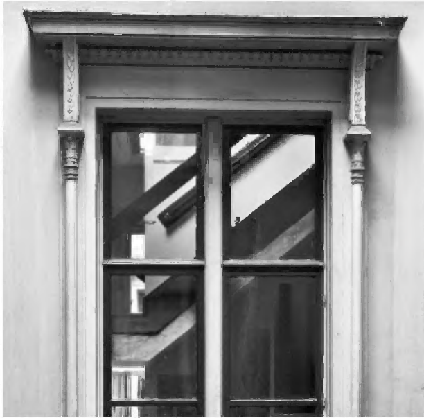
6 Foto ca. 1969. Venster (1859) in zijgevel trappenhuis met oorspronkelijke gietijzeren omlijsting (inclusief kroonlijst en zuiltjes) op de eerste verdieping (jaren zestig van de vorige eeuw). De ramen zijn donker (groen) van kleur. (Herkomst foto: Foidema 2019)
