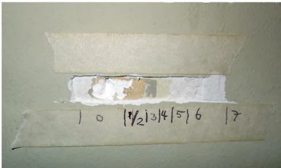
47 De afwerking van de wand bestaat uit gips stucwerk (0), dat meerdere malen gesausd is (muurverf). De eerste afwerking (1/2 moeilijk vrij te leggen) is een okerleurige verflaag en een iets grijzere verflaag, (3) lichtgrijze verflaag, (4) roomwitte verflaag, (5) heel lichtroze (hecht)laag, (6) dikkere laag gipsstuc en (7) huidige groenige grijze afwerking.
