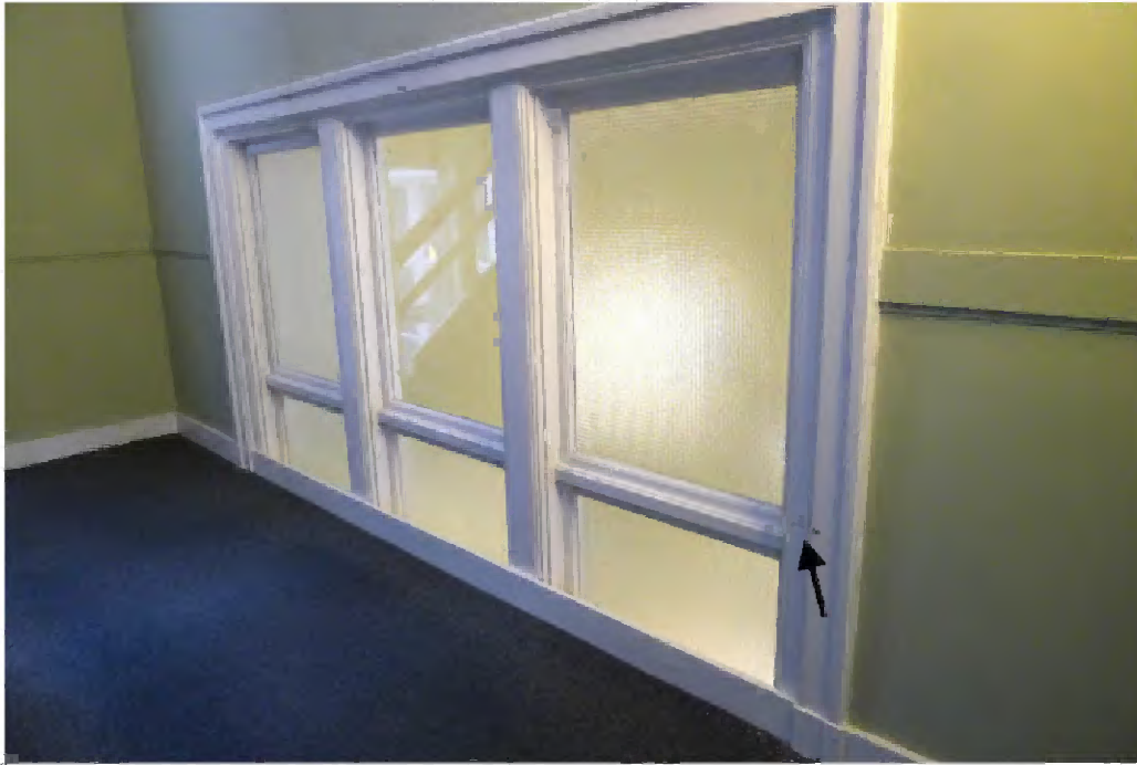
35 Houten kozijn in het trappenhuis; aan de achterzijde bevindt zich het glazen buitenkozijn (1859) dat in 1883 in het interieur is geraakt.
