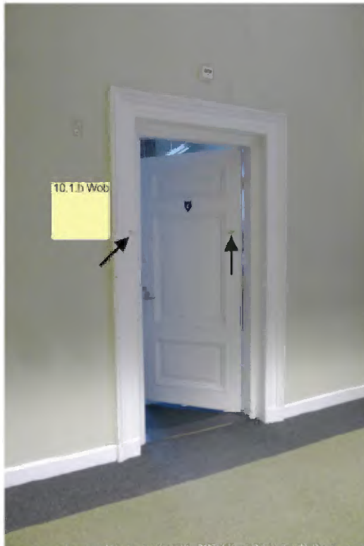
48 Wand, deur en kozijn onderdeel van uitbreiding 1883 aan de westzijde (achterzijde). Het houtwerk van deur en kozijn is witgeschilderd. De wand heeft een lichte groenig grijze verf als laatste afwerking.
