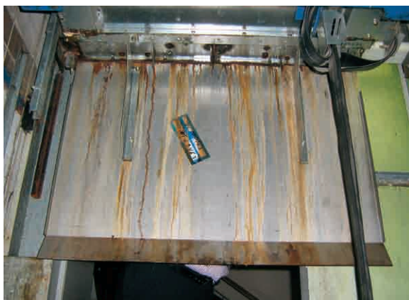
Kooiframe en ondergeleiding in conditie 4
