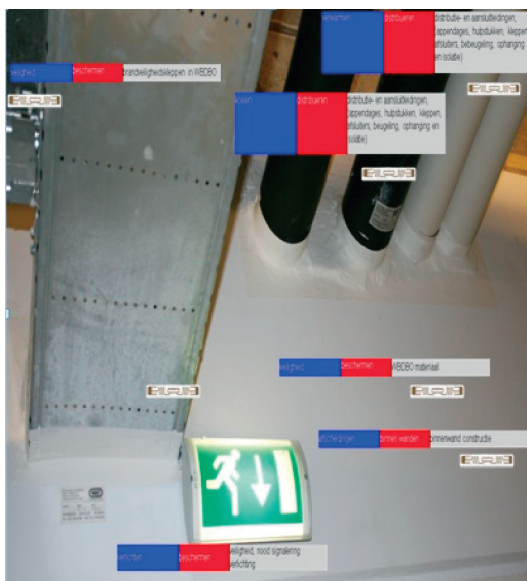
Figuur 5.1: Voorbeeld van brandwerende afscheiding.
