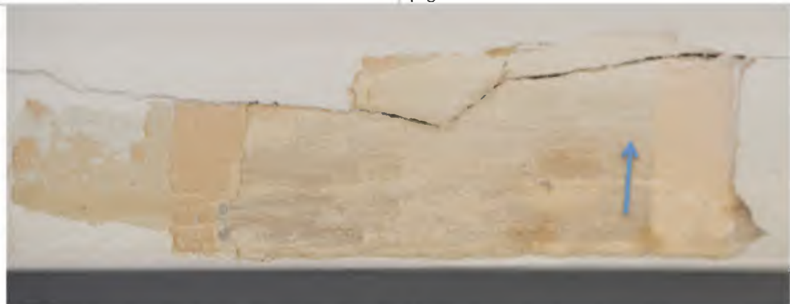
Stratigrafie op de profiellijst van de omstuucte balk. De pijl geeft de oudste kalklaag aan.
