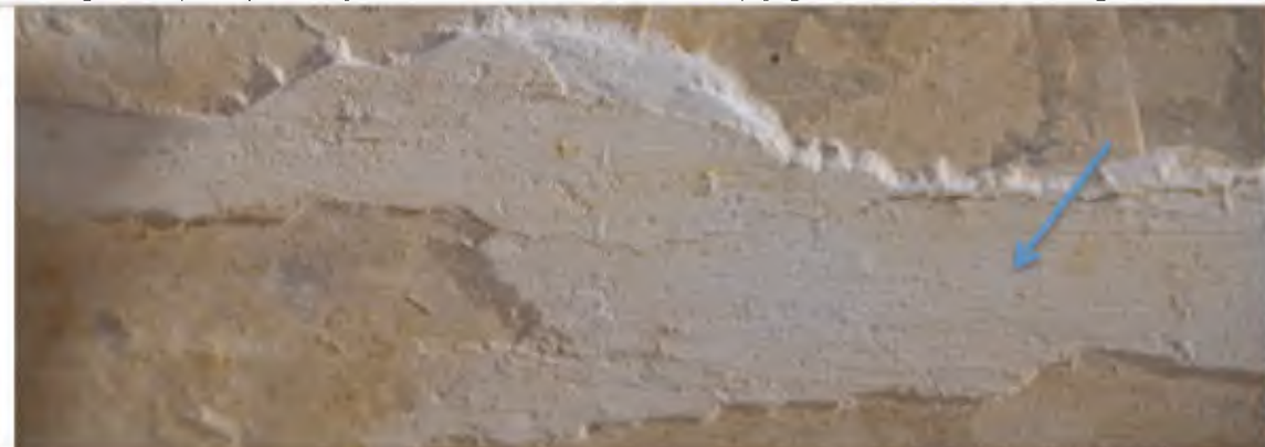
Mogelijk oorspronkelijke kalklaag onder een pakket plamuur.
