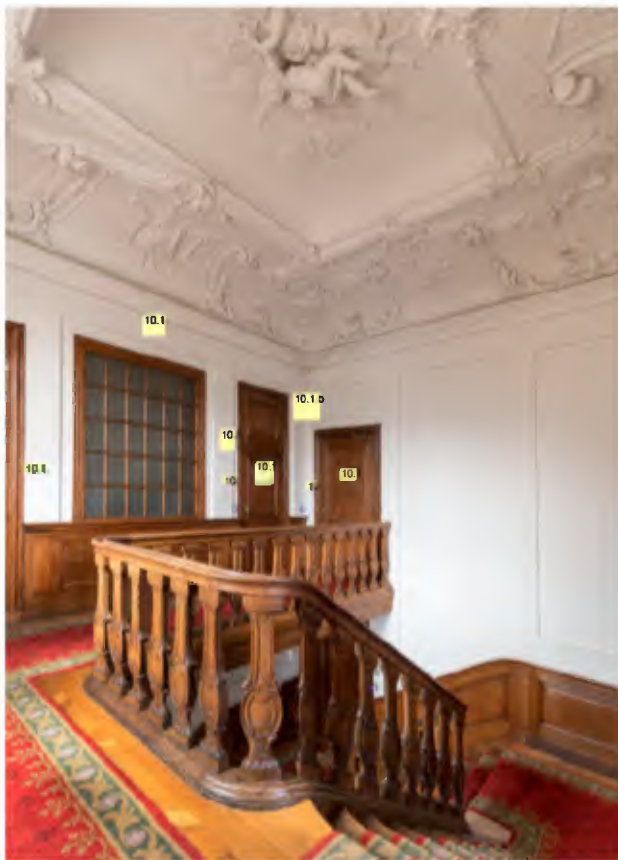
Interieur, Stadhouderstrap in Oud Stadhouderswijk (thans Eerste Kamer), overloop op tweede verdieping met stucplafond, lambrisering en leuning met balusters, beeldbank Rijksdienst Cultureel Erfgoed inventarisnummer IvhB-0088, dd 2018
