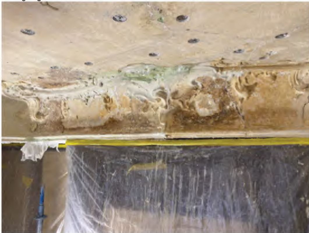
Foto tijdens reinigen van het plafond. De strook met eikenhoutimitatie is hier aanwezig.
