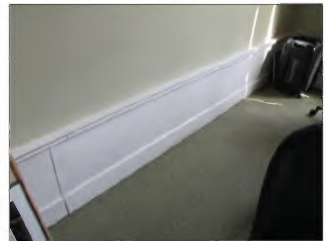
Afb. 3.167 De strokenlambrisering in 10.1.b Wob (N 71, categorie 3-B) is later afgetimmerd met moderne platen
