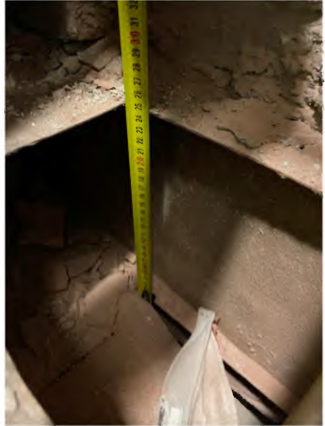
Afbeelding 4.27. Doorbraak door een van de oorspronkelijke ijzeren aanvoerkanalen voor verse lucht in een recent aangebrachte installatiekast grenzend aan de corridor 10.1.b Wob (foto WDJA/10.2.e Wob)
