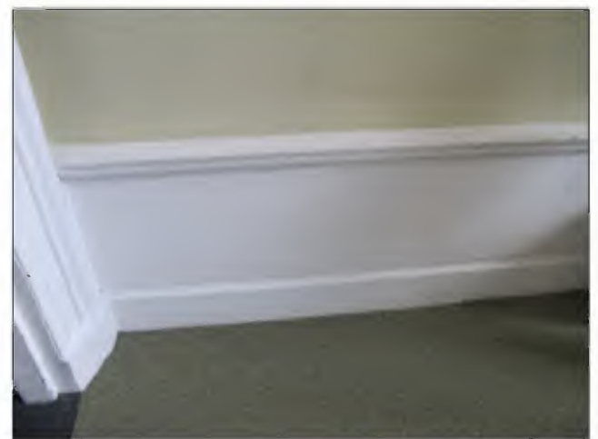
Afb. 3.165: De lambrisering in 10.1.b Wob (N 50, categorie 2-B) is later afgetimmerd met moderne platen.
