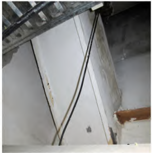
Afbeelding 4.28. Horizontaal kanaal voor de afvoer van warme lucht (van vertrek naar corridor) boven het voormalige privaat P4, 10.1.b Wob
