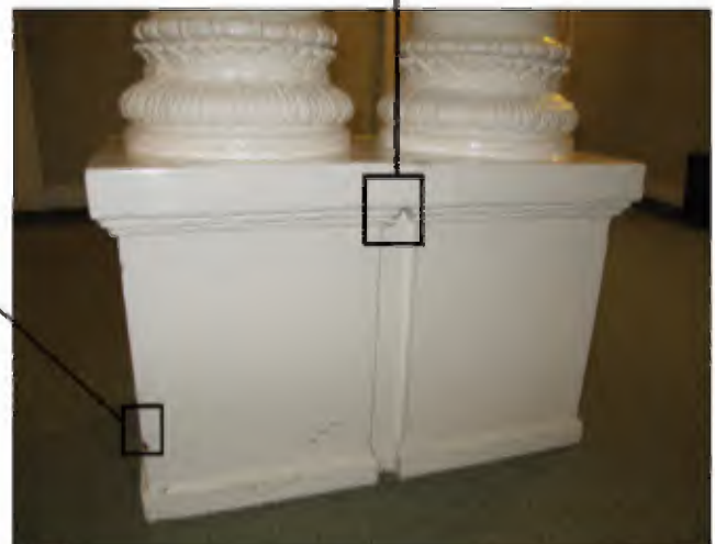
Afb.3.177 t/m 3.179 De voetstukken onder de kolommen in gang (10.1.b Wob) zijn opvallend vlak en gesloten qua afwerking (afb. 3.179). Toch lijken de voetstukken wel te bestaan uit gietijzer (zie afb. 3.178), net als de kolommen zelf. Het teruggelegen, bovenin getrapte, verbindingsstuk tussen de twee voetstukken sluit niet mooi aan (afb. 3.176). Hierdoor rijst de vraag of dit een latere toevoeging betreft en of er dus vroeger een kleine open ruimte tussen de twee voetstukken zat. Nader (d.w.z. licht destructief en/of kleurhistorisch) onderzoek is nodig om vast te stellen of de voetstukken oorspronkelijk zo'n vlak en gesloten uiterlijk hadden als tegenwoordig.
