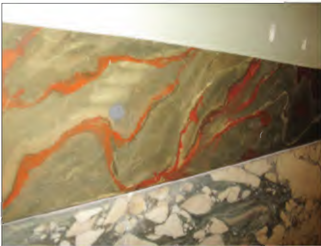
Afb. 3.139: De houten reparatiestukken met marmerimitatie lichten groen op in de flits van de fotocamera. In het echt is het kleurverschil niet zó goed waar te nemen.
