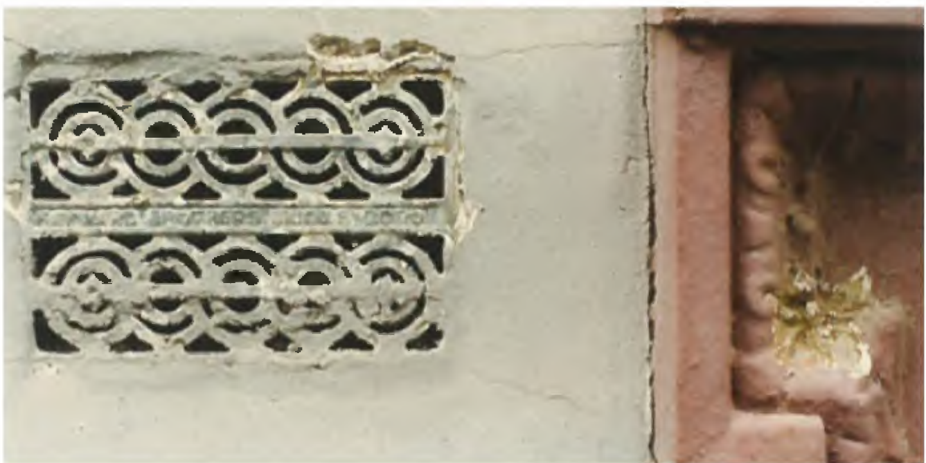
Afbeelding 4.42. Rooster uit 1859 t.p.v. de ventilatie van de spouw op de eerste verdieping (Rijksgebouwendienst/Bureau Rijksbouwmeester 1996, 35)
