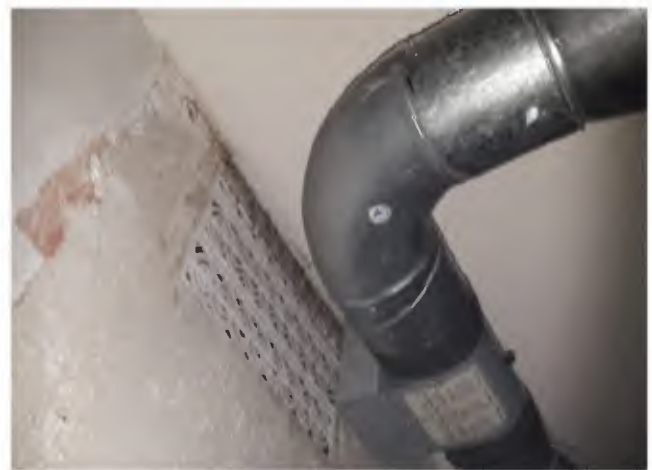
Afbeelding 4.31. Ventilatiestrooster uit 1859 tussen het huidige vertrek 10.1.b Wob en de naastgelegen gang, uitkomend in het gangplenum
