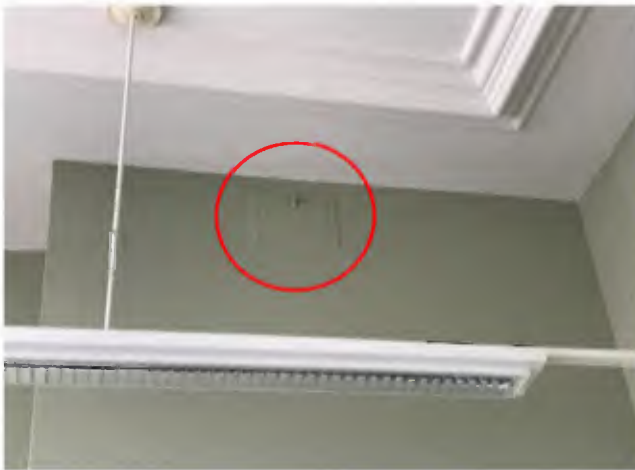
Afbeelding 4.25. Ventilatieklep voor de afvoer van warme, bedorven lucht of de aanvoer van verse lucht, van en naar de holle wendellijst in de buitengevel, in vertrek 10.1.b Wob
