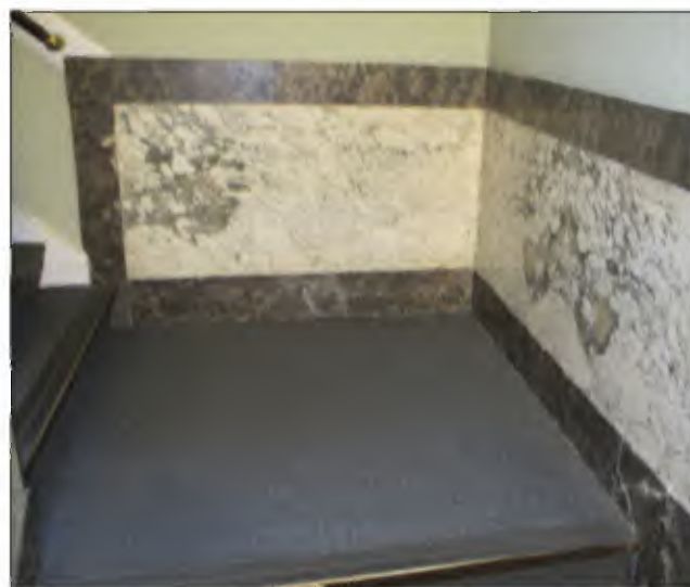
Afb. 3.143: Aansluiting van het eerste bordes op de houten trap. Hier is in de lambrisering wel Livre Ouvert toegepast aan de rechterzijde, maar niet in de hoek?
