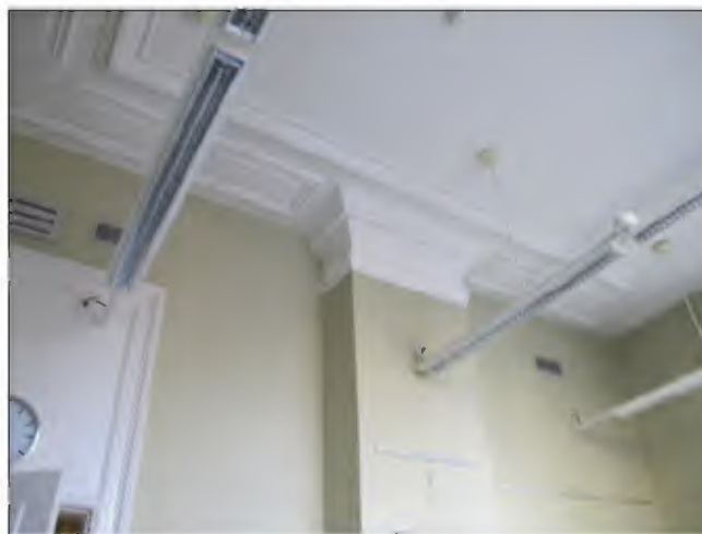
Afb. 3.121: Het plafond van 10.1.b Wob, een kantoorvertrek uit ca. 1895, recht omhoog gefotografeerd. Het plafond is symmetrisch versierd met divers vlakken met geprofileerde perklijsten en houdt netjes rekening met de schouw.
