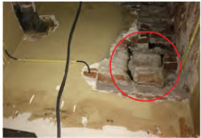
Afbeelding 4.29. De aftekening van een inmiddels dichtgezette doorvoer voor het oorspronkelijke horizontale luchtkanaal tussen vertrek en corridor ter plaatse van het huidige vertrek 10.1.b Wob
