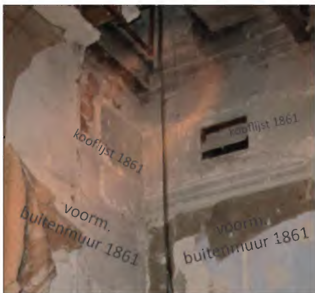
Afb. 3.122: Restanten van de oorspronkelijke kooflijst uit 1861 op de voormalige buitenmuur van het vroegere vertrek N 36.
