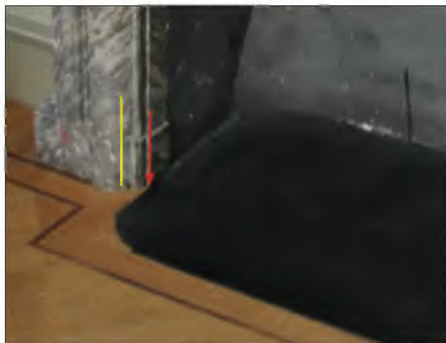
Afb. 3.129: Foto op dezelfde plek 10.1.b Wob anno 2021. Let op de aansluiting van de haardplaat op de schouwmantel. Die is verschoven naar de plek van de rode pijl, omdat er een kleinere haardplaat geplaatst is. De donkere bies in het parket houdt rekening met deze nieuwe, kleinere haardplaat. Dit betekent dat behalve de haardplaat ook het parket van ná 1948 moet dateren (vermoedelijk uit 1997, bouwfase 12)
