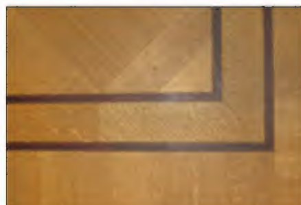
Afb. 3.130, afb. 3.131 en afb. 3.132. Het parket in de voormalige sg kamer 10.1.b Wob lijkt op dat in de voormalige ministerskamer 10.1.b Wob en zal vermoedelijk eveneens uit bouwfase 12 dateren. Het nieuwe parket ligt 'flush' met de deurdorpel (dank aan 10.2.e Wob voor deze term), en dat duidt op een latere ophoging van de vloer, omdat normaalgesproken de dorpel boven de vloer uitsteekt. Dit betekent overigens dat er onder de nieuwe parketlaag mogelijk nog een oudere vloer ligt, die men niet heeft willen verwijderen.
