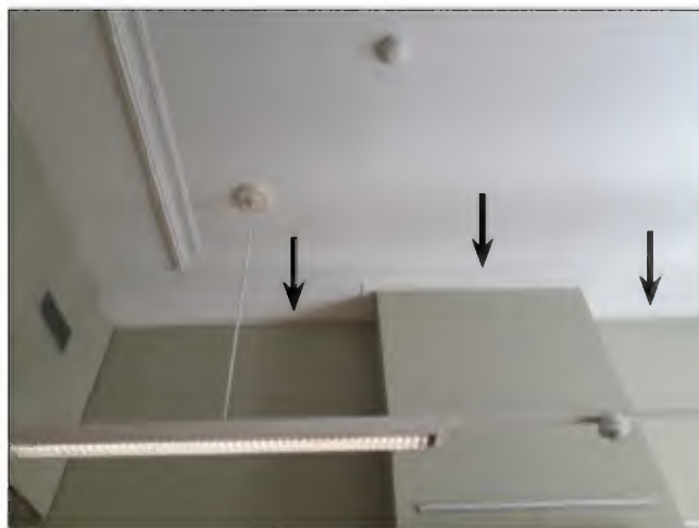
Afb. 3.120: Er is onduidelijkheid over de datering van de geprofileerde perklijsten. De platte perklijst, die de schoorsteen netjes volgt, is in ieder geval een oorspronkelijke plafonduafwerking van dit kantoorvertrek uit 1883.
