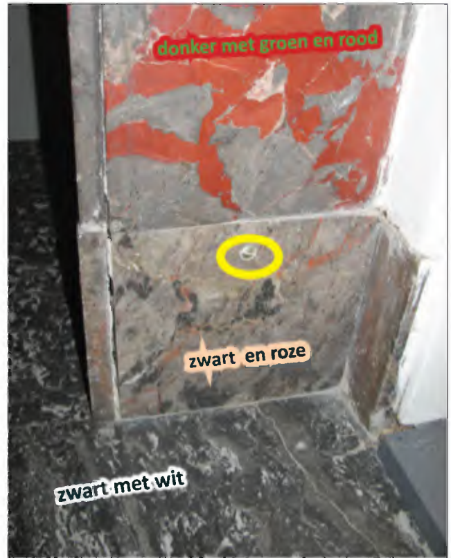
Afb.3.140: Opvallend veel verschillende marmersoorten en - kleuren. Het zwart met roze stuk marmer is ooit met een schroef (her?) bevestigd (zie gele cirkel).
