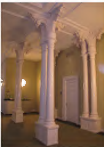
Afb.3.177 t/m 3.179 De voetstukken onder de kolommen in gang (10.1.b Wob) zijn opvallend vlak en gesloten qua afwerking (afb. 3.179). Toch lijken de voetstukken wel te bestaan uit gietijzer (zie afb. 3.178), net als de kolommen zelf. Het teruggelegen, bovenin getrapte, verbindingsstuk tussen de twee voetstukken sluit niet mooi aan (afb. 3.176). Hierdoor rijst de vraag of dit een latere toevoeging betreft en of er dus vroeger een kleine open ruimte tussen de twee voetstukken zat. Nader (d.w.z. licht destructief en/of kleurhistorisch) onderzoek is nodig om vast te stellen of de voetstukken oorspronkelijk zo'n vlak en gesloten uiterlijk hadden als tegenwoordig.
