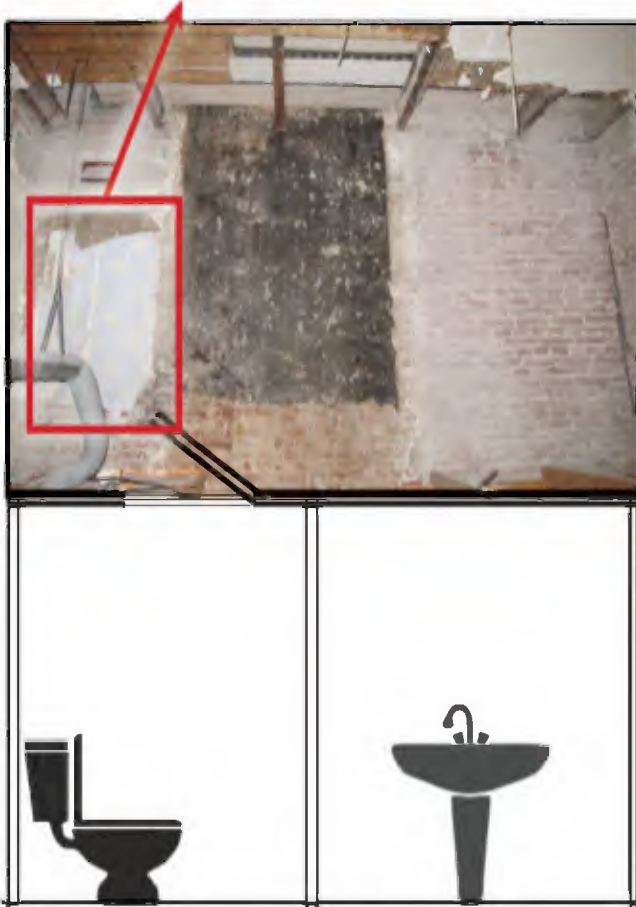
Afb. 3.194: In de loze ruimtes boven de toiletblokken uit 1979 (zie bouwfase 10) zijn oude behangresten aanwezig, die men gewoon heeft laten zitten, omdat ze toch uit het zicht zijn. Foto boven het noordelijke toiletblok op de 1e verdieping (Bron: Bureau Bouwtijd).
