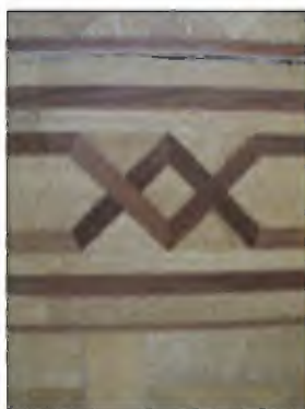
Afb. 3.133, afb. 3.134 en afb. 3.135: De datering van het parket in de Regentenkamer 10.1.b Wob is niet zeker, maar waarschijnlijk 1898 (bouwfase 5). Het parket loopt namelijk door onder de lambrisering uit dat jaar. (Als het uit de oorspronkelijke bouwtijd van 1861 zou stammen, zouden er nog (dichtgezette) ventilatieroosters in de vloer te zien moeten zijn (zie Hfd. 4 Klimaatinstallaties).
