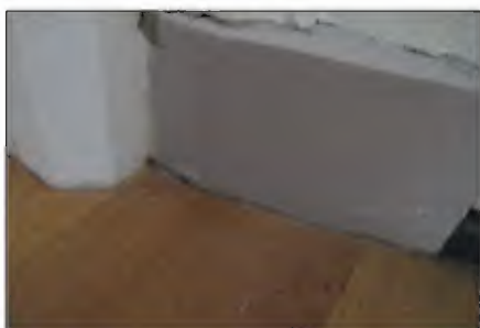
Afb. 3.130, afb. 3.131 en afb. 3.132. Het parket in de voormalige sg kamer 10.1.b Wob lijkt op dat in de voormalige ministerskamer 10.1.b Wob en zal vermoedelijk eveneens uit bouwfase 12 dateren. Het nieuwe parket ligt 'flush' met de deurdorpel (dank aan 10.2.e Wob voor deze term), en dat duidt op een latere ophoging van de vloer, omdat normaalgesproken de dorpel boven de vloer uitsteekt. Dit betekent overigens dat er onder de nieuwe parketlaag mogelijk nog een oudere vloer ligt, die men niet heeft willen verwijderen.
