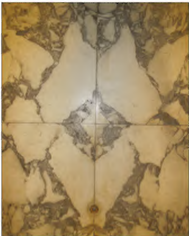
Afb. 3.129: De vloer voor in het voorste gedeelte van de vestibule bestaat uit marmeren vloerplaten in dubbele Livre Ouvert ligging. De adering is zeer opvallend.
