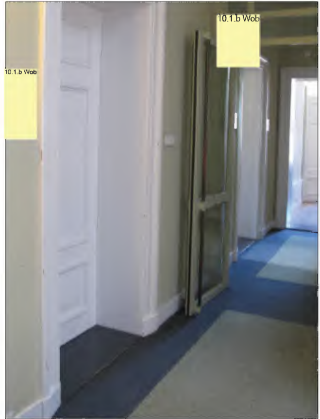
Afb. 3.137: Foto op vermoedelijk dezelfde plek als afb. 3.204, namelijk de noordelijke zijgang (10.1.b Wob, waarbij de foto genomen is richting de voormalige Ministerskamer (10.1.b Wob)). Tegenwoordig ligt er tapijt in de gang, dat is vastgelijmd op een onderplaat. De oorspronkelijke vloer kan daarom alleen bekeken worden door middel van destructief onderzoek. Dit wordt geadviseerd uit te laten voeren als aanvulling op dit cultuurhistorisch onderzoek.
