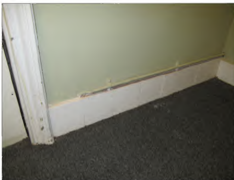
Hier vloer verhoogd in 1953. Mogelijk hier nog de marmertegels onder? Alleen destructief onderzoek kan daar uitsluitsel over geven.
