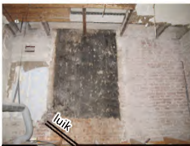
Afb. 3.122: Restanten van de oorspronkelijke kooflijst uit 1861 op de voormalige buitenmuur van het vroegere vertrek N 36.
