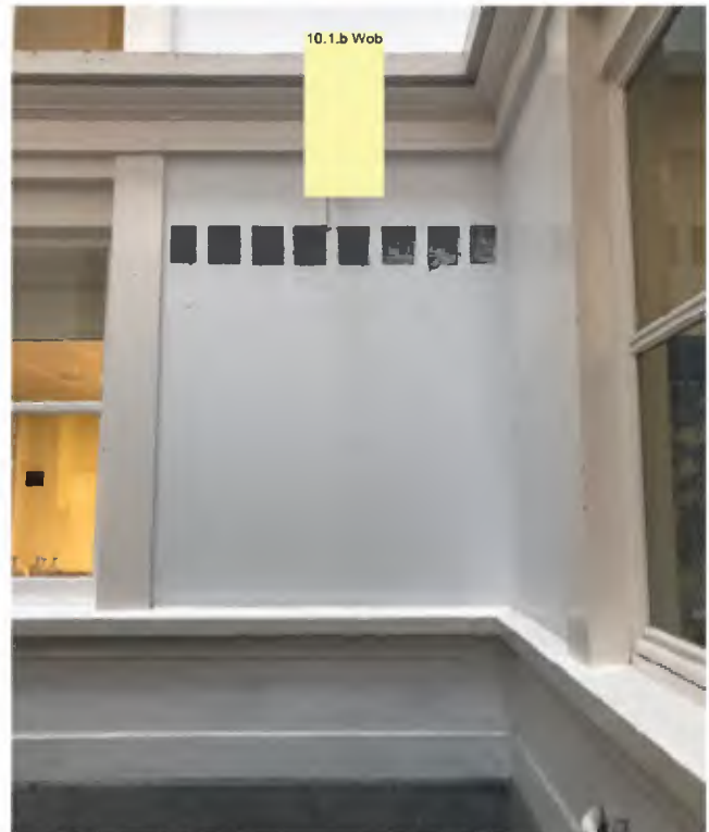
Afbeelding 4.22. De oorspronkelijke aanvoeropeningen voor verse lucht in de noordoostgevel van de noordelijke binnenhof
