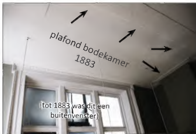
Afb. 3.119: Aan het verloop van de platte perklijsten valt de voormalige aanwezigheid van een bodekamer in de uitbreiding uit 1883 te zien, achter het oorspronkelijke centrale trappenhuis uit 1861 (vgl. afb. 2.109).
