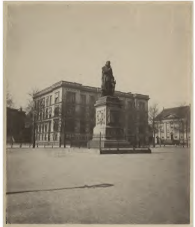
Afbeelding 4.20. Het Ministerie van Koloniën, gezien vanaf het Plein, in 1864. Alle schoorstenen op het dak behoren tot de oorspronkelijke situatie en waren reeds ingetekend op de bestektekeningen uit 1859 (Haags Gemeentearchief, documentnummer 056453)
