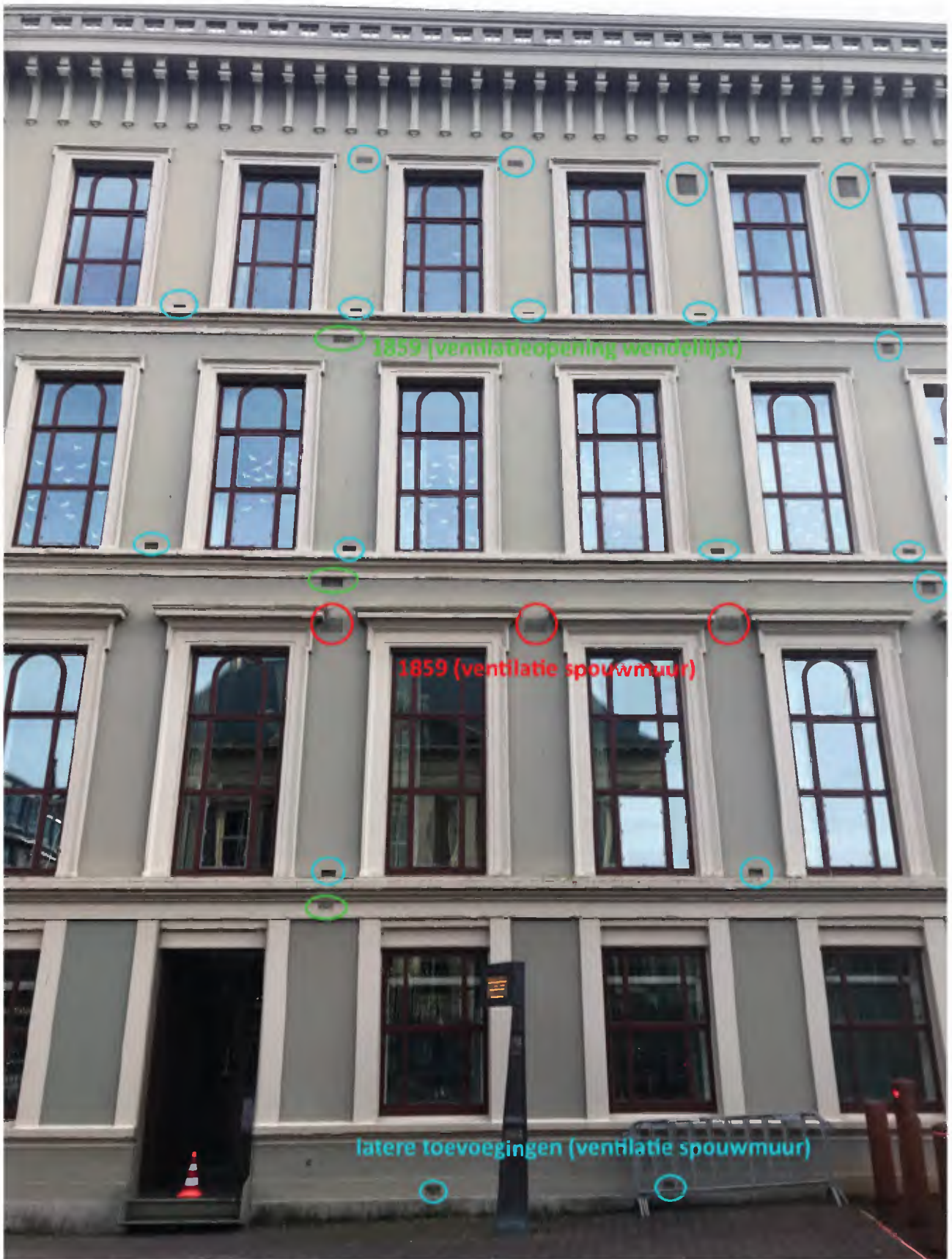
Afbeelding 4.43. Overzicht en datering van de verschillende ventilatieroosters in een gedeelte van de noordwestgevel, bouwdeel 1859. Voor de overige gevels van het oorspronkelijke bouwdeel gelden dezelfde principes
