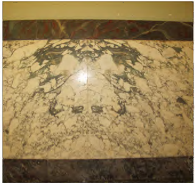
Afb. 3.125: Deel van de lambrisering met Livre Ouvert.
