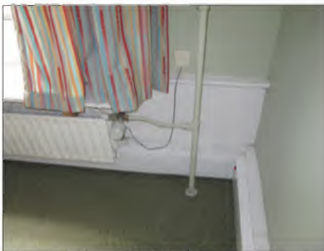
Afb. 3.166: De strokenlambrisering in 10.1.b Wob (N 61, categorie 3-B) is bijna geheel verwijderd. Het resterende deel is afgetimmerd.
