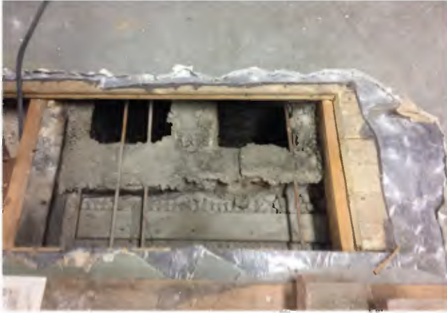
Afbeelding 4.24. Oorspronkelijke luchtkanalen, n.a.v. destructief onderzoek, gezien vanaf de zoldervloer (foto WDJA/10.2.e Wob)
