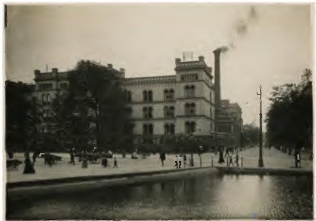
Afb. 4.1: Voorgevel van het corridorgebouw van het Coolsingelziekenhuis aan de Coolsingel te Rotterdam, met rechts de Van Oldenbarneveldtstraat, omstreeks 1908-1912 (Bron: Stadsarchief Rotterdam, ID-nr. NL-RtSA_4202_XIX-17-03)
