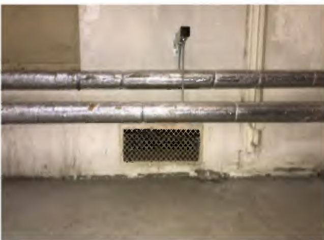
Afbeelding 4.26. Ventilatioerooster voor de afvoer van warme, bedorven lucht naar de zolderverdieping
