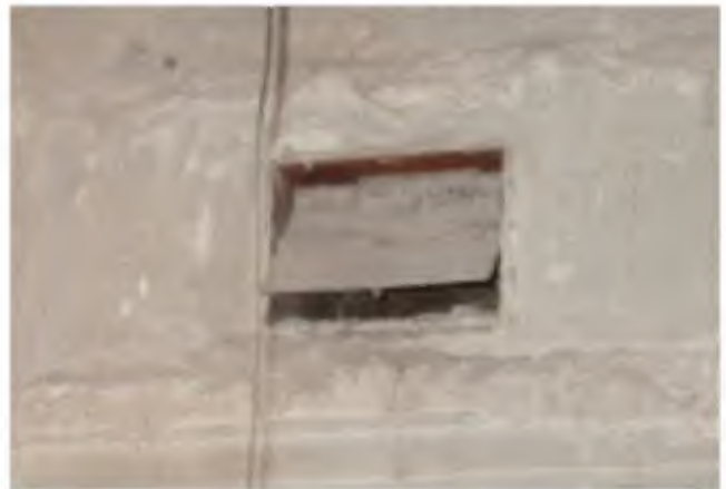
Afbeelding 4.30. Ventilatieklep nog aanwezig boven het plafond van de huidige herentoiletten op de eerste verdieping, op de bestektekening uit 1859 ruimtenummer 36. Vermoedelijk is deze ooit vervangen, omdat de vormgeving van de klep afwijkt van ventilatiekleppen elders in het gebouw
