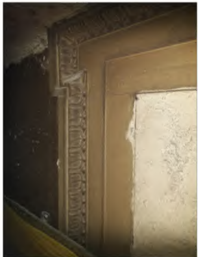
Afb. 3.9: Omlijsting van een van de oorspronkelijke vensters uit 1859 achter een voorzetwand in ruimte 10.1.b Wob
