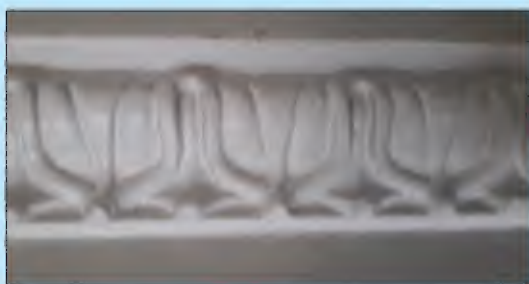
Afb. 3.79: Detail van de gietijzeren vensteromlijstingen, waarvan de eierlijsten ook zijn afgeleid van bladeren.
