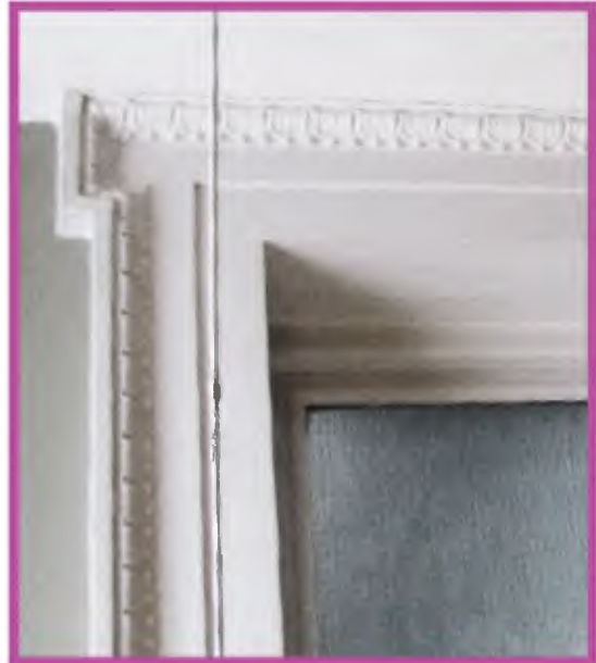
Afb. 2.114: Eierlijst van het gehandhaafde venster op de 2e verdieping 10.1.b Wob
