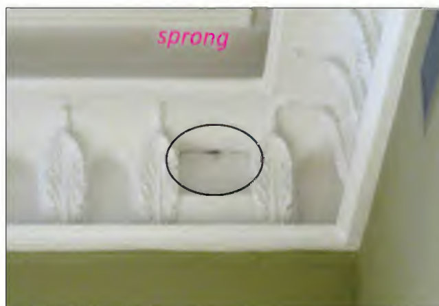
Afb. 3.71 De met rechtopstaande bladeren verbijzonderde hoge kooflijst in vertrek N 32 (10.1.b Wob), waarin nog een ventilatieklepje aanwezig is. Helemaal bovenin deze afbeelding is overigens nog een smal kraalprofiel aan het plafond te zien.
