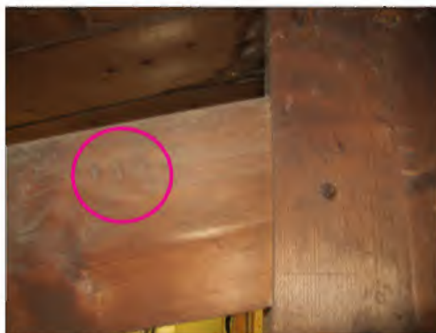
Afb. 3.27: Opvallend genoeg heeft de houten kap uit 1883 telmerken (II en III, maar geen telmerk I gevonden). Doorgaans stammen telmerken uit een veel eerdere tijd, nl. de 16e cf 17e eeuw, maar dit is dus een zeer laat voorbeeld.
