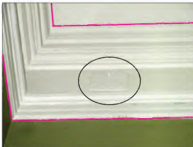
Afb. 3.65: Detail van een oorspronkelijke kooflijst op de 1e verdieping in ruimte 10.1.b Wob , met in de bandbreedte een oud ventilatieklepje.
