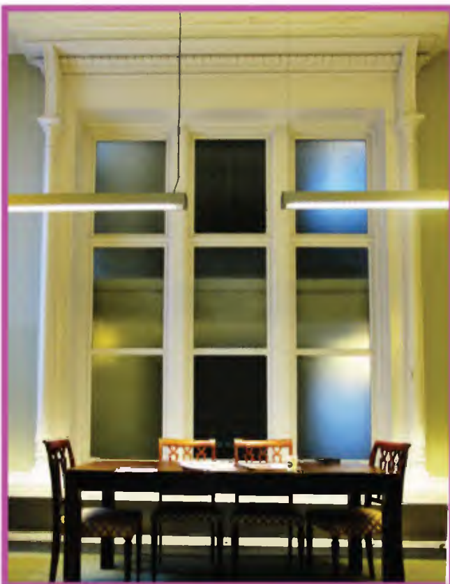
Afb. 2.113: Voormalige buitenmuur van het centrale trappenhuis, met het daarin gehandhaafde buitenvenster op de 1e verdieping 10.1.b Wob
