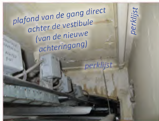
Afb. 3.61: Het plafond van de gang direct achter de vestibule, dus de 'iets chiquere gang' kreeg ook een plat perklijstje.
