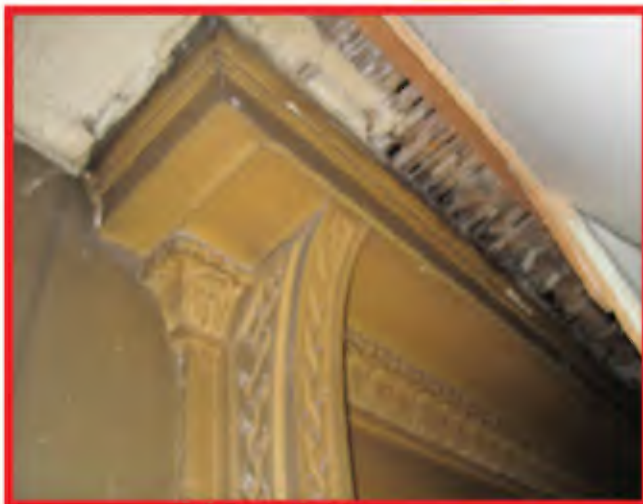
Afb. 2.118: Architraaf van een verborgen, maar (in ieder geval deels) gehandhaafd, venster op de 1e verdieping 10.1.b Wob).
