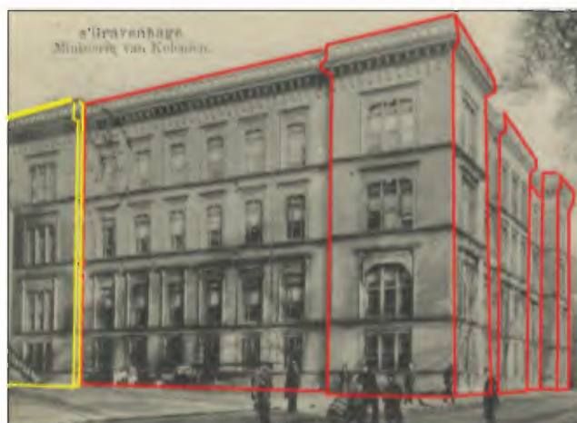
Afb. 2.124: Foto uit 1904 van de linker zijgevel, met aangegeven het oorspronkelijke bouwvolume (rood) en de uitbreiding uit 1895 (geel). Door de uitbreiding heeft het gebouw zowel aan de voor- als aan de achterzijde risalerende hoeken (Bron: HGA, fotograaf onbekend, 5.18852, ca. 1904).
