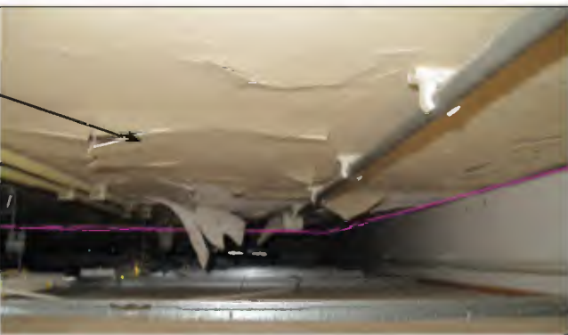
Afb. 3.31: Plafond met perklijst (roze) op de 3e verdieping Afb.3.32: Plafond met perklijst (roze) op de 2e verdieping Afb. 3.33: Plafond met perklijst (roze) op de 1e verdieping Afb. 3.34: Vlak plafond op de begane grond.
