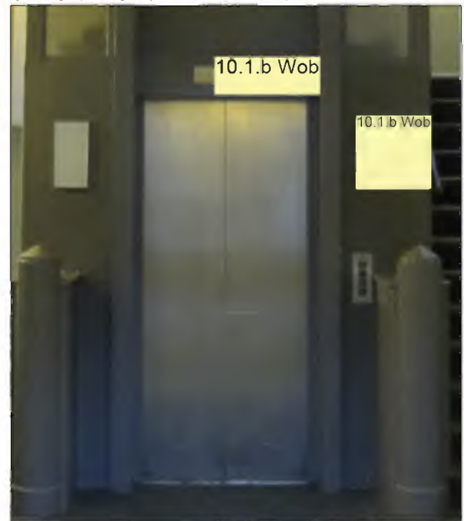
Afb. 2.279: Foto van de huidige situatie van de lift en een van de liftopeningen uit 1954 (NB lift is sinds 1954 nogmaals vervangen).
