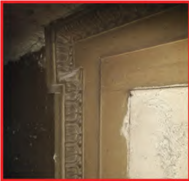
Afb. 2.117: Eierlijst van een verborgen, maar (in ieder geval deels) gehandhaafd, venster op de 2e verdieping 10.1.b Wob).
