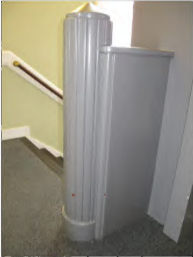
Afb. 2.277: Een van de teakhouten kolommetjes uit 1954 voor de lift. De kolommetjes, platen en liftschacht zijn later overgeschilderd.
