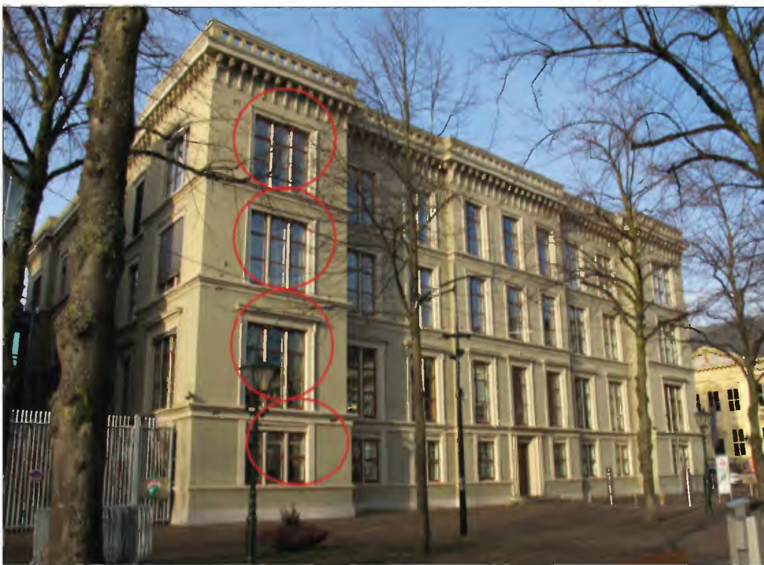
Afb. 3.18:: De voorgevel in 2021. De aluminium ramen zijn bij de renovatie in de jaren '80 aangebracht
