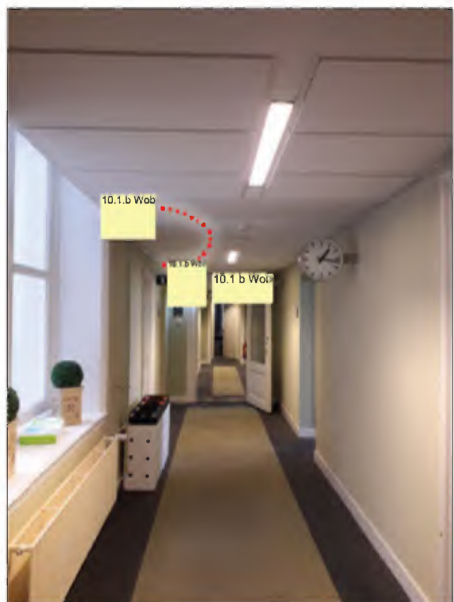
Afb. 3.43: Vanwege het systeemplafond uit 1997 is het plaatselijke hoogteverschil van het plafond dat er was vanwege de vroegere achteringang niet te zien in het noordelijk deel van gang 10.1 b Wob .
