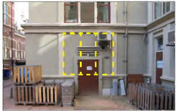
Afb. 2.294: In 1960 is ter plaatse van een venster in het noordelijke uitbreidingsdeel van 1895 een deur gemaakt, om de nieuwe 10.1.b Wob erachter te ontsluiten.
