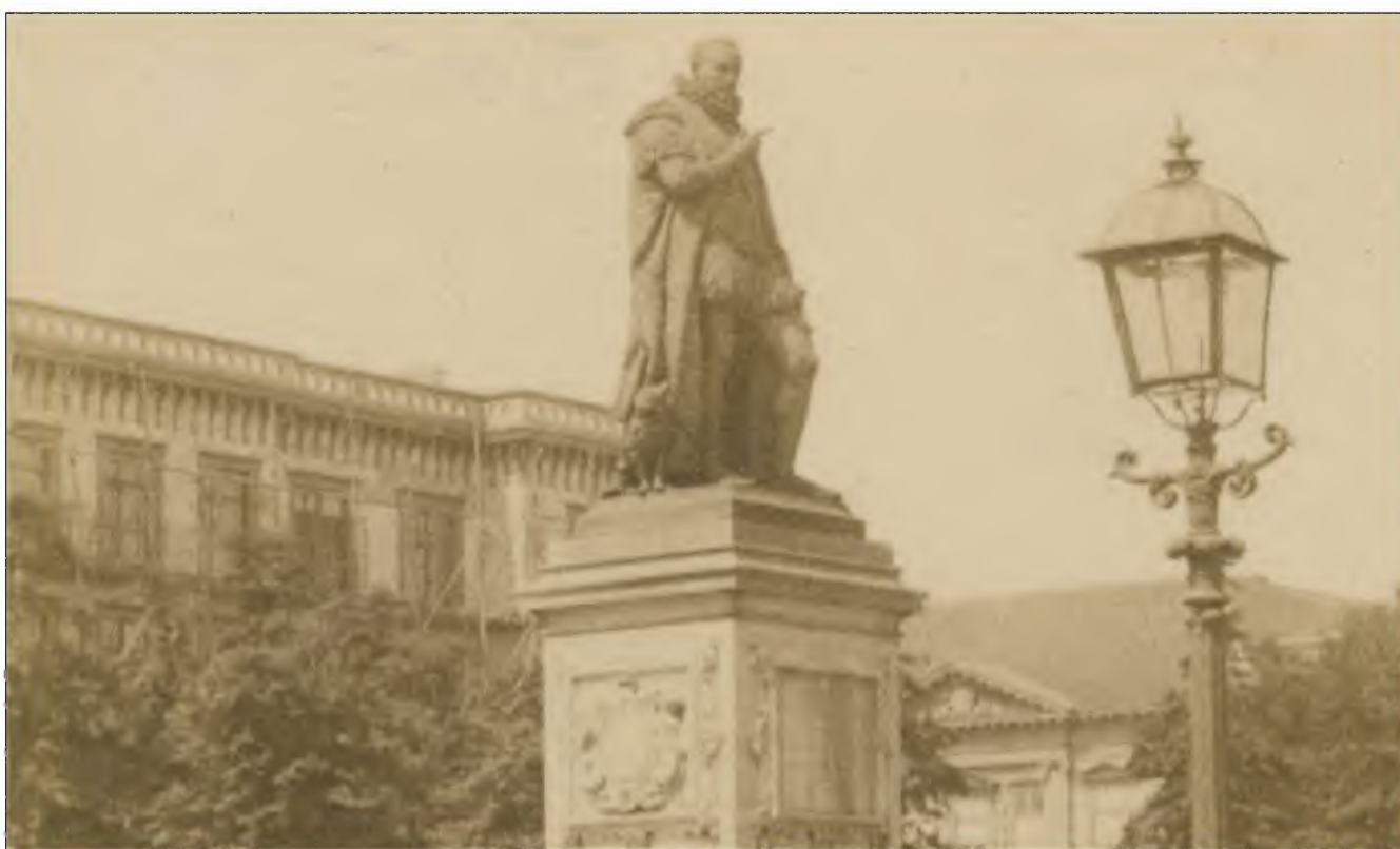
Afb. 3.11: De voorgevel aan het Plein omstreeks 1861 (uitsnede), hoewel de aanwezigheid van de steigers tevens aanleiding kan geven om de foto te dateren in 1873, op het moment dat de gietijzeren ramen werden vervangen door houten exemplaren (bron: Haags Gemeentearchief, inv. nr. 1010856))
