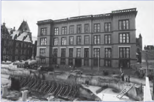
Afb. 2.28. Foto van de aanleg van een parkeergarage onder het Plein. Bron: NA, H. van Dijk / Anefo, 1980. toeg.nr. 2.24.01.05, bestandnr. 930-9441.
