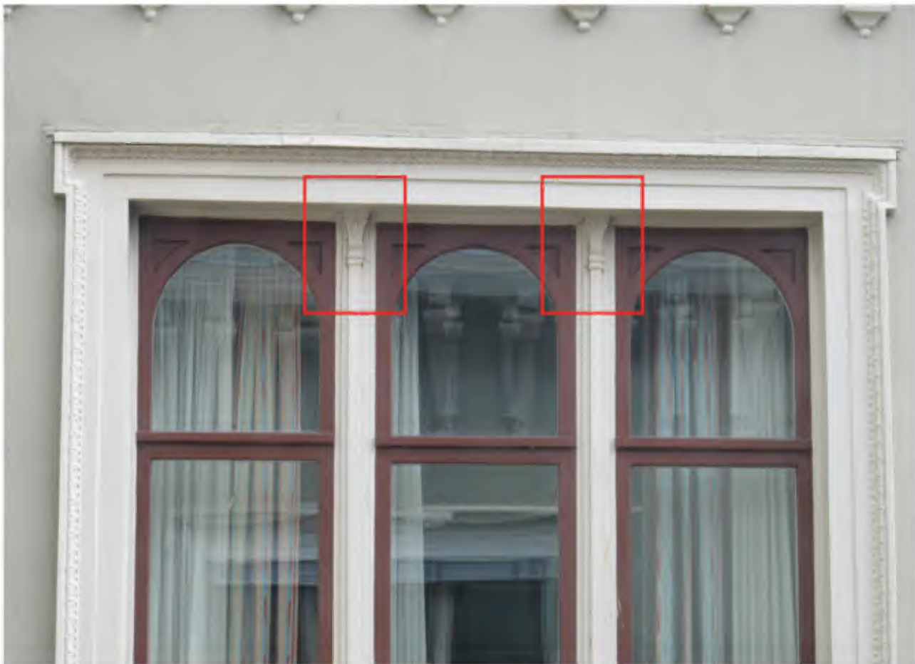
Afb. 3.20: Op sommige plekken resteren de oorspronkelijke kapitelen bovenin de stijlen, hier een foto van het bouwdeel uit 1895
