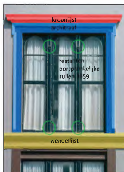
Afb. 3.1: Aanduidingen van de verschillende onderdelen van de vensters, foto gemaakt in 1981 (bron: RCE, inv. nr. D-050608, bewerking 10.2 e Wob)
