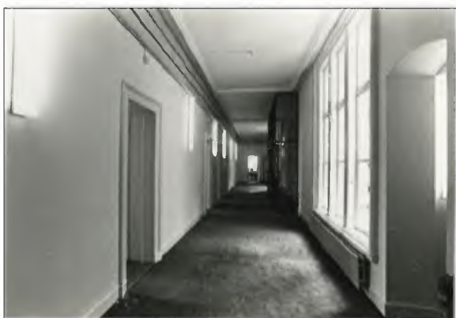
Afb. 2.301: Foto van de gang op de 2e verdieping, die net gerenoveerd is (10.1.b Wob). Goed te zien is de forse glazen 10.1.b Wob die tussen de gang en het hoofdtrappenhuis is aangebracht. Bron: HGA nr. 056467 verwijzend naar Vaderland 12-8-1980, p.9).
