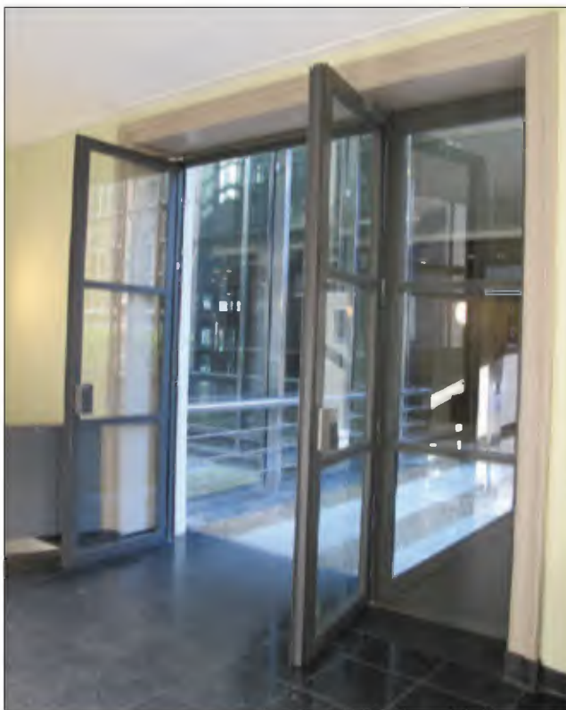
Afb. 2.312: Aansluiting van een van de glazen loopbruggen uit 1991 op de linkerachterzijde van gebouw K. Destijds is een vroeger venster verwijderd t.b.v. het maken van deze doorgang.
