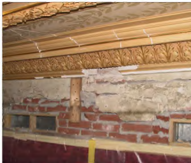
Afb. 2.323: Restauratie van het plafond van de Regentenkamer in 2007. (Bron: RVB, foto graaf onbekend, 2007).
