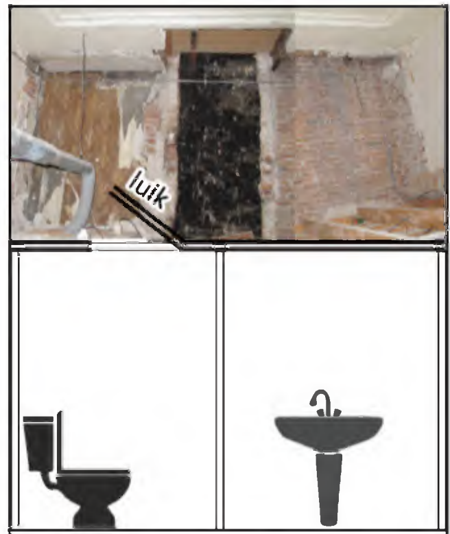
Afb. 2.132: In de loze ruimtes boven de toiletblokken uit 1979 (zie bouwfase 10) zijn afgebroken schoorsteenkanalen met een roetlaag aanwezig van schoorstenen uit 1895. Omdat deze bouwsporen zich boven de ingebouwde toiletblokken bevinden en alleen te zien zijn als men via een luik omhoog klimt, heeft men ze gewoon laten zitten.
