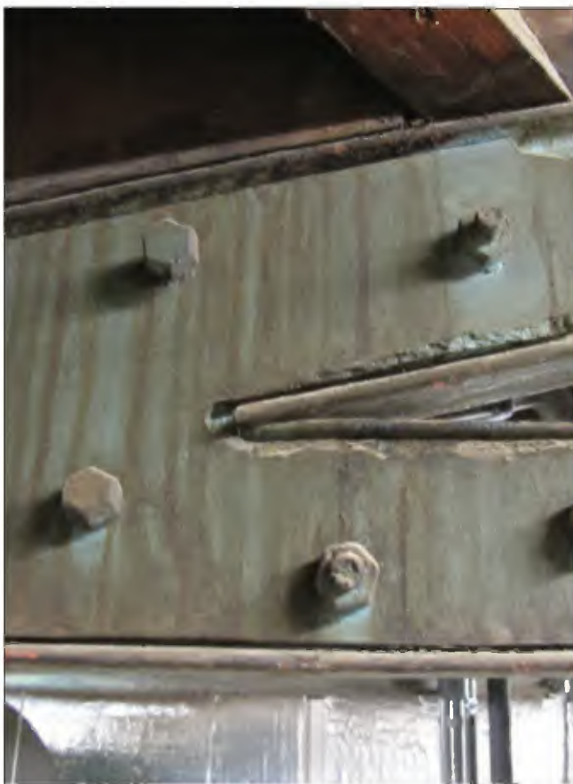
Afb. 3.22 t/m 3.24: Foto's van de oorspronkelijke smeed- en gietijzeren kapconstructie uit 1861, wat een voor die tijd heel modern materiaalgebruik was. Ook de flauwe dakhelling was modern, en bedoeld om het dak vanaf de straat achter de attiek te verstoppen..
