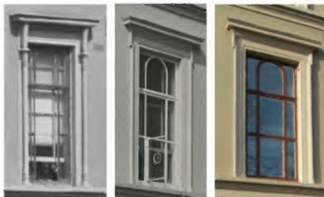
Afb. 2.313: Houten raam uit 1873 (bouwfase 2, NB: niet bouwfase 1!)
