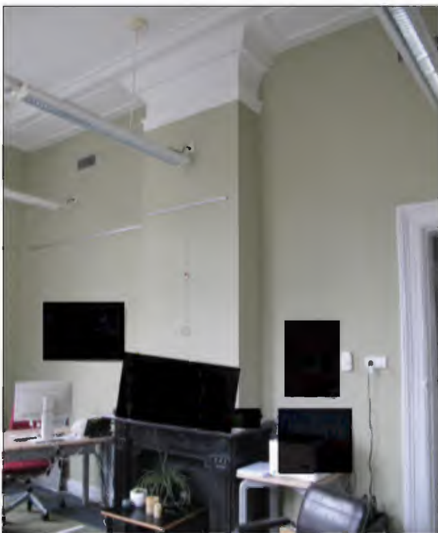
Afb. 2.131: Een in ca. 1895 gemetselde schoorsteen in de uitbreiding van dat toen. De interieurafwerking van deze uitbreiding van was rijker dan die van die van de standaardkantoren uit 1861. Zie bijv. fraaie zwarte marmeren schouw en het plafond met diverse stuclijsten in 10.1.b Wob.
