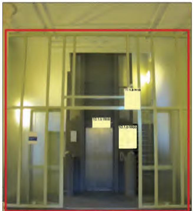
Afb. 2.299: De 10.1.b Wob die in 1979 voor het centrale trappenhuis is aangebracht. 10.1.b Wob houden overigens geen rekening met de perklijsten van het plafonds; ze zijn er dwars doorheen aangebracht.
