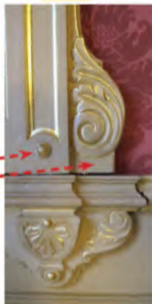
Afb. 2.267: Detail van afb. 2.263 met de gereconstrueerde lijst uit 1932. Zie de subtiele verschillen met de oorspronkelijke lijst!
