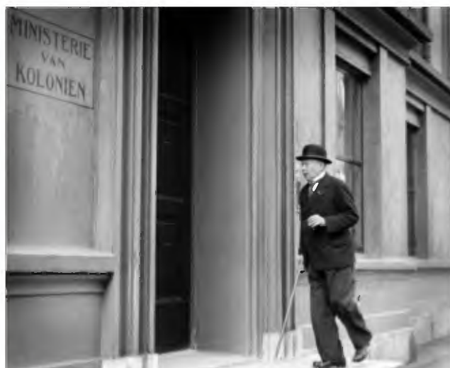
Afb. 2.152 . Bij de renovatie van 1931 is de dubbele voordeur vernieuwd. De nieuwe deuren hebben een strakke panelen zonder frivole decoratie. (Bron: xx, 1935)
