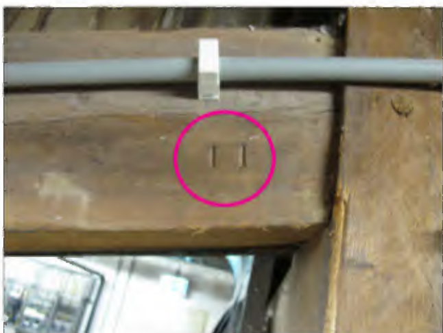
Afb. 3.27: Opvallend genoeg heeft de houten kap uit 1883 telmerken (II en III, maar geen telmerk I gevonden). Doorgaans stammen telmerken uit een veel eerdere tijd, nl. de 16e cf 17e eeuw, maar dit is dus een zeer laat voorbeeld.
