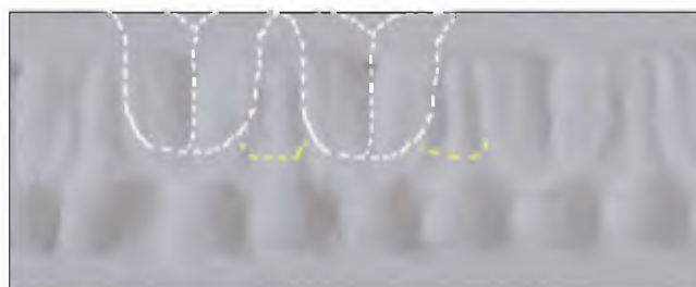
Afb. 3.70: Detail van een van de eierlijsten van de hoge kooflijst in vertrek N 30 (10.1.b Wob). Duidelijk is te zien dat de eierlijst is vormgegeven als twee rijen - in verstek geplaatste - omgevouwen bladeren, en niet als echte 'eieren' en dus voldoet aan Rose's opvattingen omtrent vormgeving van ornamenten.
