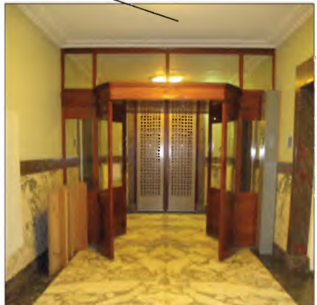
Afb. 3.55 Overzicht van het plafond uit 1931 in het vestibulegedeelte net achter het tourniquet.
