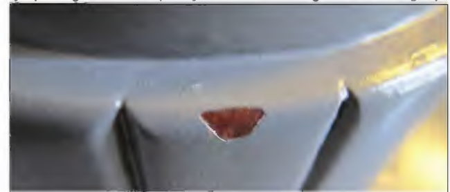
Afb. 2.280: Aan een beschadiging van de later aangebrachte verf is goed de oorspronkelijke taakhouten afwerking van de kolommetjes te zien.
