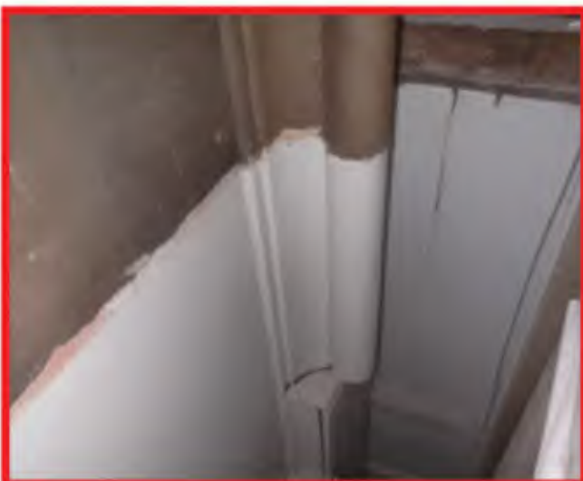
Afb. 2.119: Het basement van het zuiltje is er afgezaagd bij dit verborgen voormalig buitenvenster op de 1e verdieping 10.1.b Wob).
