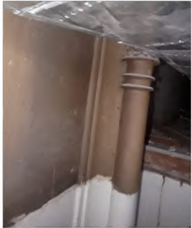
Afb. 3.8: Restant van een gietijzeren kolom en venster uit 1859 achter een voorzetwand in ruimte 10.1.b Wob
