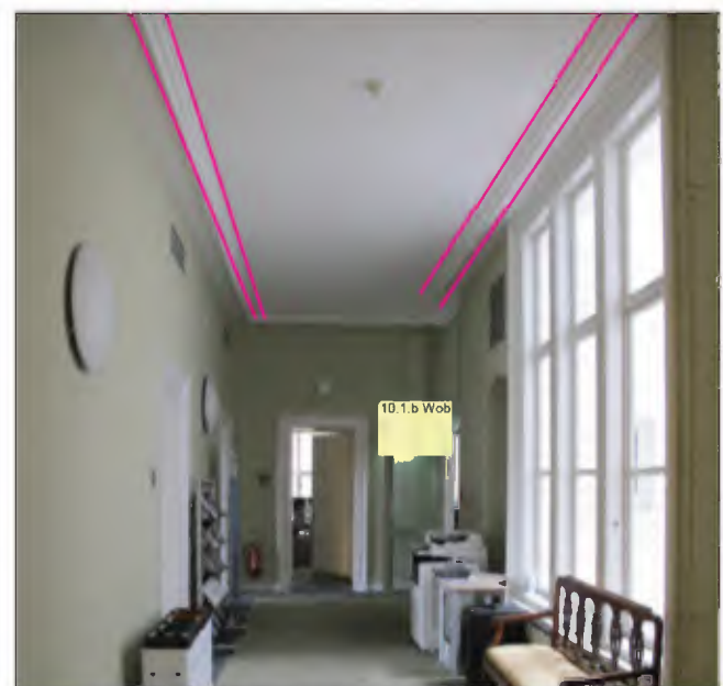
Afb. 3.36 en 3.37: ....maar in werkelijkheid is hier op de verdiepingen een plafondlijst gemaakt (foto in hoofdgang 10.1.b Wob ).
