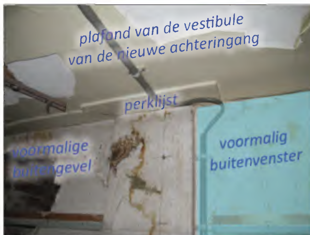
Afb. 3.60: Het voormalige buitenvenster naast de vestibule werd in eerste instantie nog gehandhaafd, om direct zicht te hebben op de vestibule vanuit het nieuwe knechtenverblijf. Het plafond van de vestibule kreeg een plat perklijstje.
