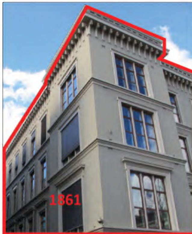
Afb. 2.106: De linker zijgevel en de voorgevel van het oorspronkelijke gebouw van Rose uit 1861.
