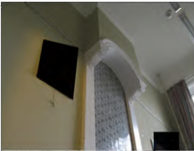
(Linksboven) Afb. 2.97: Voorbeeld van een schouw die na de bouw is toegevoegd, wat zorgvuldig is gedaan, want er zijn in het plafond geen bouwsporen van te zien. Foto in 10.1 b Wob / vertrek N° 27.
