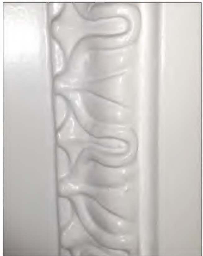
Afb. 3.3: Het decoratieve patroon van twee rijen omgevouwen bladeren langs de architraven van de vensters op de tweede en derde verdieping
