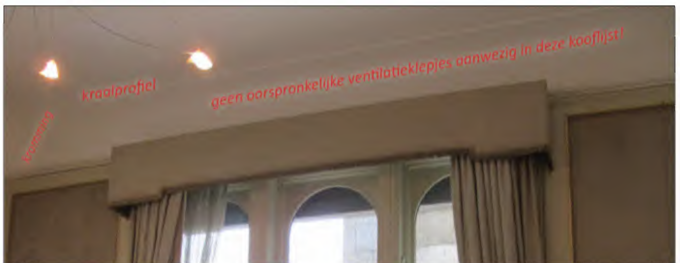
Afb. 3.96. De typische ventilatieklepjes in de bandbreedte van de kooflijst, die behoorden bij het oorspronkelijke klimaatsysteem, ontbreken in vertrek N 25 10.1.b Wob.
