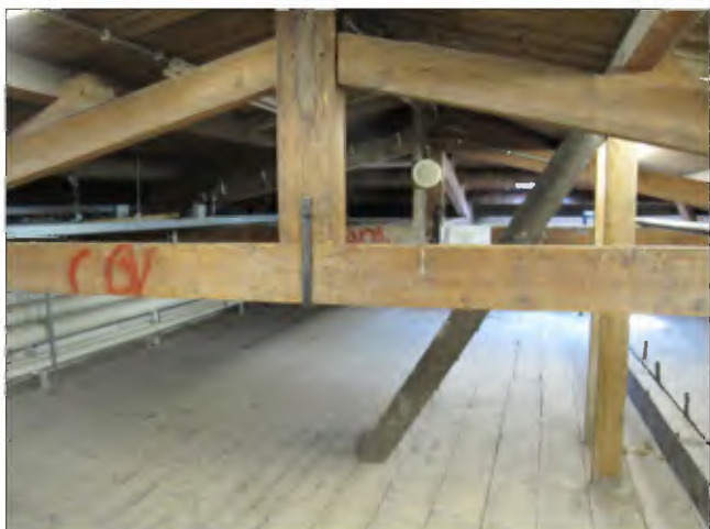
Afb. 3.25 De uitbreiding uit 1883 kreeg een traditionele houten kap.
