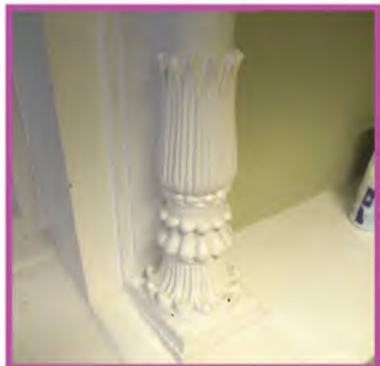
Afb. 2.116: Basement van een zuiltje van het gehandhaafde voormalige buitenvenster op de 1e verdieping 10.1.b Wob
