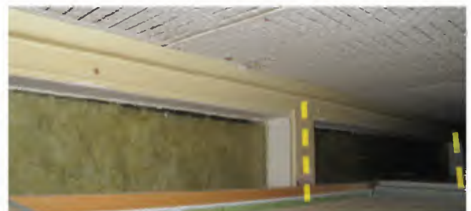
Afb. 2.283: Boven de systeemplafonds is te zien dat de glaswand uit 1956 10.1.b Wob nog bestaat.
