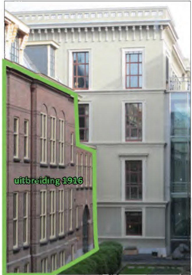
Afb. 2.144: Het verschil in vorm, bouwstijl en materialisatie tussen het gebouw van Rose (en de uitbreidingen van 1883 en 1895) met de uitbreiding uit ca. 1916 (groen aangegeven) is overduidelijk.
