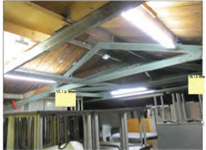
Afb. 2.93: Zolderverdieping met hier op de foto de ijzeren kapconstructie in de noordelijke dwarsvleugel uit 1859.
