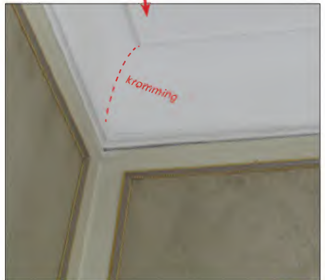
Afb. 3.94. en 3.95. De daadwerkelijk in vertrek N 25 10.1.b Wob aanwezige kooflijst wijkt qua vorm en profileringen sterk af van wat in de doorsnedetekening van het bestek was voorgeschreven.
