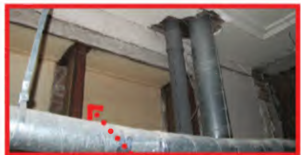
Afb. 2.121: De verborgen voormalige buitenvensters zijn vanaf de achterkant te zien 10.1.b Wob
