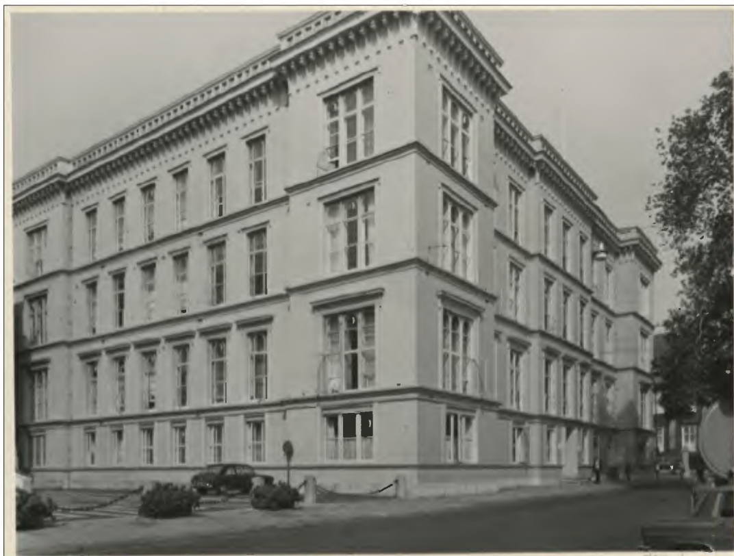
Afb. 3.17: De voor- en rechterzijgevel in 1969. De gietijzeren zuilen, zowel die ter ondersteuning van de architraven als op veel plaatsen de tussenstijlen van de vensters op de bel-etage en de verdiepingen, zijn inmiddels verwijderd. De gietijzeren architraven zijn op alle verdiepingen behouden gebleven, evenals de kroonlijsten op de bel-etage. Ook de buitenste vensters zijn op dit moment nog aanwezig, uitgevoerd in hout (bron: Haags Gemeentearchief, inv. nr. 56472)
