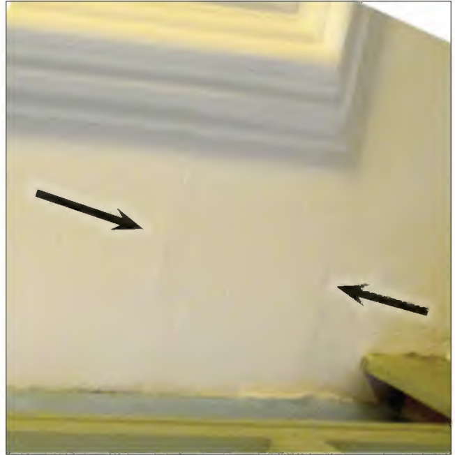
Afb. 3.40: De zwarte pijlen wijzen het bouwspoor van het verwijderde stuk perklijst aan.
