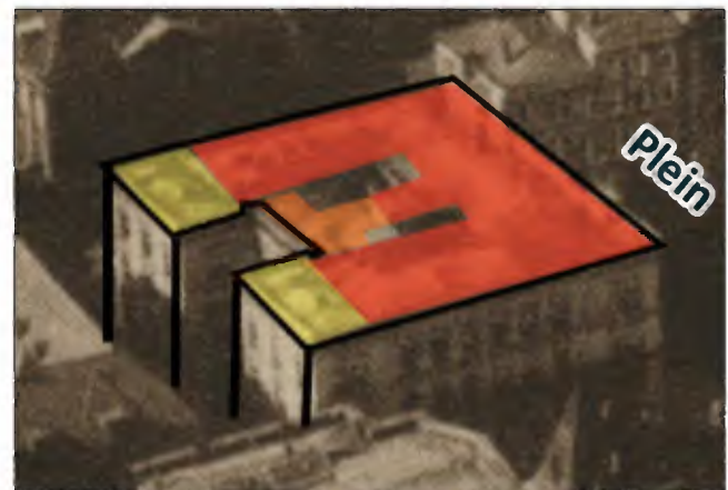
Afb. 2.127: Op dit detail van een luchtfoto is te zien dat het gebouw door de uitbreiding van 1895 weer iets meer een E-vorm heeft gekregen. (Bron:
