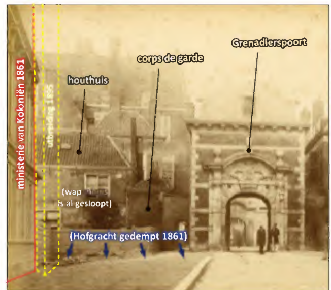
Afb. 2.23. De gebouwen achter het ministerie van Koloniën, vóór de uitbreiding van 1895 (HGA, Foto P. Oosterhuis, 0.10634 ca. 1880).
