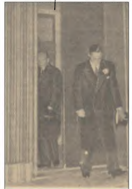
Afb. 3.52: Foto uit 1936, waarop Prins Bernhard het gebouw verlaat. Het plafond met perklijst uit 1931 is net zichtbaar (Bron: Prov. Geld. en Nijm. Courant, 6 nov. 1936).
