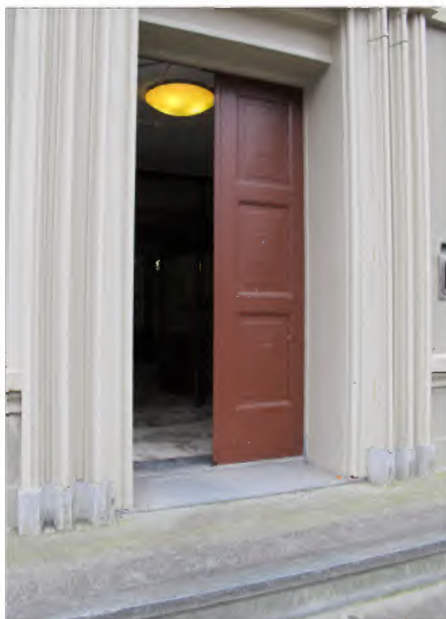
Afb. 2.153: De dubbele voordeuren stammen uit de renovatie van de hofdingang in 1931.
