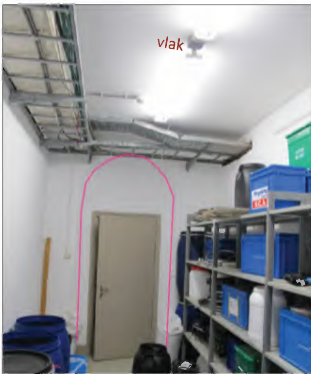
Afb. 3.59: De dichtgezette togen vanuit de voormalige bergplaats voor brandstoffen naar de eenvoudige gang zijn nog herkenbaar. Het plafond van de bergplaats was vlak afgewerkt.
