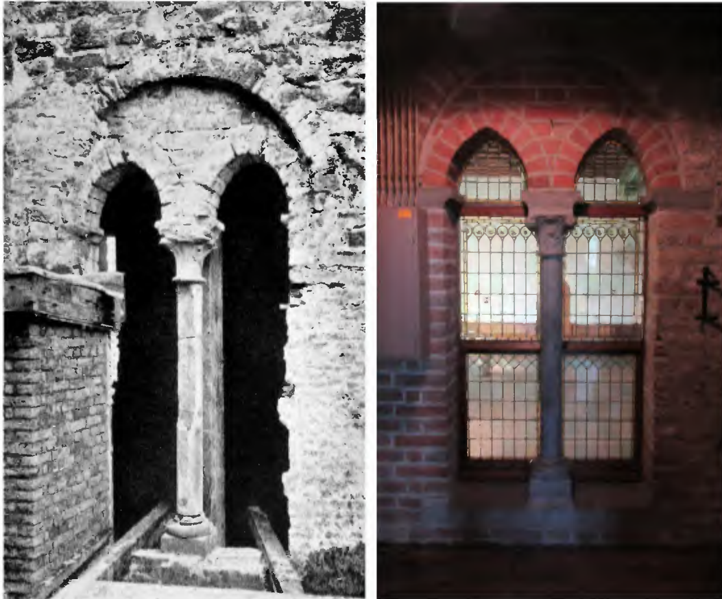
afb. 55 en 56. Links het in 1900 in de westelijke gevel van het Rolgebouw aangetroffen gotische tweelichtvenster uit 1295. Het venster heeft twee spitsboogjes onder een rondboog en is uitgevoerd met een deelzuilje met blaadkelkapiteel. Beeldbank RCE, inv.nr.: 413768. Rechts de huidige situatie van het eveneens in 1900 ontdekte en gerestaureerde tweelichtvenster in de oostgevel van het Rolgebouw.
