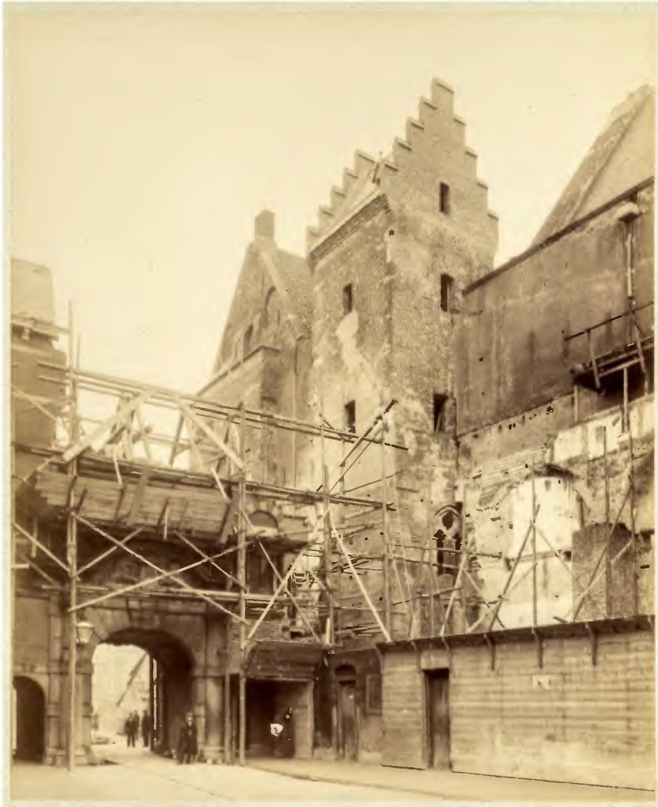
Afb. 1. De met twee trapgevels bekroonde Haagtoren met erachter de trapgevel van het Rolgebouw uit 1250, tijdens de restauratiewerkzaamheden van 1896-1904. Rechts van de Haagtoren de zijgevel van de Grote Zaal uit circa 1295 met de ophoging uit 1861 door rijksbouwmeester Rose. Links van de Haagtoren de Middenpoort. Beeldbank Rijksdienst voor het Cultureel Erfgoed (RCE), inv.nr.: OF-06723.
