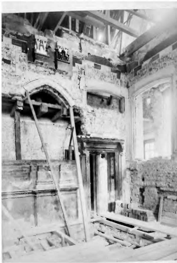
Afb. 85. De De Lairessezaal tijdens de ontmanteling in 1897. Herkenbaar is de top van een spitsboog, uitgevoerd in blokken natuursteen met bloemmotieven. Rechts ervan restanten van natuurstenen vensteromlijstingen. Deze vensters gaven oorspronkelijk zicht op de zaalruimte vanaf de achterliggende galerij. Beeldbank RCE, inv.nr. 031356.
