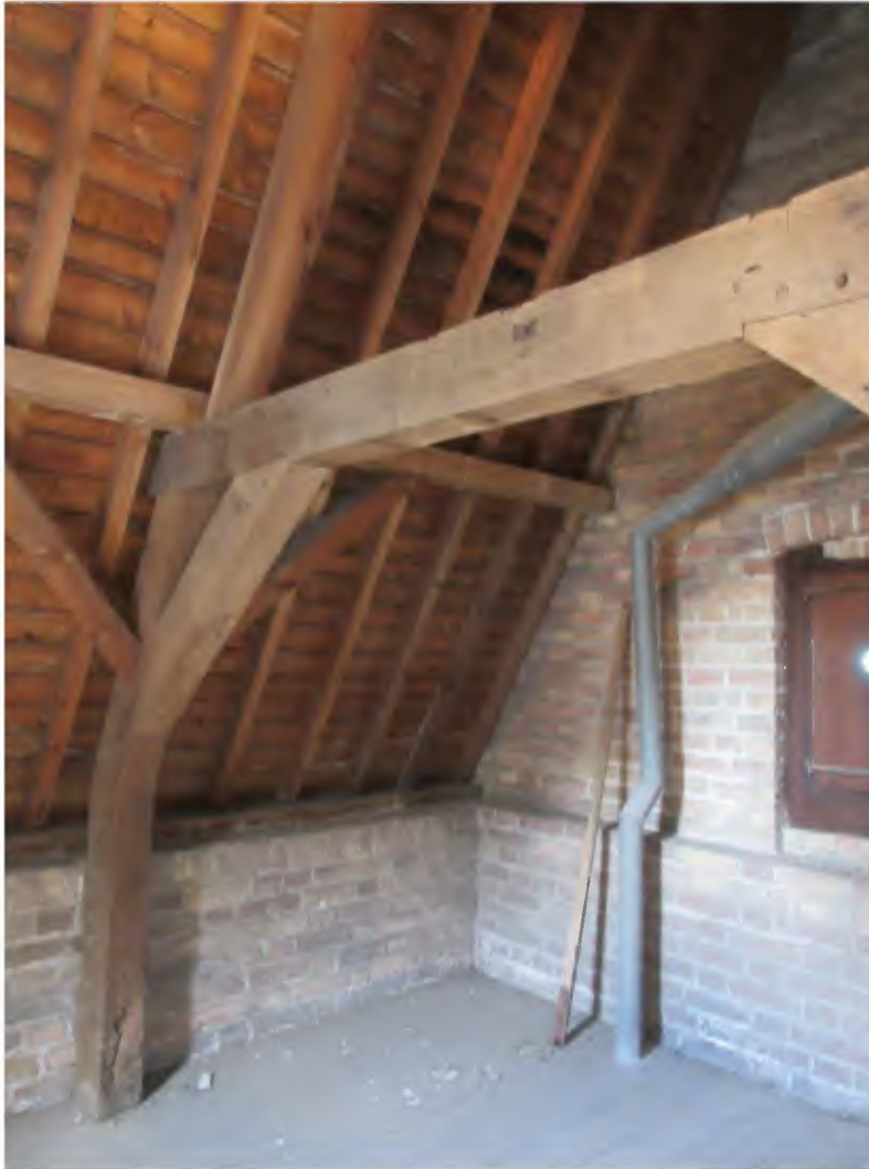
Afb. 52. Zolderruimte van de Haagtoren. De huidige kapconstructie is in grenenhout uitgevoerd en is in 1900 tot stand gekomen, behoudens het in eikenhout uitgevoerde kapspant. Dit met krommers en korbelen uitgevoerde dekbalkjuk heeft gehakte telmerken en stamt vermoedelijk uit de zestiende eeuw. Rechts de oostelijke topgevel met venster.
