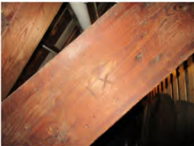
Afb. 50. Detail van het korsbeel van een kerspant van de kapconstructie uit 1758 met het gehakte telmerk 9. Ongebruikelijk is dat het telmerk uitgevoerd is als het Romeinse cijfer IX in plaats van het gebruikelijke telmerk VIII.
