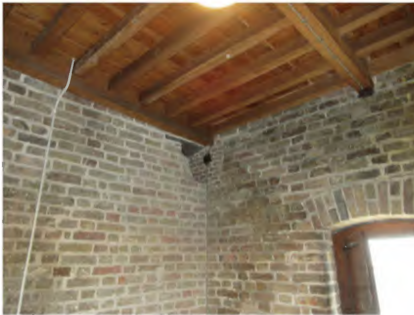
Afb. 51. Het vertrek op de vierde bouwlaag van de Haagtoren. De ruimte wordt afgedekt door een samengestelde grenenhouten balklaag uit 1900. Rechts een oorspronkelijk venster en in de gevelhoek onder de balklaag een met een latei van Doornikse steen afgedekte uitsparing voor een achterwege gelaten kruisribgewelf.
