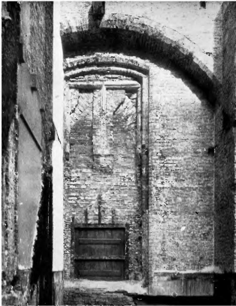
Afb. 63. Tijdens de sloep van de aanbouwen tegen de zuidgevel van de Grote Zaal tijdens de restauratie van 1896-1904, is in een van de traveeën van de gevel een kruisvenster uit 1395 in het zicht gekomen. Beeldbank RCE, inv.nr. 413771.
