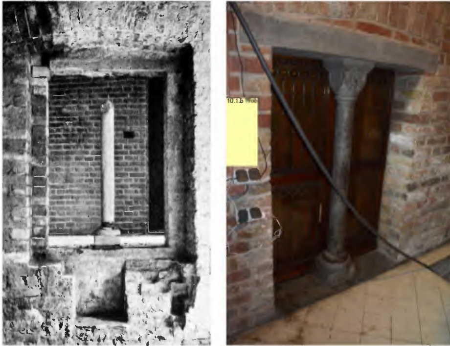
Afb. 34 en 35. Links binnenaanzicht van het tijdens het destructief bouwhistorisch onderzoek vrijgelegde romano-gotisch venster in de oostgevel van het Rolgebouw, tijdens de restauratiewerkzaamheden van 1900. Opname: H.J. Kouwenberg, beeldbank RCE. Rechts huidige situatie van het venster (buitenzijde).
