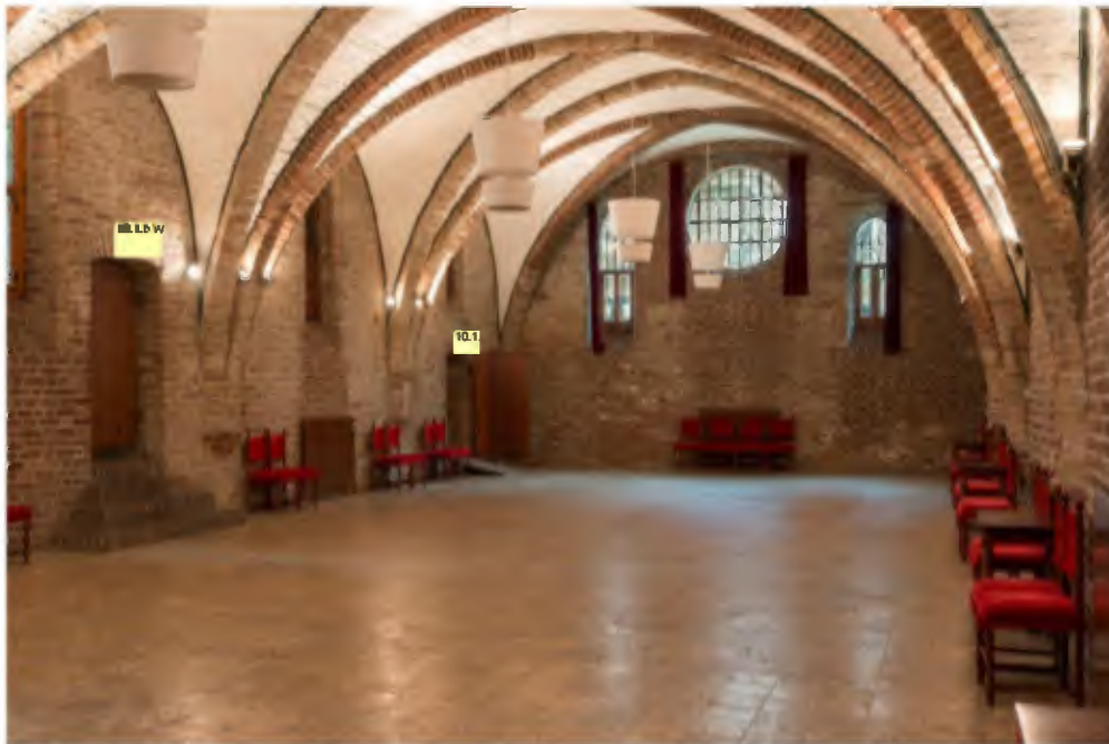
Afb. 33. De kelderzaal uit 1250 met kruisriboverwelfing. In de zuidelijke gevel een door lancetvensters geflankeerd roosvenster. Opname: D. Valentijn 2018, beeldbank RCE, inv.nr.: IvhB-0233.
