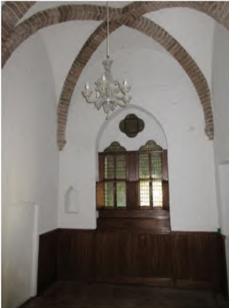
afb. 38. De ruimte op de eerste verdieping van de Haagtoren. Deze torenkamer heeft een rijke uitmonstering met een dubbel kruisribgewelf en in de kopse gevel een rijk vormgegeven romano-gotisch venster. Links naast het venster een met een keperboog afgedekte kaarsnis en in de linker gevel een dichtgezette schouw, afgedekt door een segmentboog. De torenkamer betreft vermoedelijk de schrijfkamer/comptoir van de Rooms-Koning.
