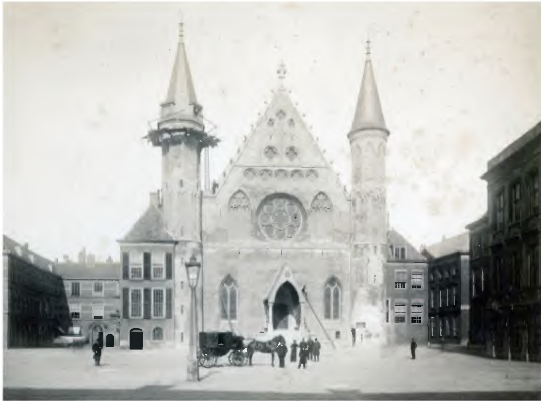
Afb. 76. De westgevel van de Grote Zaal gedurende de aflopende restauratiewerkzaamheden in 1880. De gerestaureerde 'middeleeuwse' geveltop volgt de daklijn van de gietijzeren kapconstructie uit 1861. Hierdoor heeft de topgevel een groter bouwvolume gekregen en heeft de gevel een flauwere helling als de oorspronkelijke middeleeuwse topgevel. Beeldbank HGA, inv.nr. 001009826.
