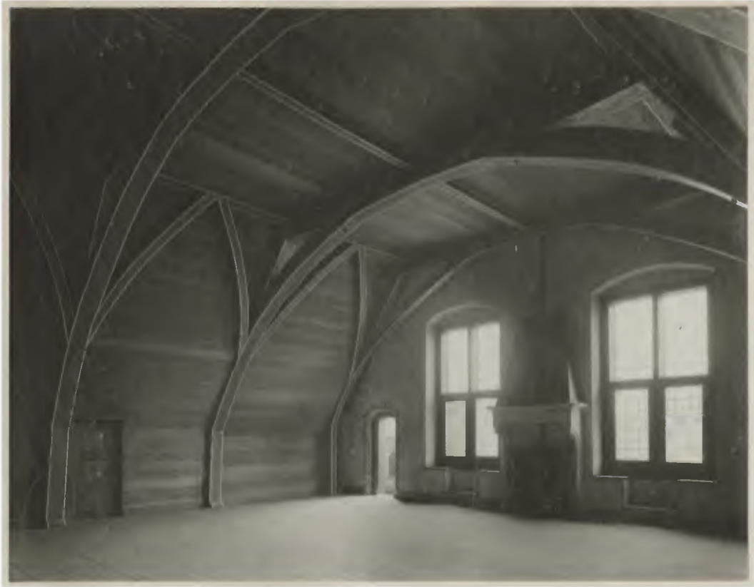
Afb. 94. De in 1330 tot stand gekomen zolderzaal: Hoogerbeetskamer. De deur links op de foto geeft toegang tot de traptoren uit 1310 en de geopende deur (centraal op de foto) tot het balkon/weergang. Beeldbank HGA, inv.nr. 001037581.
