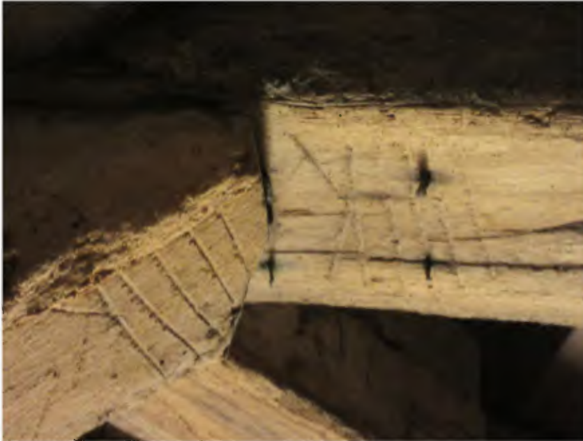
Afb. 69. Detail van het eikenhouten tafelmantel in de noordwestelijke toren van de Grote Zaal. Op de bovenzijde van het korbeel en de onderzijde van de balk van het bovenste horizontale raamwerk is het getrokken telmerk IIIIK aangebracht.
