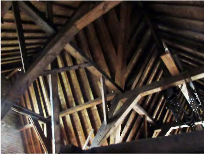
Afb. 50. Detail van het korsbeel van een kerspant van de kapconstructie uit 1758 met het gehakte telmerk 9. Ongebruikelijk is dat het telmerk uitgevoerd is als het Romeinse cijfer IX in plaats van het gebruikelijke telmerk VIII.
