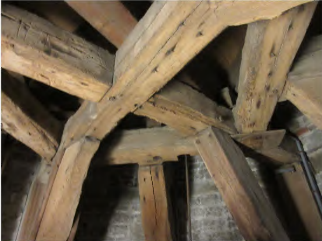
Afb. 66. Bovenste horizontaal raamwerk van het tafelment in de noordwestelijke toren van de Grote Zaal. Op de balken zijn getrokken telmerken herkenbaar. Het in eikenhout uitgevoerde tafelment is in 1295 tot stand gekomen en droeg oorspronkelijk de torenspits.
