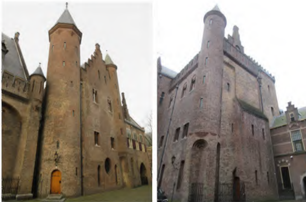
afb. 31 en 32. Zuidelijke gevel (links) en noordelijke gevel van het 'koninklijk paleis' uit 1250. De zuidgevel wordt geflankeerd door een grote ronde traptoren, de zogenoemde 'wandelsteen' en een traptoren op steunberen. De noordgevel heeft een identieke traptoren op steunberen.
