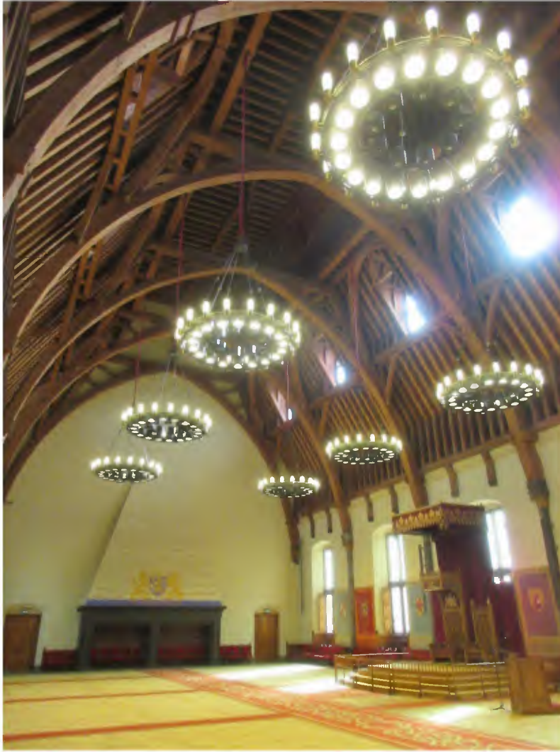
Afb. 65. De Grote Zaal uit 1295 met de in 1900 gereconstrueerde kapconstructie, naar opmetings- tekeningen uit 1859. De kapconstructie van de Grote Zaal heeft een overspanning van 18m met gebinten met grote kromme st. jlen en samengestelde korbelen om aan de gebinten een :pitsboogvorm te geven.
