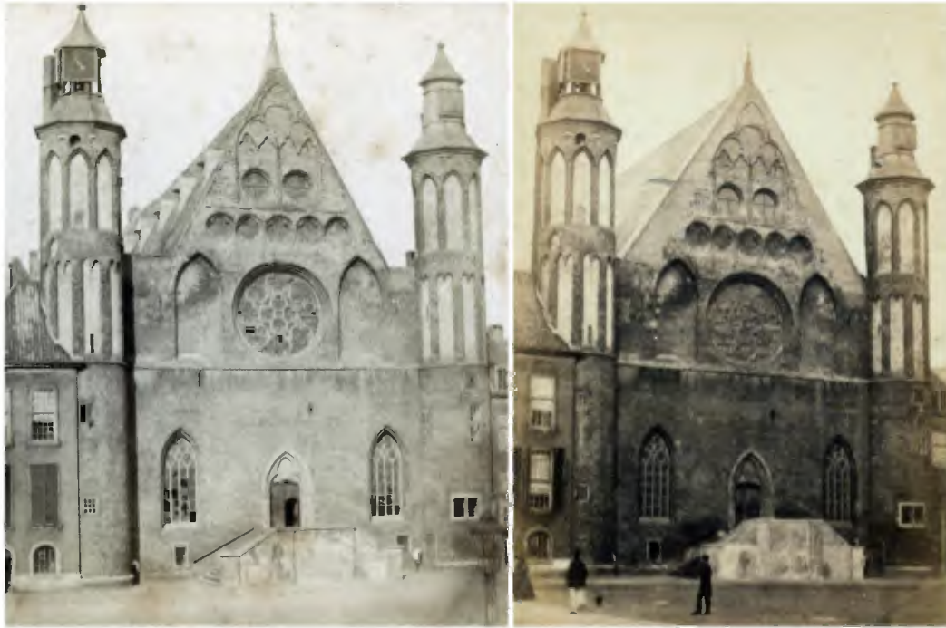
Afb. 73 en 74. Links de westgevel van de Grote Zaal uit 1860 en rechts uit 1865. Op de linker foto is de in 1814 aangebrachte tracering van met lood bekleed hout in de twee spitsboogvensters en het roosvenster zichtbaar. De topgevel vertoont de oorspronkelijke steile topgevel, die aansluit op de originele kapconstructie. Alleen de schouderstukken zijn opgehoogd. Rechts de topgevel na vervanging van de houten kapconstructie uit 1295 door een gietijzeren constructie door rijksbouwmeester Rose in 1861. Omdat deze nieuwe kapconstructie een andere dakhelling heeft is de topgevel daarop aangepast door het aanbrengen van nieuw metselwerk in een vliegende baksteen, dat vrij grof is ingetand in het originele middeleeuwse metselwerk. Beeldbank HGA inv.nr. 626145.1 en HGA inv.nr. 001009857.
