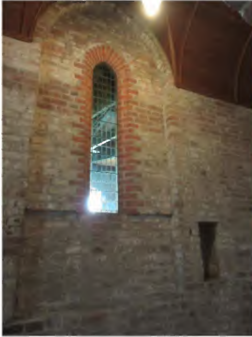
Afb. 45 en 46. Links de kapelruimte in het trapportaal met boven de altaarnis een lancetvenster in een spitsboogvormige gevelnis. Rechts van de altaarnis een lavabo. Deze nis is afgedekt met een latei in Doornikse steen. Rechts het trapportaal richting het zuiden met links twee trapsgewijs aangebrachte hoge smalle (nu dichtgezette) vensters.
