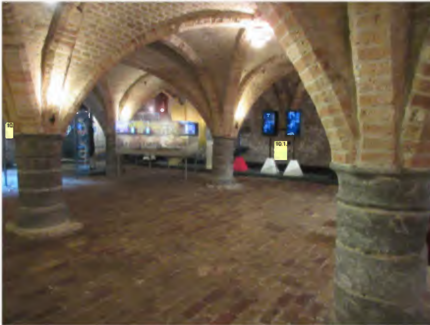
Afb. 61. De westelijke kelder uit 1295 onder de Grote Zaal. De kruisrib- gewelven worden gedragen door zuilen van Doornikse steen.
