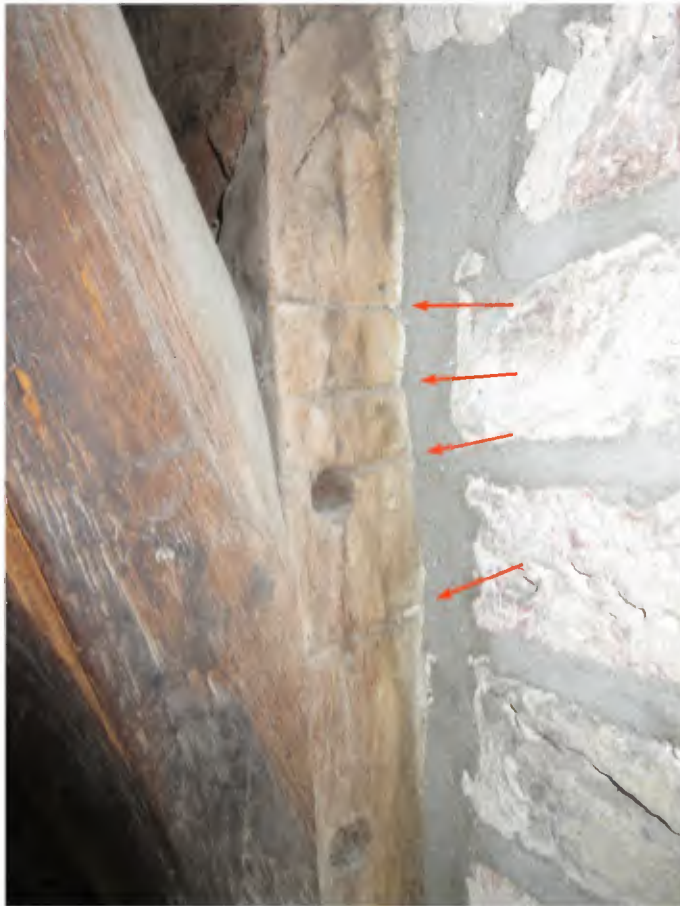
Afb. 70. Zijkant van een van de eikenhouten stijlen van het tafelment van de noordwestelijke toren van de Grote Zaal. De rode pijlen markeren de vier inkepingen van het getrokken vlot- of eigendomsmerk. Het korbeel is in grenenhou vernieuwd.
