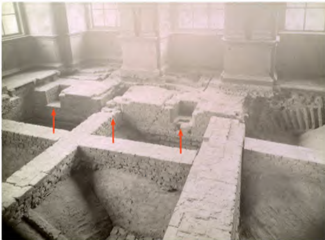
Afb. 84. De De Lairessezaal na verwijdering van de houten vloer in 1897. De drie rode pijlen markeren de vensterbanknissen van de vensters in de oorspronkelijke zuidelijke gevel van de zaal uit 1310. Deze gevel is in 1330 gesloopt en naar het zuiden verplaatst voor het creëren van de huidige De Lairessezaal. Beeldbank RCE, inv.nr. OF-04368.
