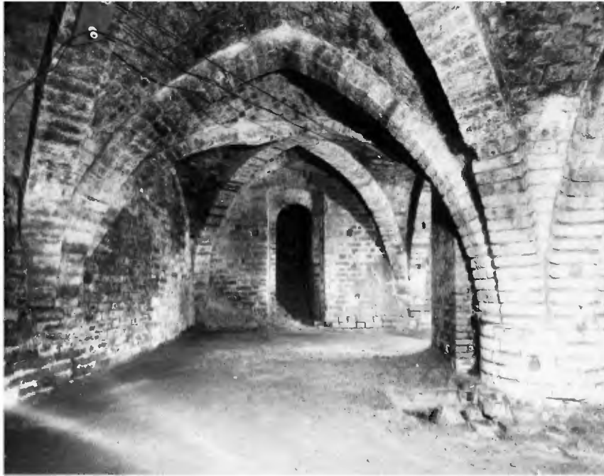
Afb. 25. De middelste oudste kelder onder de Grote Zaal (Ridderzaal). De kelder uit 1230 is overwelfd met kruisribgewelven die in het midden worden ondersteund door drie ronde zuilen. W. Kramer 1899, beeldbank RCE, inv.nr.: 37.919.
