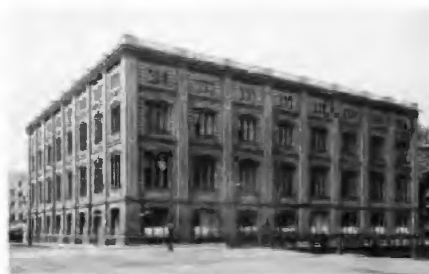
1836 BAUAKADEMIE DOOR SCHINKEL
