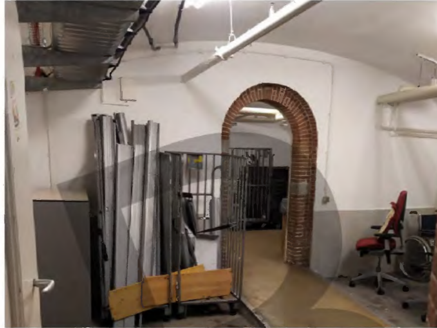
GEWELVEN IN HET ZICHT IN DE KELDERS
