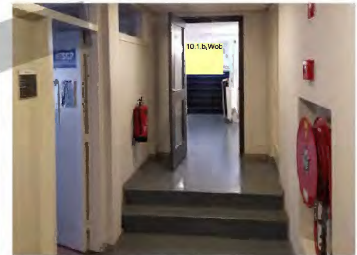
HUIDIGE SITUATIE (RICHTING BOUWDEEL C)
