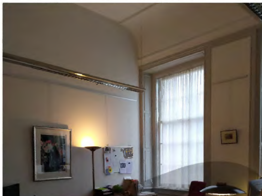
OPGEKNIPTE RUIMTEN MET DOORLOPENDE PLAFONDLIJST
