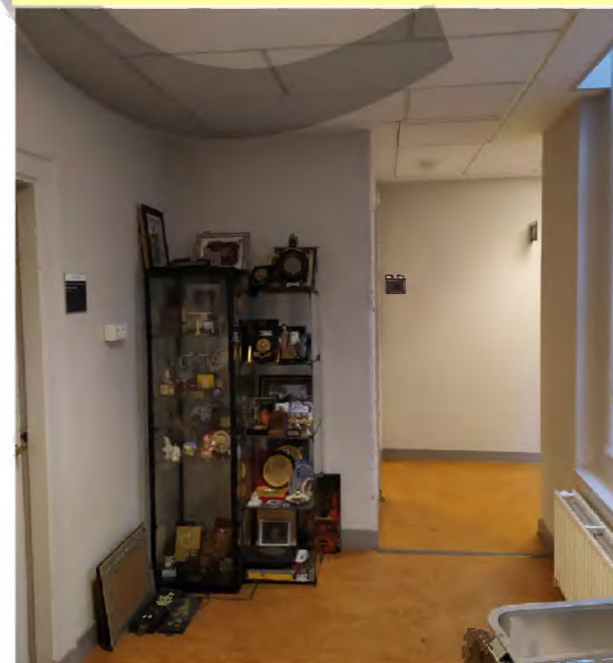
VERLAAGDE SYSTEEMPLAFONDS VOOR VENSTERS
