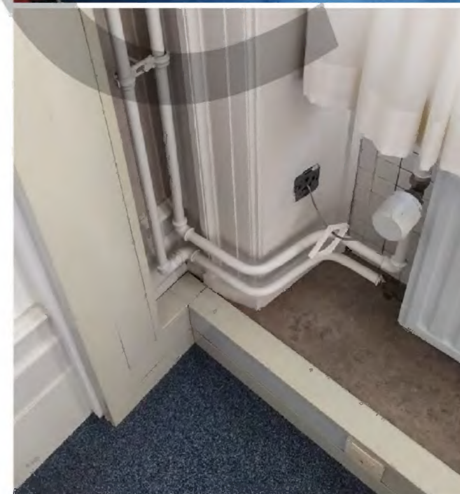
INSTALLATIES DOMINANT AANWEZIG
