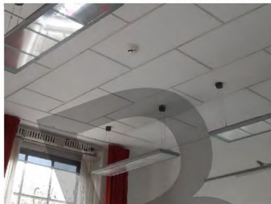
MODERNE PLAFONDS, SYSTEEMPLAFOND BINNEN STUCWERKKADER
