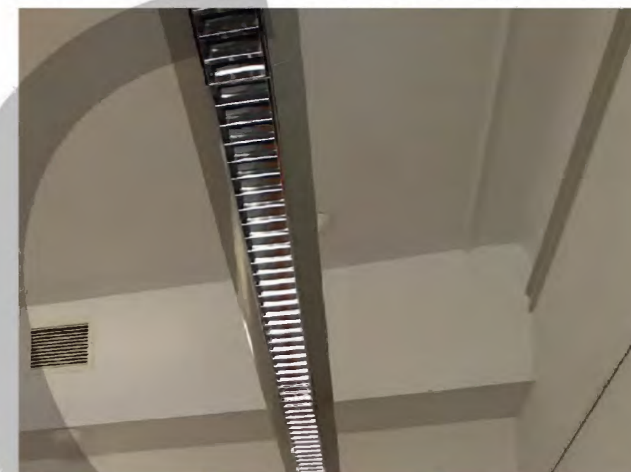
GEPROFIEERDE PLAFONDLIJSTEN STUIKEN OP INSTALLATIEKOVEN
