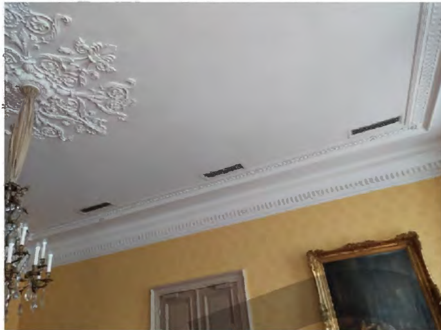
IN PLAFOND GEÏNTEGREERDE INSTALLATIES, SCHRIJFKAMER
