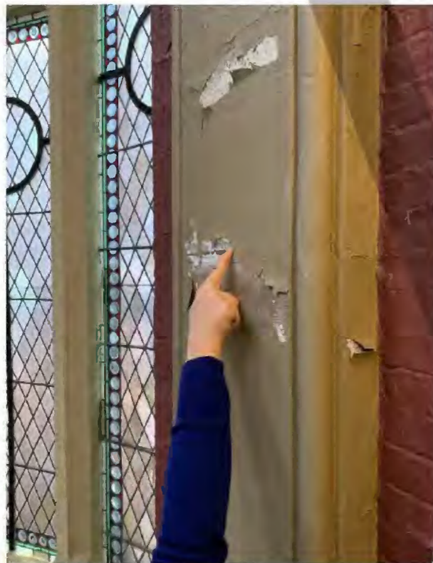
OPNAMES BOUWKUNDIGE SITUATIE (VHA 2020) MET AFLAPPERENDE VERFLAGEN WAARONDER DE ORIGINELE, GESCHILDERDE SCHIJNVOEGEN ZICHTBAAR WORDEN.
