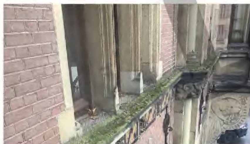
BOUWKUNDIGE OPNAME FOTO'S (VHA 2020) AANRAASTING VAN NATUURSTENEN ONDERDELEN
