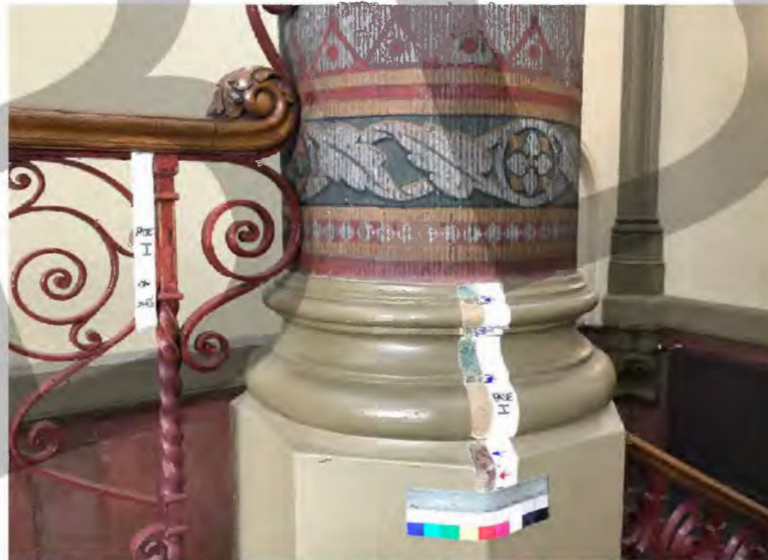
FOTO BOVEN: NETGEWELF (1883, BEELDBANK RCE) BOVEN DE BIBLIOTHEEKTRAP MET IN ZICHT DE SIERMETSSELWERKEN EN DECORATIEVE BESCHILDERINGEN OP GEWELVEN, NATUURSTENEN ONDERDELEN EN OP GESTUCTE WANDNISSEN. FOTO ONDER (2020, KLEURONDERZOEK JUDITH BOHAN) KOLOM TRAPPENHUIS MET VRIJGELEGDE STROOK OP HET BASEMENT DE BEWAARDGEBLEVEN ORIGINELE DECORATIE OP DE KOLQM.
