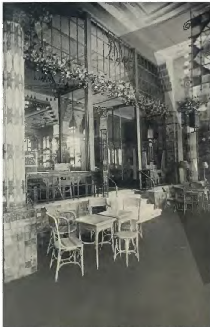
STALEN PUIEN SCHEIDEN DE VERANDA VAN HET RESTAURANT
