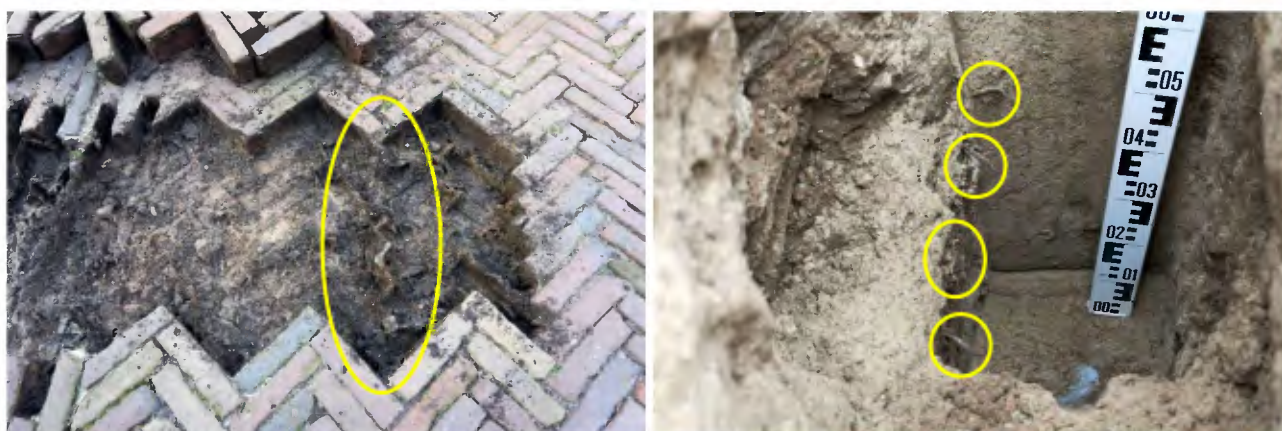
Foto 8: Links is oppervlakkige beworteling in de voeg tussen klinkers zichtbaar, rechts fijnere beworteling in de zandsleuf van de riolering.
