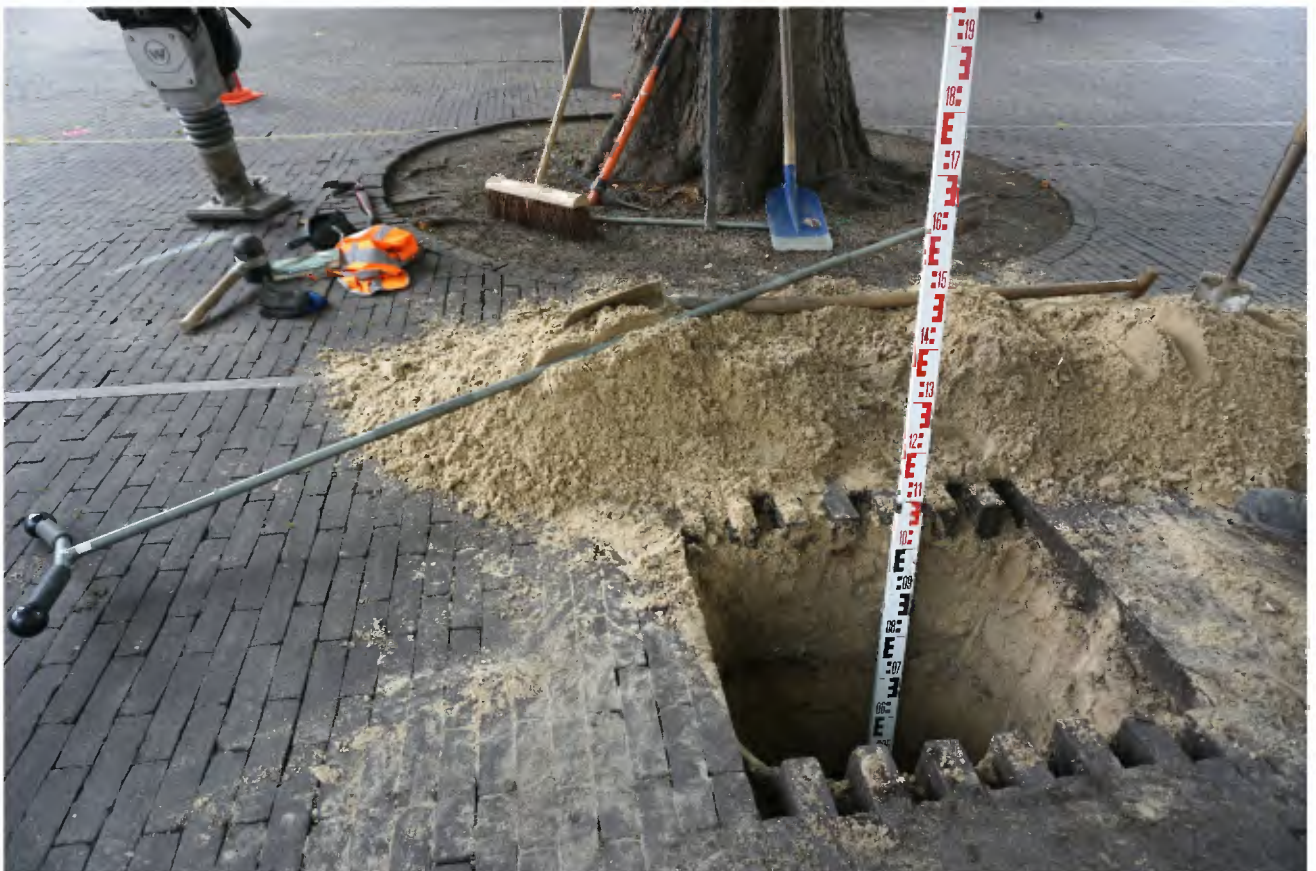
Foto 13: Beeld van het zandige bodemprofiel aan de westzijde van boomnummer 5. Het bodemprofiel is humusarm zand, beworteling is tot 0,7 m-mv vrijwel afwezig, vanaf 0,7-1,1 m-mv extensief doorworteld met wortels tot 2 mm doorsnede.
