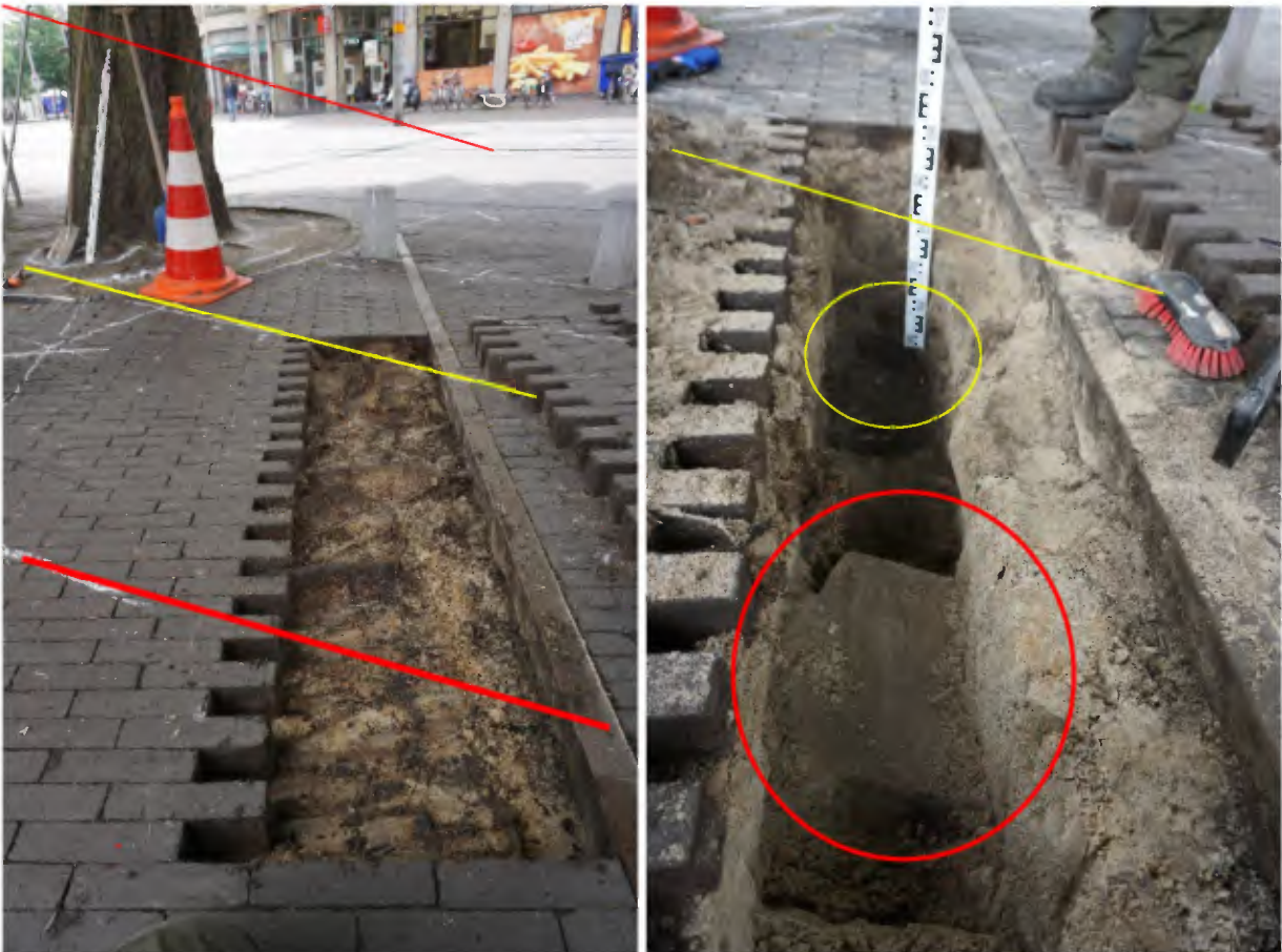
Foto 15: Profielsleuf bij boomnummer 10, de gele lijn betreft een uitzonderlijk dikke datakabel op 45 cm-mv, de rode lijn betreft een leidingtracé op 0,65 m-mv, afgedekt door een dekplaat van 30 x 30 cm betontegels op 0,3 m-mv.
