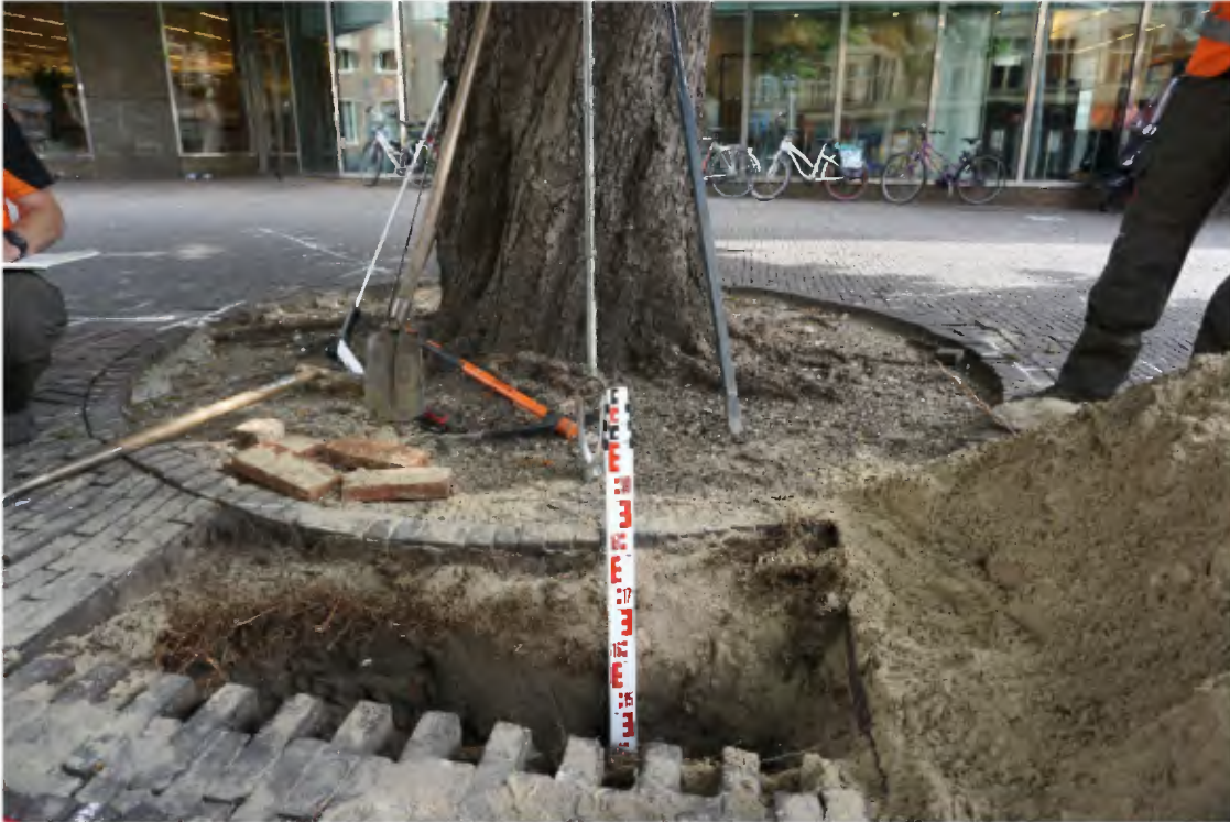
Foto 14: Beeld van de opbouw van het bodemprofiel op de rand van de boomspegel bij boomnummer 7. De datakabel evenwijdig aan de sleuf bevindt zich op 1,1 m-mv, de gasleiding is niet aangetroffen. Bodemprofiel is intensief doorworteld van 5-10 en 55-95 cm-mv, in de tussenlaag afwezig, vanaf 0,95-2,0 m-mv extensief doorworteld.
