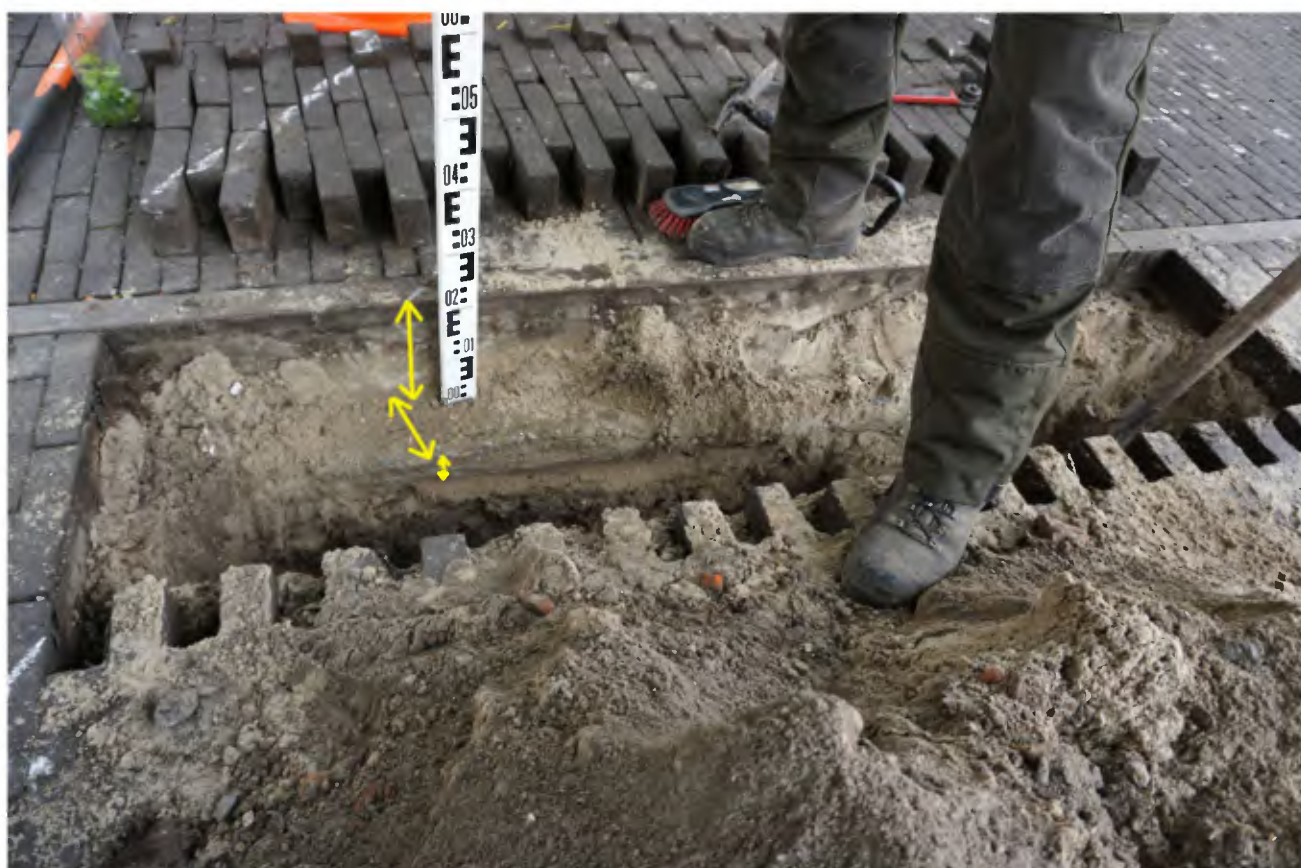
Foto 7: Beeld van de betonnen streklaag met koper omhulsel op de betonfundering.
