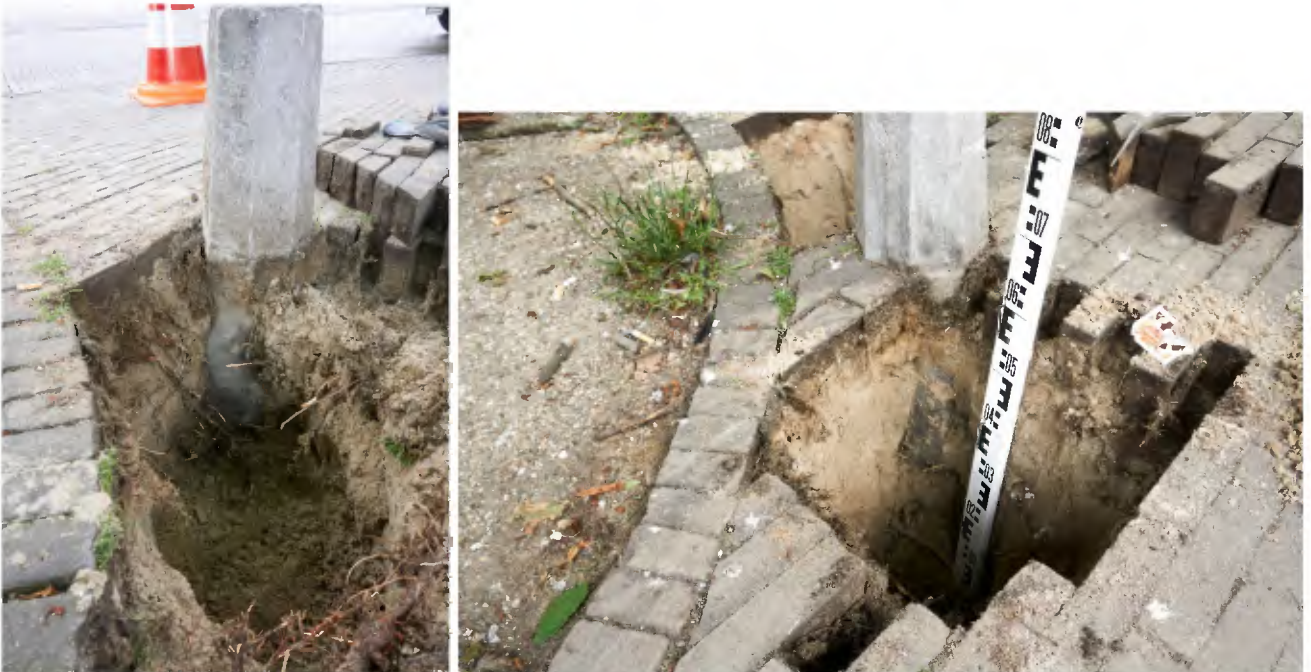
Foto 5: Beeld van een beperkt volume met intensieve beworteling op twee verschillende locaties. Achter de baak bevindt zich een natuursteen bollard. Dit bewortelingsprofiel, grenzend aan de boomspiegel, beperkt zich tot maximaal 0,5 meter rondom de bollard. Deze concentratie aan beworteling is het gevolg dat rondom deze paal relatief veel organisch materiaal inspoelt.
