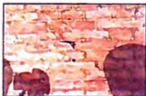
scheurvorming metselwerk
