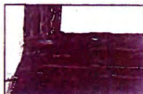
afgebladder schilderwerk
