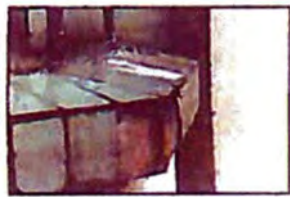
gevelgipswerk laat los
