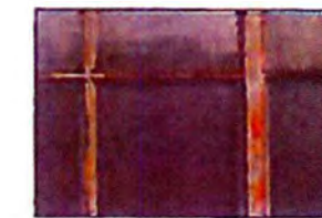
verroest rearmetwerk
