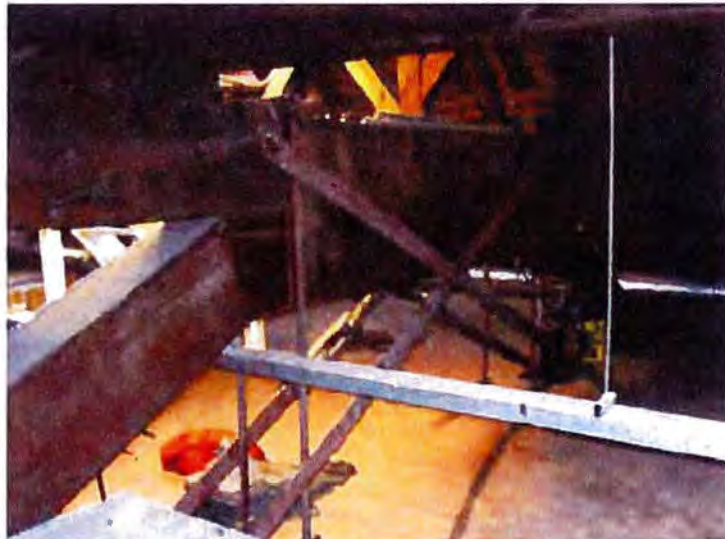
Foto 3, verstijving houten spant met een staalconstructie
