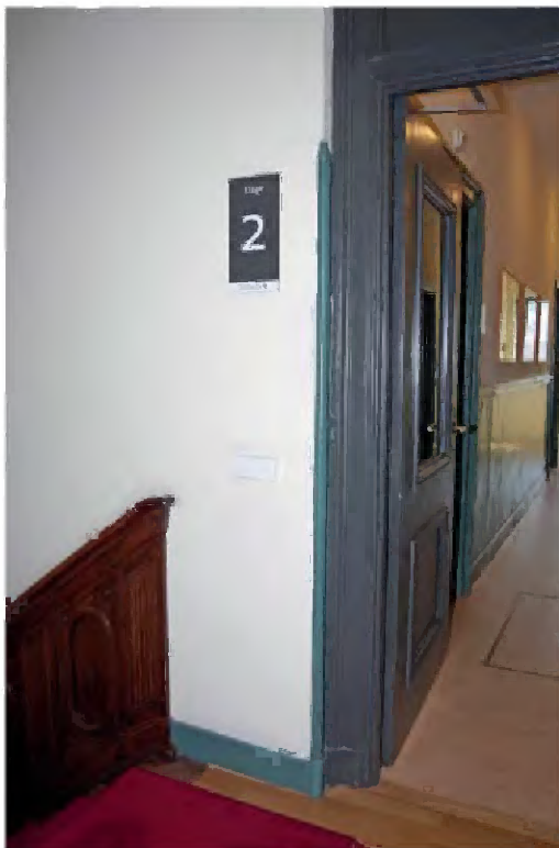
TK-B-136 Doorgang, voorzien van tochtpui tot westelijk deel van de lange gang in oost-west richting (B.02.1.09).
