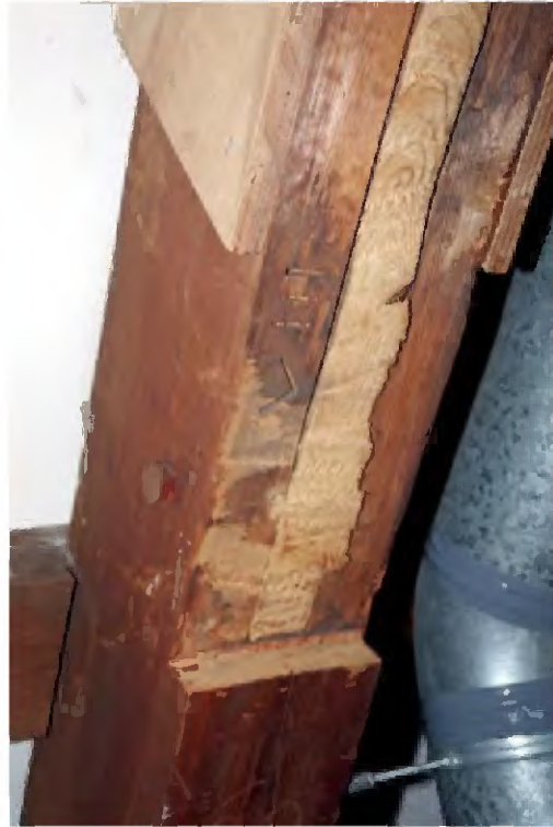
TK-B-144 Gehakt telmerk WIT , in het zicht gekomen na het weggaan van kerf in een spahi aan de noordzijde.
