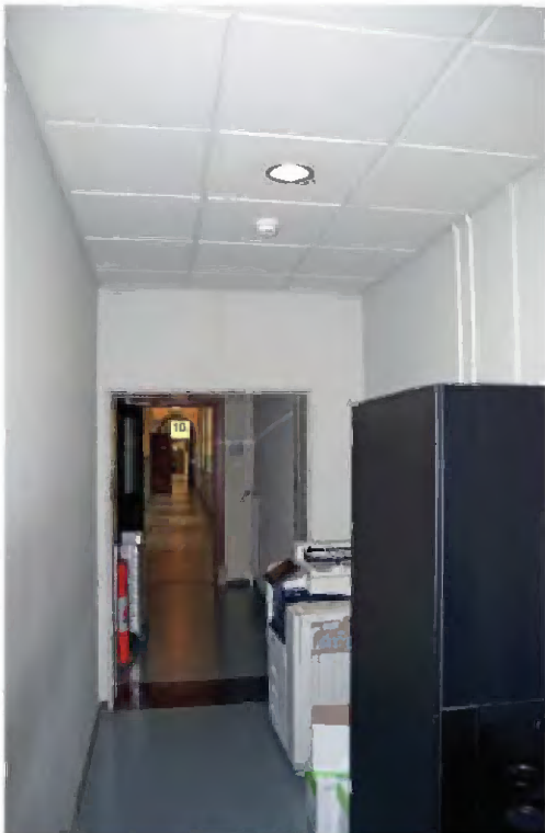
TK-B-183 Interieur gang B.02.1.05a, gezien in oostelijke richting (gebouw TK-C).
