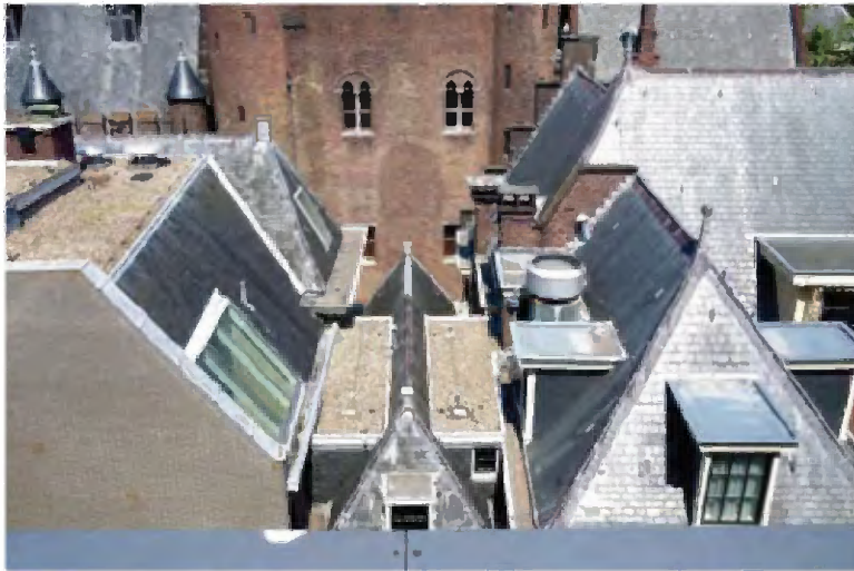
TK-B-154 Dakenlandschap met in het midden het dak van het Goudsmidskeurhuis. Het schilddak gedekt met leien heeft op het voor- en achterdakschild een kleine dakkapel; de beide lange zijdakschilden zijn voorzien van een grote dakkapel over nagenoeg de volle breedte.
