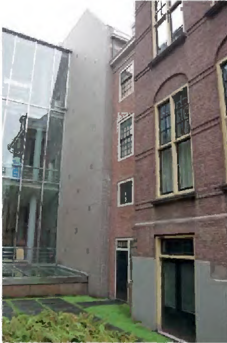
TK-B-152 In het midden de zuidgevel van Goudsmidskeurhuis met rechts daarvan de zuidgevel van gebouw TK-C (Uitbreiding Koloniën) en links de blinde gevel in grijsig metselwerk van het Schepelgebouw
