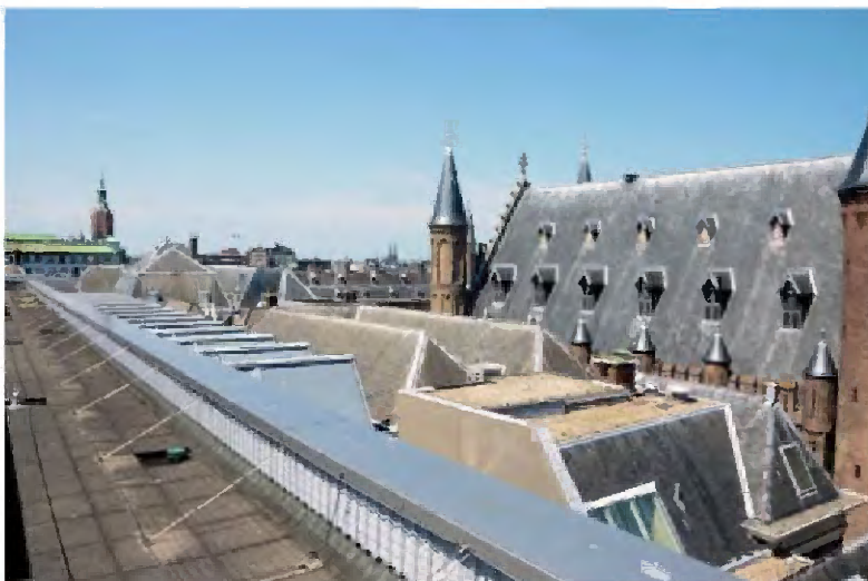
TK-B-153 Dakenlandschap van het Tweede Kamergebouw TK-B, gezien vanaf de overkapping van de binnenstraat in gebouw N; op de voorgrond rechts het dak van het Schepelgebouw bestaande uit een schilddak (voor) en afgeplat dak (achter); op de achtergrond het U-vormig dak van het voormalig kantoor van het Comptoir-Generaal.
