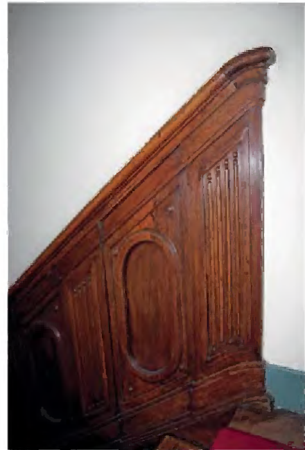
TK-B-135 Detail lambrisering uit de bouwtijd.
