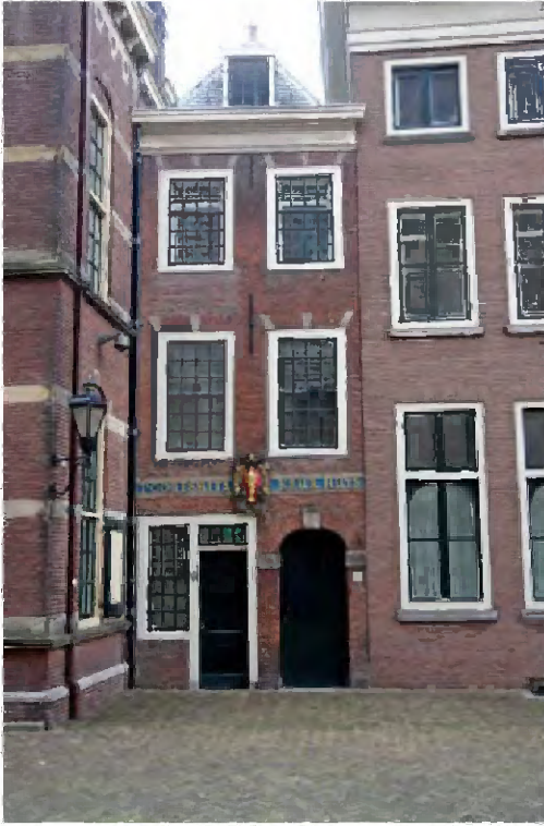
TK-B-149 Gerestaureerde noordgevel van het Goudsmidskeurhuis, gezien vanuit het noorden.
