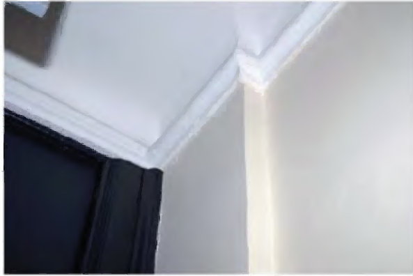
TK-B-138 Detail stucwerkplafond in de gang met geprofileerde randlijst uit de bouwtijd.
