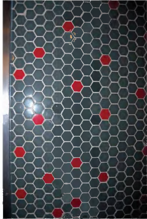
TK-B-185 Detail mozaiek wandbetegeling hoofdrappenhuis.
