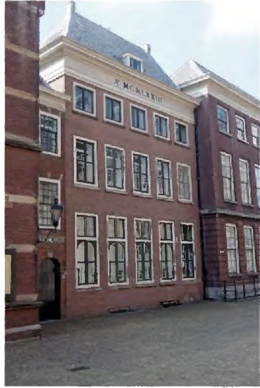
TK-B-150 Herbouwde Schepelgebouw, gezien vanuit het noordoosten.
