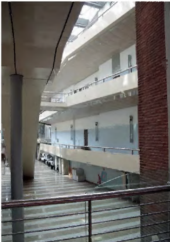
TK-A-463 Zicht op de gepleisterde en gesausde noordgevel van de voormalige woonhuizen, gezien vanuit het noordwesten, met galerijen op de begane grond, eerste en tweede verdieping.
