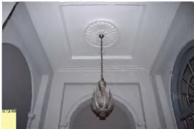
TK-A-565 Detail stucwerkplafond met rozet en lamp van Venetiaans glas.
