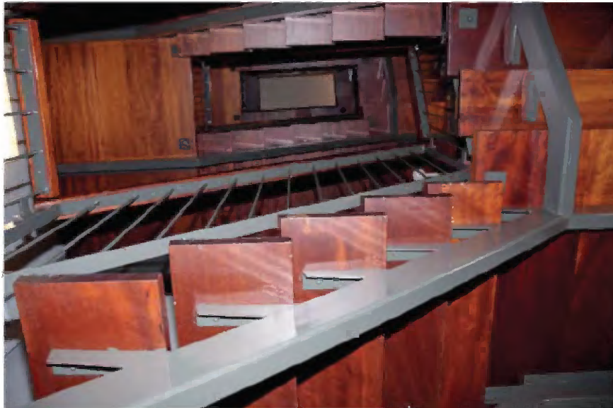
TK-A-478 Interieur trappenhuis.
