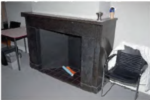
TK-A-431 Zwart marmeren schoorsteenmantel van de stookplaats aan de westzijde van het vertrek. De stookplaats behoort tot de oorspronkelijke aanleg (twee vertrekken); de schoorsteenmantel is hoogstwaarschijnlijk uit 1922.
