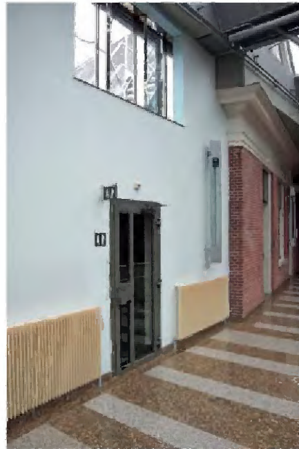
TK-A-467 Galerij langs noordzijde van Hofplaats 4, gezien in westelijke richting, met in de wit gepleisterde noordgevel toegang tot toiletten. Aansluitend de bakstenen gevel van het bouwdeel dat bij Hofplaats 2 behoort (Hofplaats 2a of ook 4).
