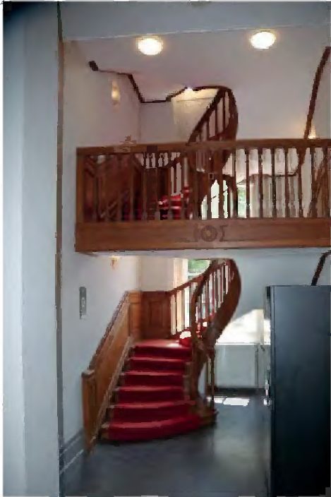
TK-A-554 Trap ter hoogte van de begane grond met een dubbele slag per verdieping.
