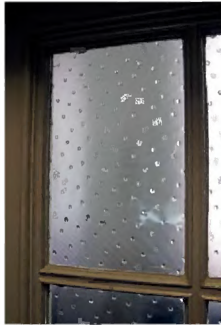
TK-A-579 Detail ruitjes van druppelglas in de toegangsdeuren.
