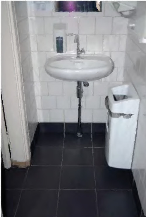
TK-A-619 Interieur van een aparte toiletten aan de gang.
