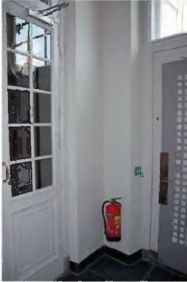
TK-A-562 en TK-A-563 Interieur entreeportaal (dienstingang) aan de zijde van de Hofplaats met vloer van hardstenen plavuizen en dorpels van Muschelkalk.
