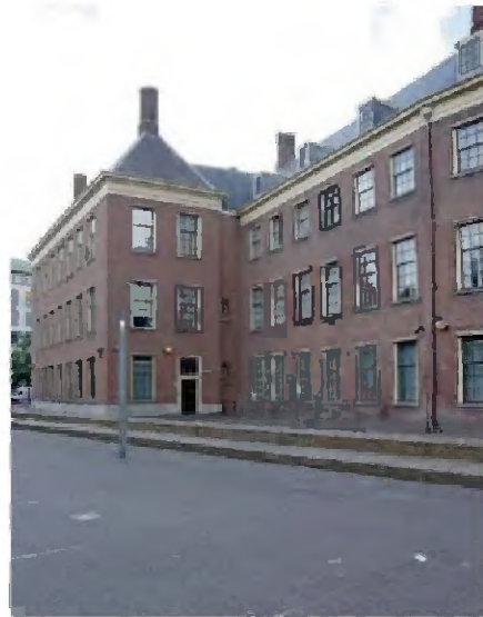
TK-A-519 Kortenhorst vleugel, gezien vanaf de Hofweg in noordwestelijke richting.
