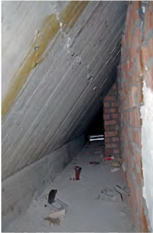
TK A-685 Het onderste gedeelte van het dak is ook in beton uitgevoerd; rechts de wand opgetrokken van porsesteen van zolderruimte A.03.0.21.
