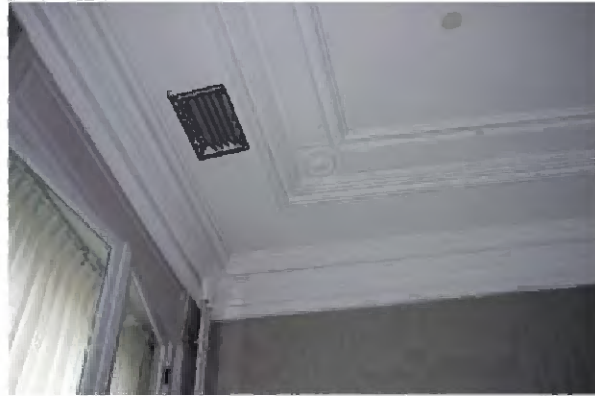
TK-A-404. Detail stucwerkplafond met rozet in de hoek, die op een datering aan het eind van de achttiende eeuw duidt.
