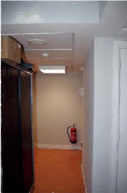
TK-A-60 Interieur portaal, met rechts achteraan opgang naar de galerij aan de zuidzijde.
