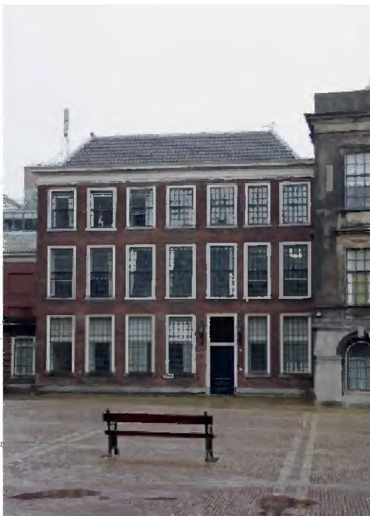
TK-A-695 Noordgevel, een lijstgevel, aan het Binnenhof (1766) met - nadat er enkele keren met de entree geschoven is - de uiteindelijk uit het midden geplaatste ingang (1950).
