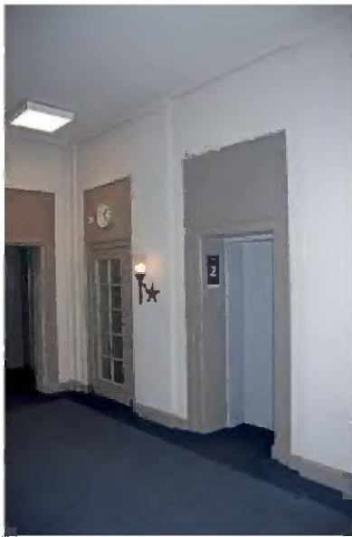
TK-A-415 Interieur hal (A.02.1.36) aan de westzijde van de smalle oost-west gang (A.02.1.28) met aan de zuidzijde in 1959-1963 ingebouwde lift en toiletten.
