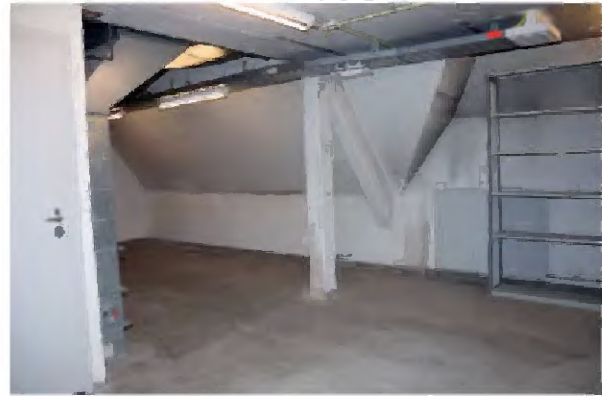
TK-A-682 Betonnen spanbeem van de dakconstructie in archiefzolder A.03.0.21.
