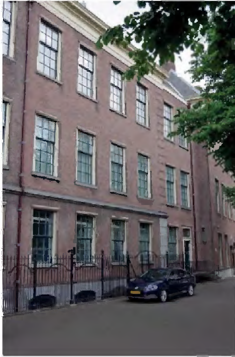
TK-A-522 Westgevel Kortenhorstvleugel.
