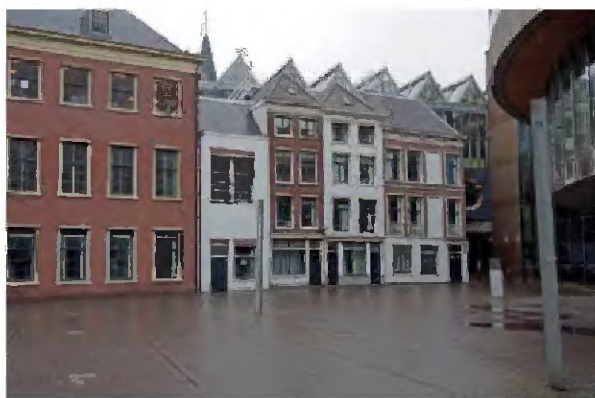
TK-A-459 De voormalige woonhuizen aan de Hofplaats, gezien vanuit het zuiden.
