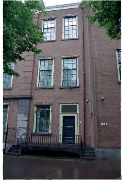
TK-A-523 Tussenbouw Kortenhorstvleugel met dienstingang (voormalige dienstwoning). Ook in de kelder is een ingang.
