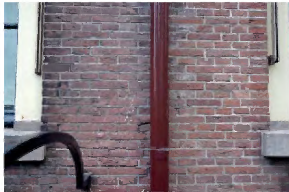
TK-A-521 Verschil in metselwerk: links achttiende-eeuws metselwerk met klei en rechts metselwerk uit 1959-1963.
