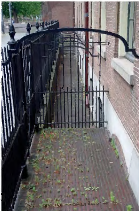
TK-A-524 Overzicht kelderkoekoek aan de Hofweg.
