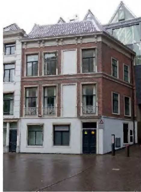
TK-A-462 Zuid- en oostgevel van Hofplaats 10.
