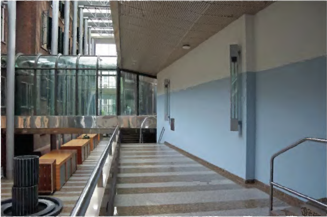
TK-A-464 Interieur Schepelhal, gezien in oostelijke richting, met galerij op begane grond niveau. De noordgevel (achtergevel) van de voormalige woonhuizen is gepleisterd en lichtblauw en wit gesausd.
