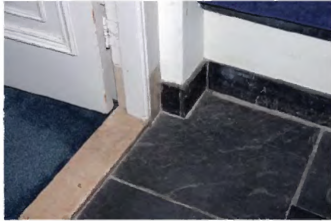
TK-A-562 en TK-A-563 Interieur entreeportaal (dienstingang) aan de zijde van de Hofplaats met vloer van hardstenen plavuizen en dorpels van Muschelkalk.
