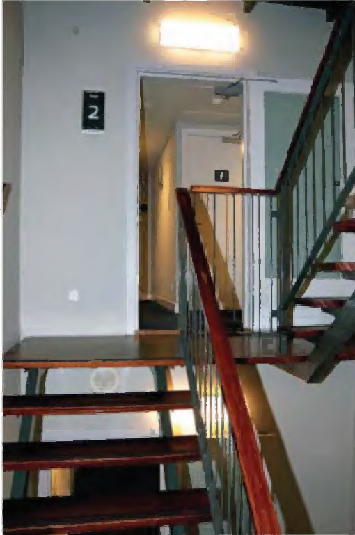
TK-A-498 Trappenhuis met doorgang naar portaal.
