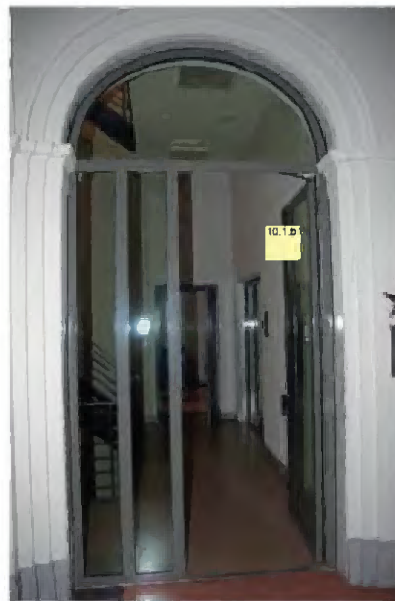
TK-A-388 Doorgang aan noordzijde van de hal naar nieuw trappenhuis (1988-1996).
