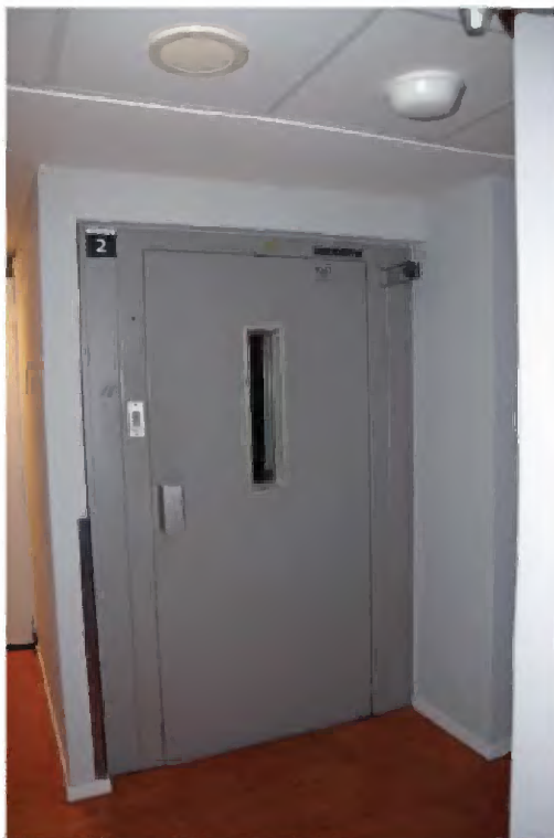
TK-A-479 Lift in portaal (A.00.1.43)
