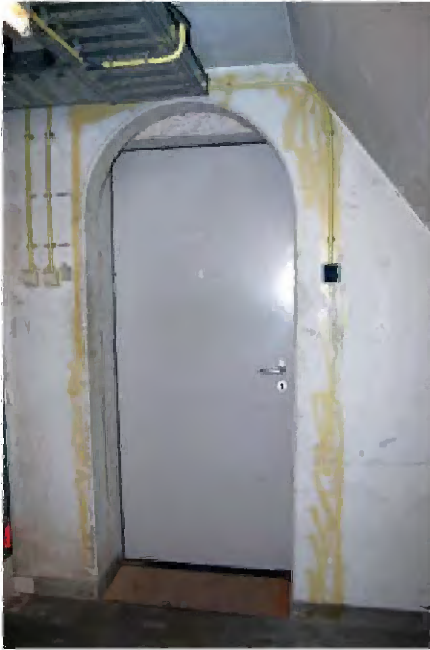
TK-A-681 Boogvormige doorgang in betonnen scheidingwand tussen archiefruimte A.03.0.20 en A.03.0.21, tevens de scheiding tussen fase 1 en fase 2 van de bouw.
