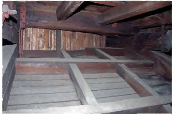
TK-A-237 Deel van het gewelf met de tamboer van de lantaarn, uitgevoerd in hout met stucwerk op riet.
