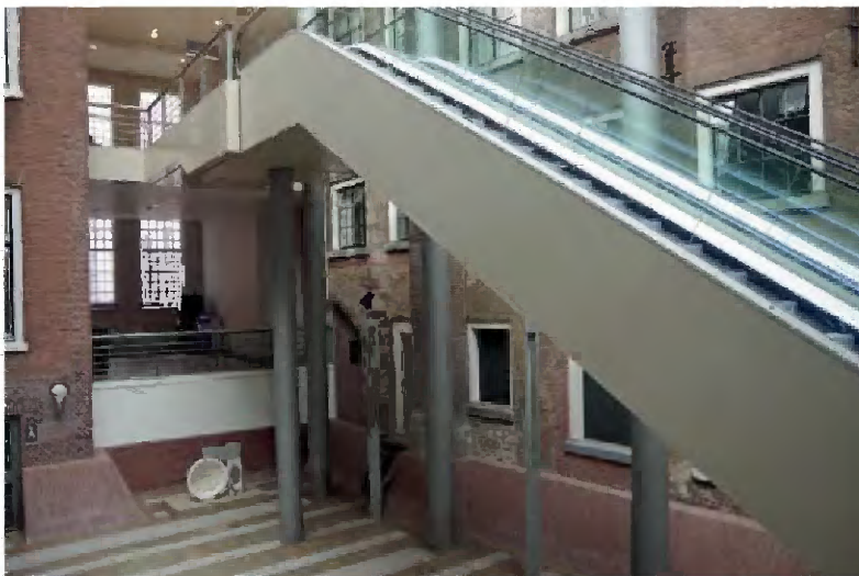
TK-A-330 Aanzicht overloop op begane grond en eerste verdieping met roltrap vanuit de Schepelhal. De oostgevel is weggebroken. Rechts de achtergevel van de voormalige Landssuikerij.
