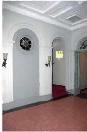
TK-A-356 Interieur van de hal met aan de noordzijde de opgang naar de laat achttiende-eeuwse trap met oculus voor licht in het trappenhuis. Rechts verbindingsdeur naar de oost-west gang (A.00.1.50).
