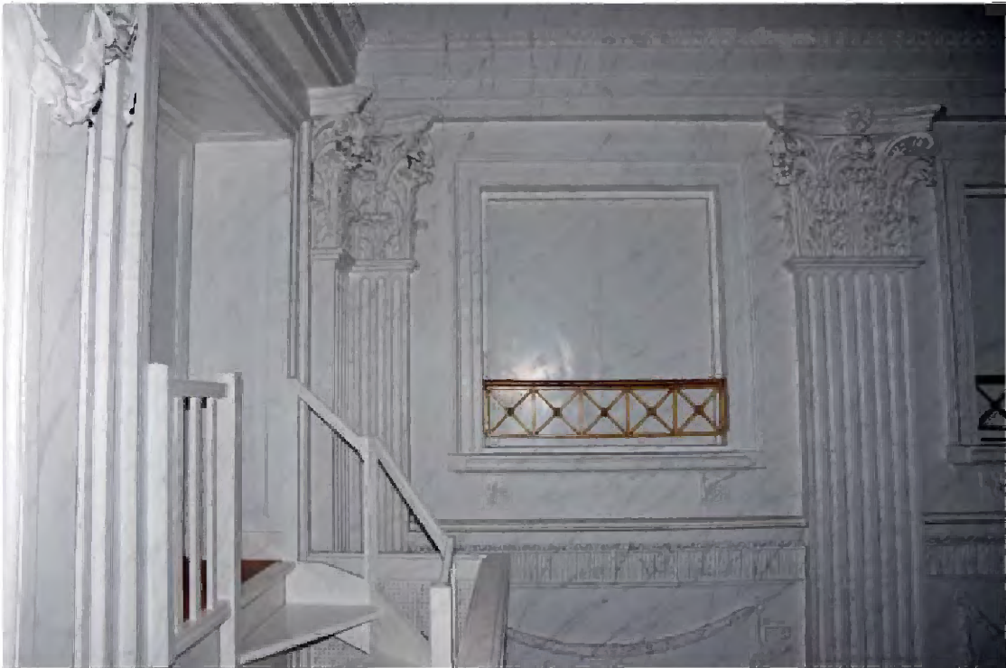
TK-A-120 Detail van dichtgezette nis (balkon) aan de gang (A:02.1.09) op de tweede verdieping. Ter plaats van de nis bevinden zich naar de gang erachter open draaiende deuren.
