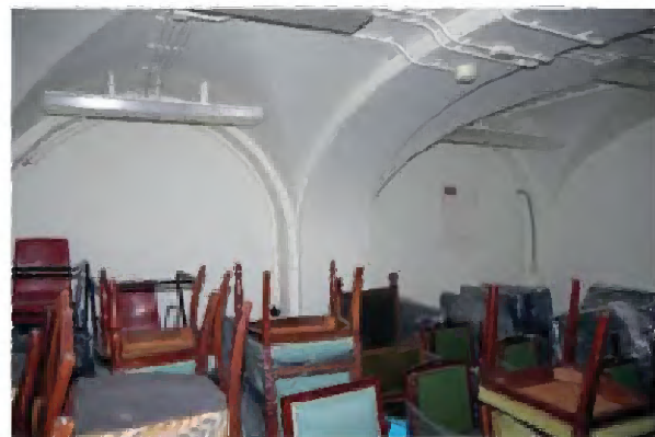
TK-A-248 Interieur kelder R.-1.04, overdekt door twee ribloze kruisgewelven. De bogen naar kelder R.-1.03 zijn in 1959 dichtgezet.
