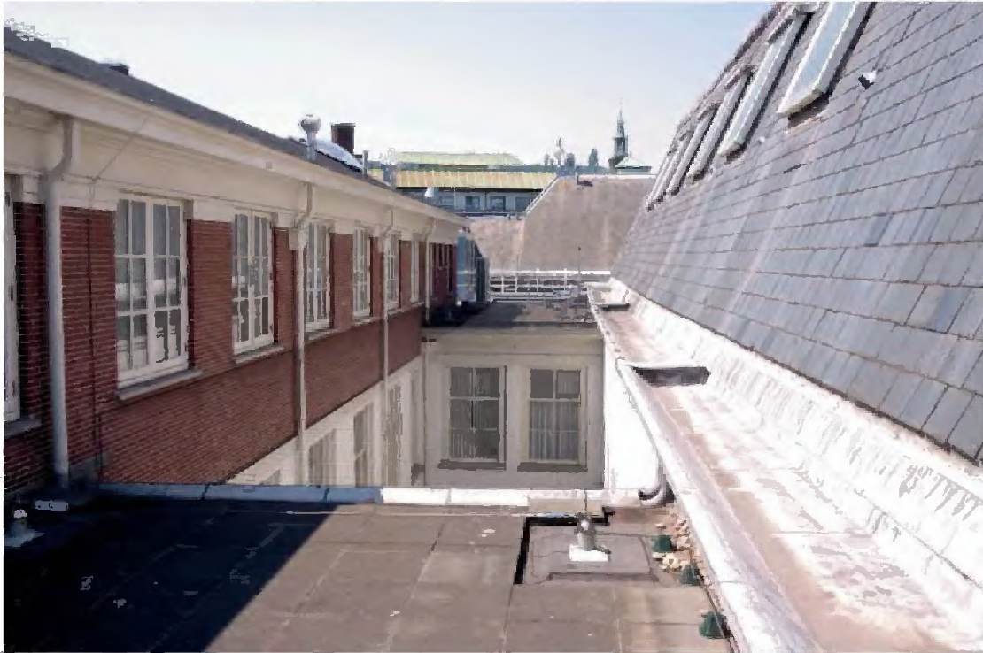
TK-A-321 Zicht over de binnenvlaats in westelijke richting met links de hoger opgetrokken noordgevel en rechts het dak van de Oude Zaal.
