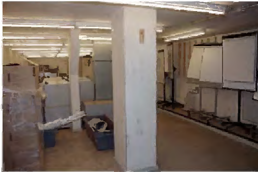
TK-A-204 Interieur zolder A.03.0.22, gezien in zuidelijke richting. Afgetimmerde ruimte waar delen van de kapconstructie ook zijn afgewerkt met stucwerk op steengaas.
