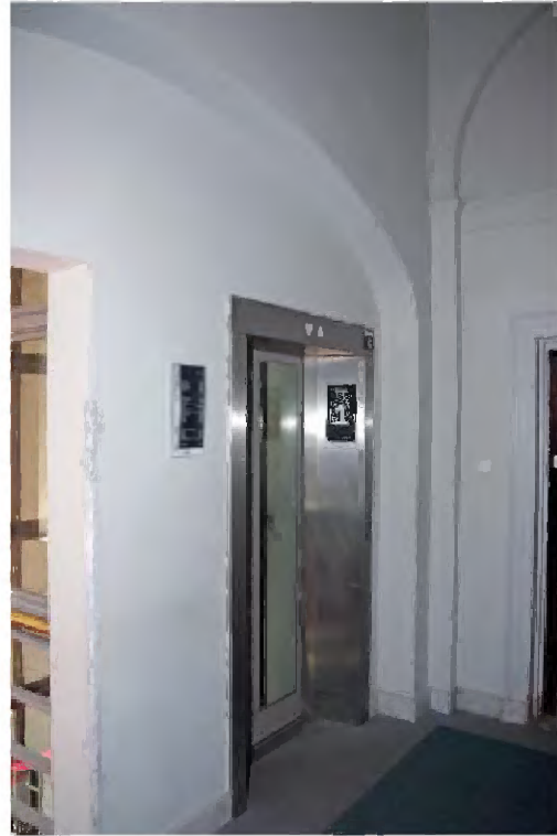
TK-A-162 Interieur hal met de in 1988 ingebouwde lift.
