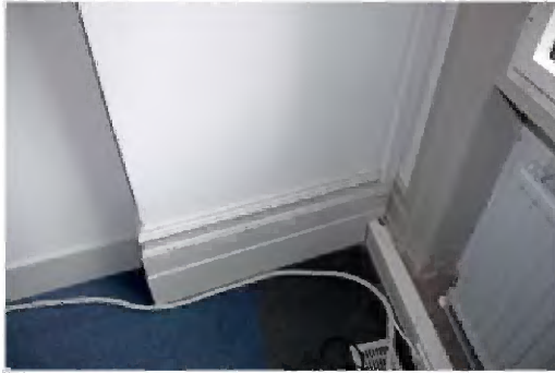
TK-A-368 Muurpenant met plint uit de jaren 1958-1963. Links ijzetwand met lage plint.
