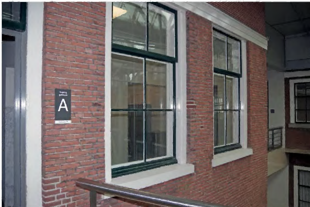
TK-A-316 Detail oostgevel Hofplaats 2 (tot stand gekomen bij uitbreiding 1877) met toegang tot de hal (A.02.1.26) op de tweede verdieping.
