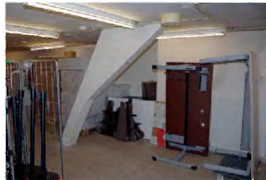
TK-A-225 en TK-A-226 Interieur zolder A.03.1.29/A.03.1.30 met 'ingepakt' spantboven en korbeel.
