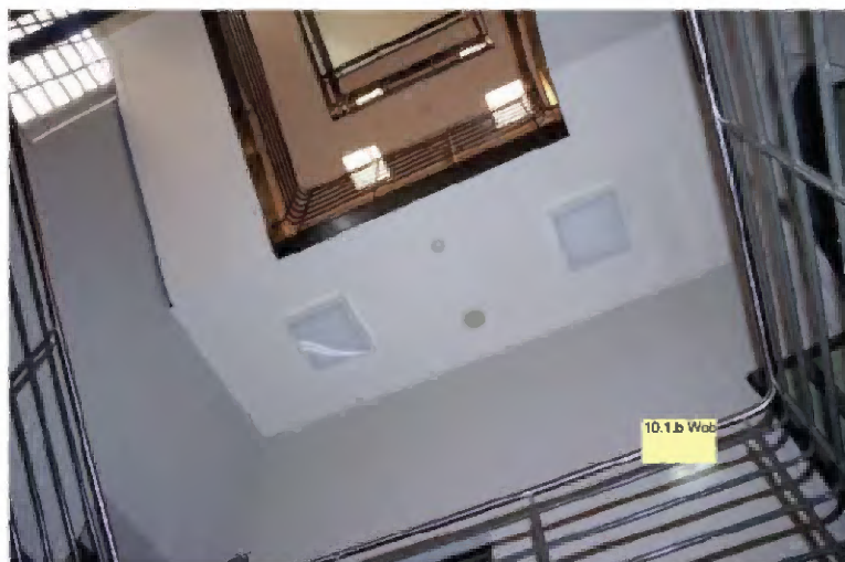
TK-A-334 Trappenhuis (1988-1996), gezien vanuit de kelder.
