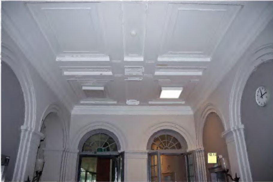
TK-A-351. Cassettenplafond in de hal aan de oostzijde.
