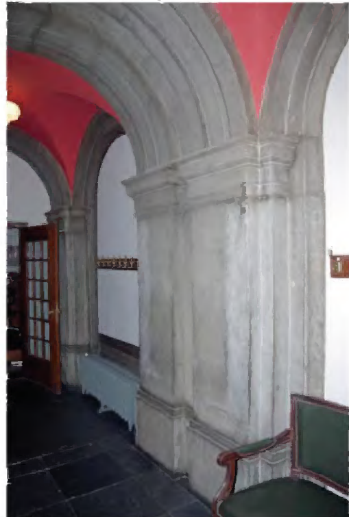
TK-A-253 Interieur gang R.00.01, Detail met hardsteen beklede kolommen. De rondboog nissen zijn dichtgezet. Mogelijk oorspronkelijk een open verbinding met de achtergelegen vestibule in het westelijk avant-corps.
