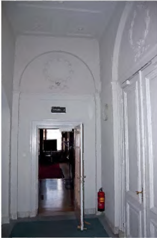
TK-A-161 Interieur hal/vestibule aan de westzijde van de Oude Zaal, gezien in noordelijke richting (naar de Koffiekamer). De stucwerkdecoraties boven de deuren dateren uit 1806. Een deel van de gang werd gewijzigd in hal/vestibule met de nieuwe toegang tot de Oude Zaal (balzaal), rechtstreeks bereikbaar via een nieuwe trapvlucht vanaf de hoofdtrap (zie ook beschrijving hoofdtrap).
