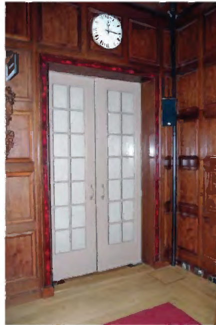
TK-A-152 Vernieuwde dubbele deuren naar rooksalon met imitatie schildpadomlijsting uit 1880.
