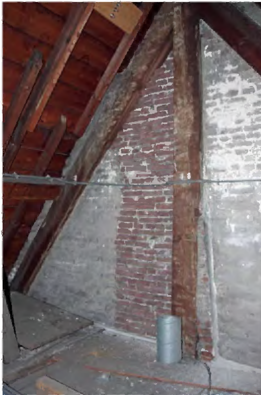
TK-A-211 Dezelfde muur op de vloering van zolder A.03.0.22, opgetrokken bij de bouw in 1879 van het achtergelegen trappenhuis (PvS).
