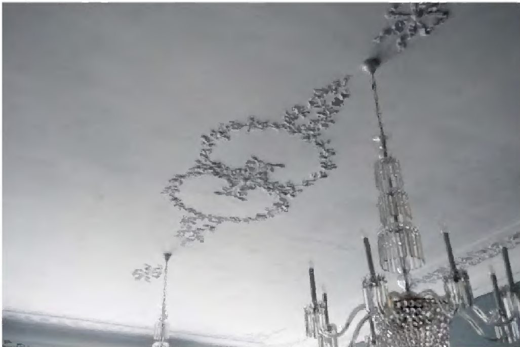
TK-A-288 Interieur R.01.04. Detail stucwerkplafond.
