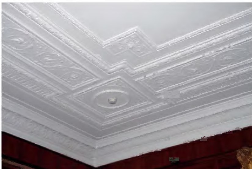
TK-A-154 en TK-A-155 Details van in 2000 gerestaureerd stuc- werkplafond uit 1777- 1790.
