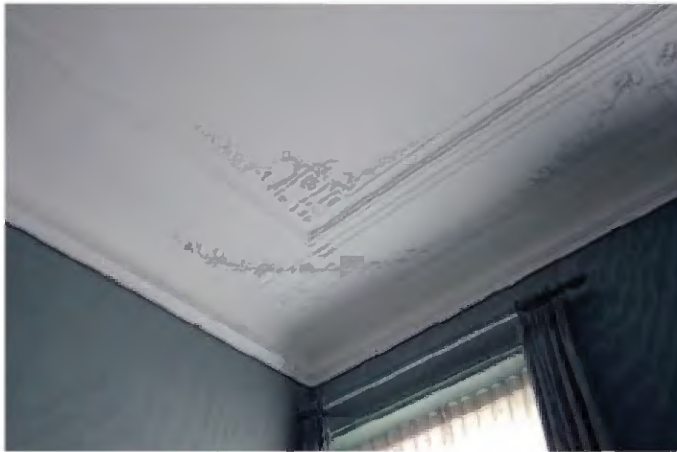
TK-A-290 Interieur R.01.04. Detail stucwerkplafond.
