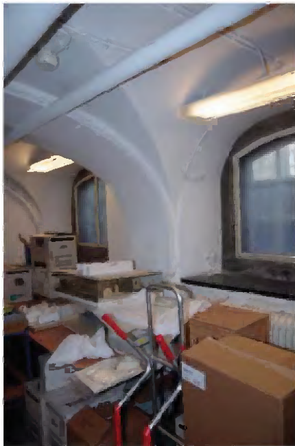
TK-A-247 Interieur kelder R.-1.03, gezien naar het zuidwesten, overdekt door twee ribloze kruisgewelven. In de westwand kelderlichten.
