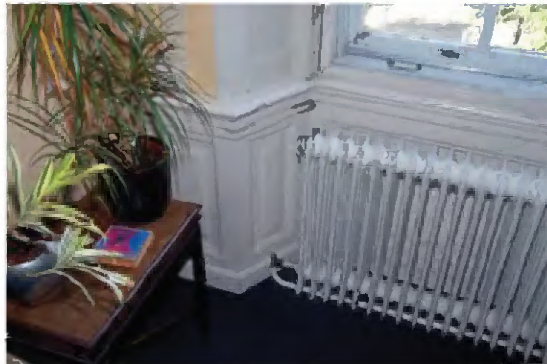
TK-A-304 Lambrisering en betimmering van de dagkanten van de venster uit de bouwtijd (1777-1792).
