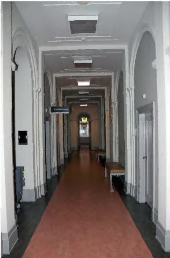
TK-A-352 Interieur gang A.00.1.50, gezien in westelijke richting. De gang is afgescheiden van de ver- trekken rechts van de gang; de oorspronkelijke gang lag aan de linker kant.
