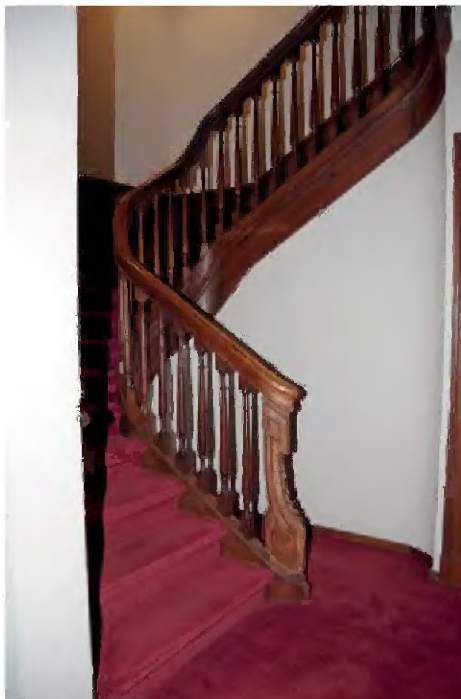
TK-A-341 Begin van de trap op de begane grond.
