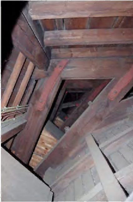
TK-A-236 Detail van de kapconstructie boven het gewelf.
