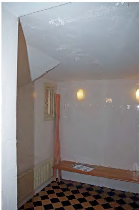
TK-A-261 Interieur R.00.08. Interieur voormalig toilet met raampje naar de binnenplaats. De wand is achttiende-eeuws. Voor het overige is de ruimte gemoderniseerd met verlaagd plafond en tegvloer in de kleur van de negentiende-eeuwse tegelvloer in de gang.
