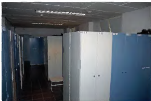
TK-A-113 Interieur A.00.0.05, kleedruimten met verlaagd systeemplafond.
