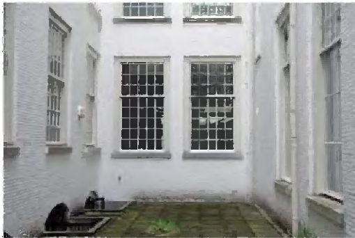
TK-A-317 Binnenplaats Hofplaats 2, gezien in oostelijke richting. Op de begane grond twee vensters van de overloop tussen het dienstgedeelte en het representatieve deel.
