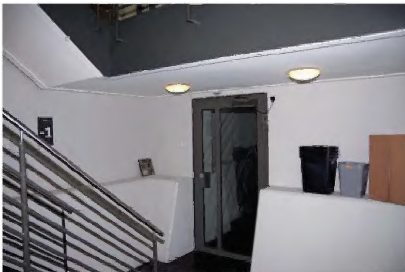
TK-A-333 Interieur kelder A.-1.1.31 met het begin van de trap en de doorgang naar kelderruimte A.-1.1.28. De kelder is uitgegraven (rondom voet van de fundering).
