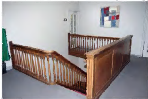
TK-A-346 Overloop met traplanding op de verhoogde zolderverdieping. In dat kader werd de achttiende-eeuwse trap in dezelfde stijl naar boven toe doorgetrokken en kreeg daar een nieuwe balustrade.
