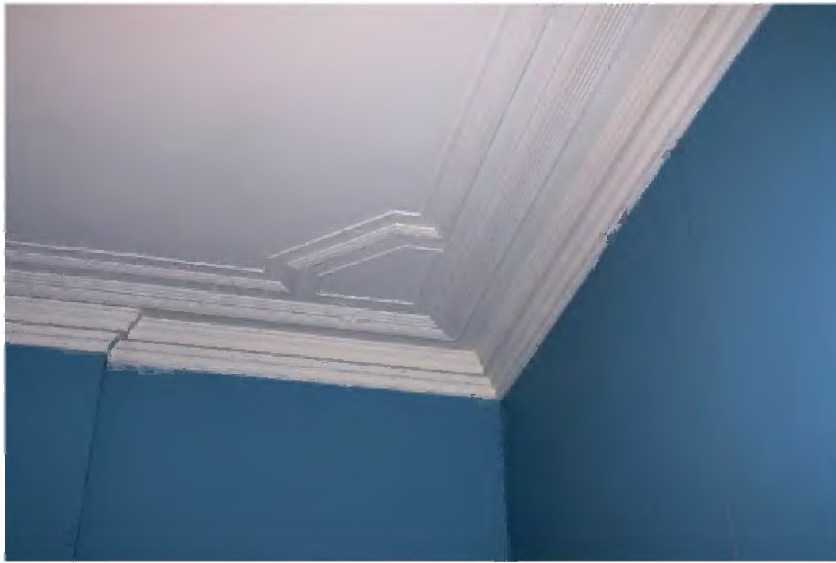
TK-A-279 Ruimte R.01.03 Detail stowerkplafond met geprofileerde randlijst en verkropping bij kroonlijst rookkanaal van de stoekplaats.
