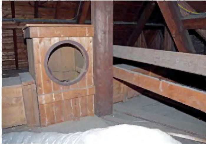
TK-A-223 en TK-A-224 Restant van oud ventilatiesysteem op de vloering boven A.03.0.22. Ook elders in het land zijn dergelijke ventilatiesystemen bekend en deze dateren, dan uit de periode 1870-1890.
