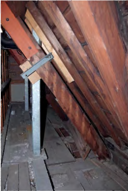
TK-A-219 Zijruimte aan de zuidoostzijde van de inbouw van zolder A.03.0.23 (ter hoogte van avant-corps).
