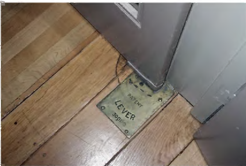
TK-A-160 Detail vloerveer (merk Lever 3001) van de taatsdeur in de sluis tussen de Schrijfkamer en Koffiekamer (hoogstwaarschijnlijk uit 1963).
