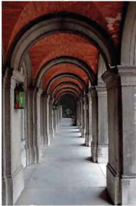
TK-A-8 Galerij op de begane grond overdekt met bakstenen kruisgewelven, gezien in westelijke richting. De pijlers en bogen zijn met hardsteen bekleed. Ook de vloer is belegd met platen hardsteen.
