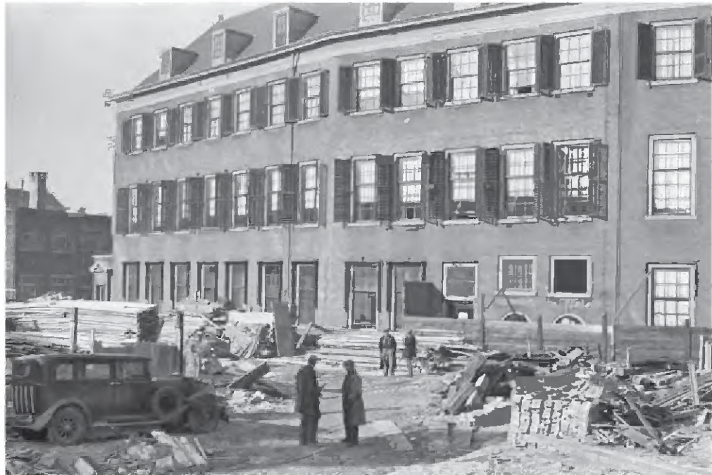
216 Foto van de Hofplaats 2, eind 1959, kort voor de bouw van de Kortenhorst vleugel. Links zijn het tijdelijke kantoorgebouw en het poortje nog zichtbaar. (Herkomt: Haags Gemeentearchief, beeldbank, HGA001057493)
