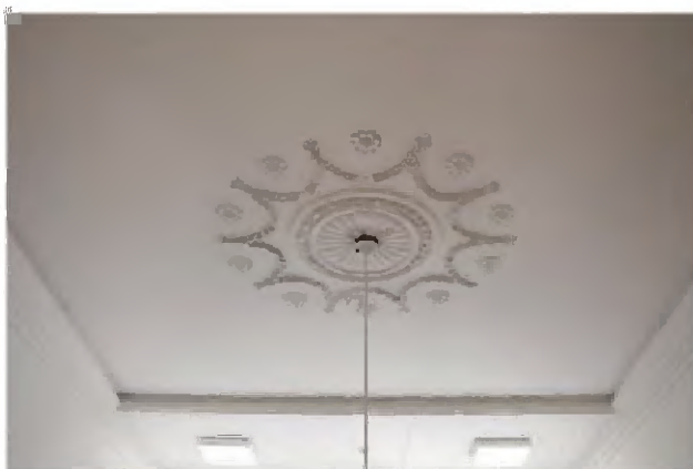
TKA-02 Stuworkeplafond in westelijk trappenhuis uit de bouwtijd.
