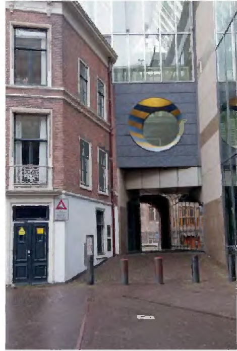
229 De nieuwe situatie waar ter plaatse van Hofsingel 12 een deel van de Schepenhuis is gekomen (verg. afd. 228).
