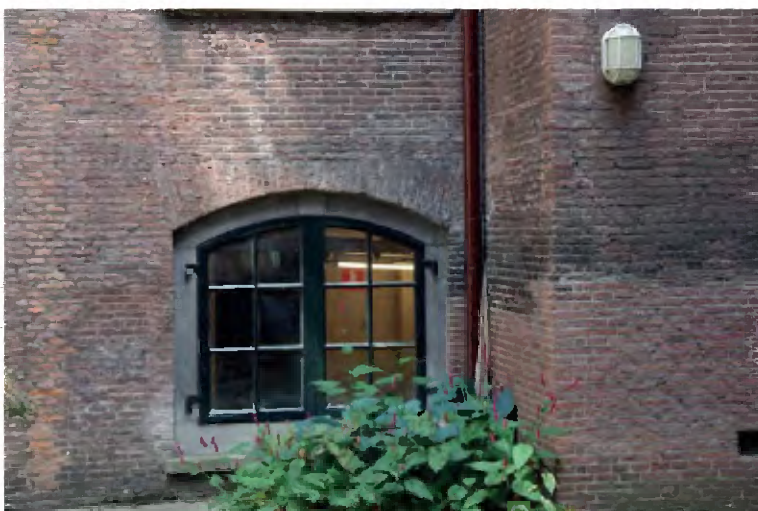
TK-A-15 Detail zuidoosthoek met in de voet van de uitbouw (vm. toiletten) hersteld metselwerk; in het metselwerk zijn hoekklezoren toegepast. Het kelderlicht heeft een hardsteen kozijn.
