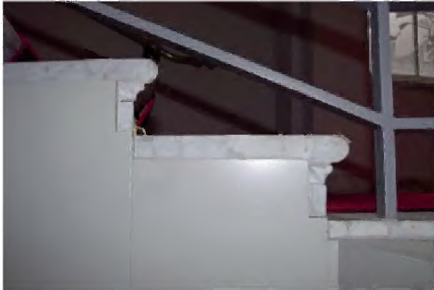
TK-A-78 Detail afge- zaagde trap van 'beton' (Systeem Monier), bekleed met marmer.
