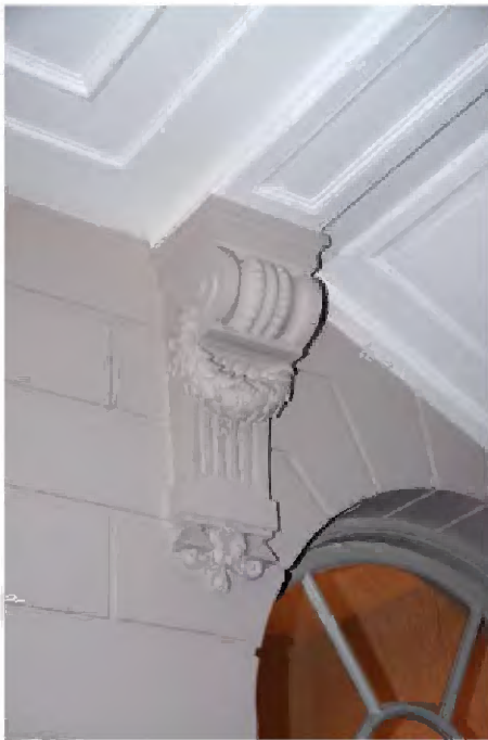
TK-A-100 Detail console (gesausd natuursteen) ter ondersteuning van de balklaag van het trap
