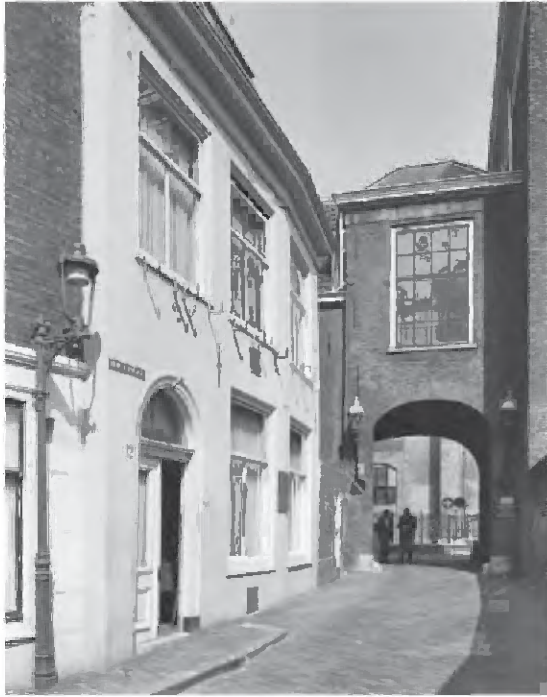
228 Het pand Hofsingel 12 moest voor de bouw van de uitbreiding van de Tweede Kamer wijken. Foto 1968. (Herkomst: Beeldbank RCE, inv. nr. 118.286)
