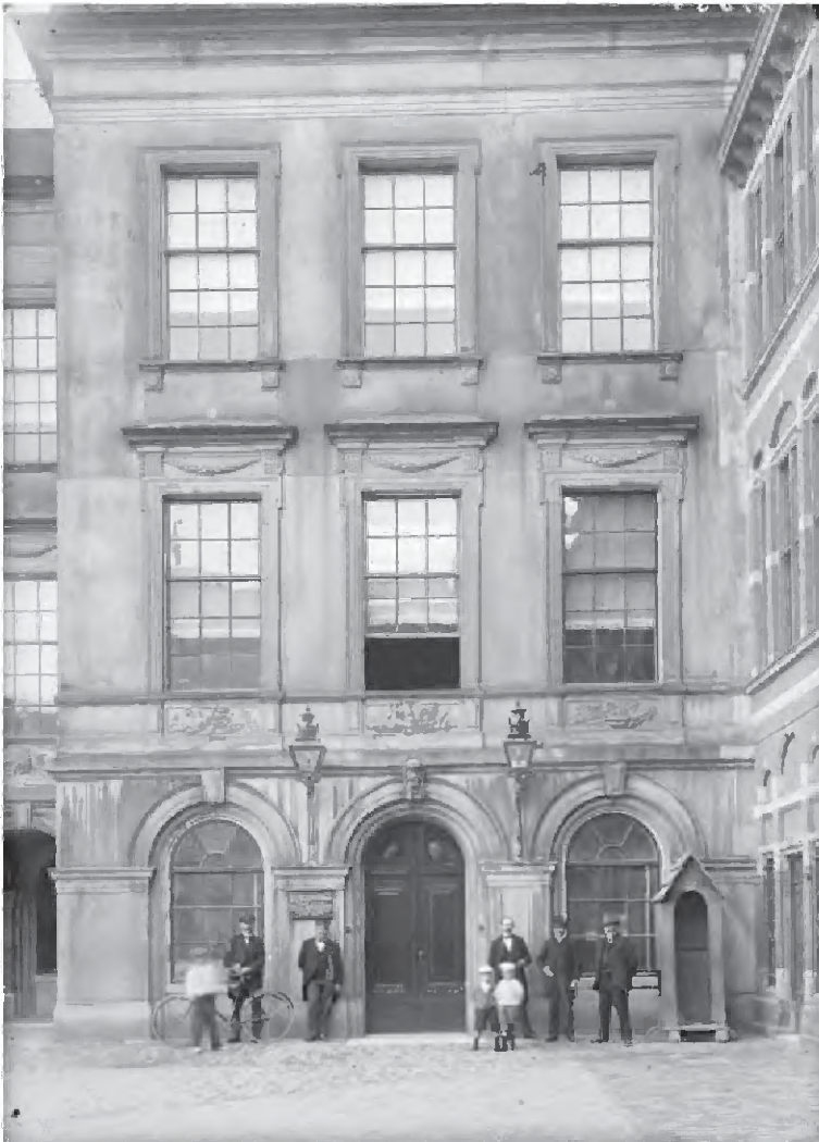
164 Zicht op de façade van het westelijke avant-corps aan de Binnenhofzijde uit 1904 dat - op het wachthousterij na - exact hetzelfde is als het huidige aanzicht (alleen rechts bij de toegang tot de Raad van State is een deur aanwezig die daar bij de verbouwing in 1913 verdwenen). (Herkomst: Beeldbank RCE, inv. nr. 021.834)
