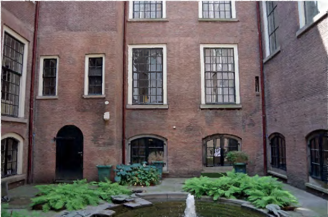
TK-A-16 en TK-A-17 Westgevel met links de aanbouw met een toilet.
