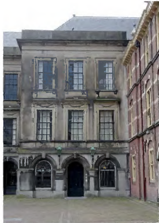
TK-A-5 Westelijk avant-corps.
