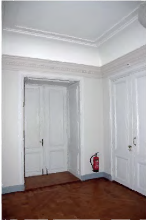
TK-A-95 Interieur overloop 10.1.b Wob op de eerste verdieping. Oorspronkelijk lag hier een lichtschacht naast de diensttrap. Links de verdiept gelegen dubbele deur naar de Oude Zaal; mogelijk waren het oorspronkelijk zo geheten stalsdeuren.
