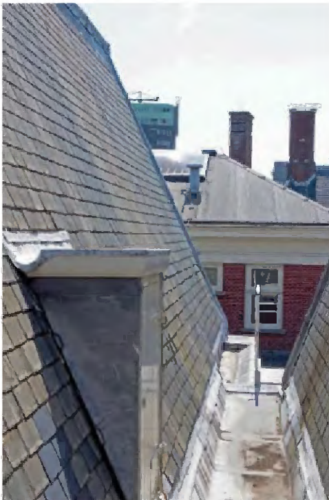
TK-A-27 Zakgoot aan de westzijde van de Oude Zaal (links) en het dak van het westelijk trappenhuis (rechts), gezien in zuidelijke richting (met etage verhoogde Diensgebouw). Via de dakkapel is het westelijk deel van de kap toegankelijk.
