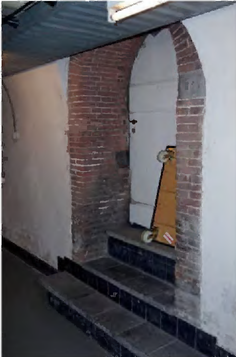
TK-A-34 Opgang met opgeklampte deur naar de grote binnenplaats binnen een nis van schoon metselwerk.
