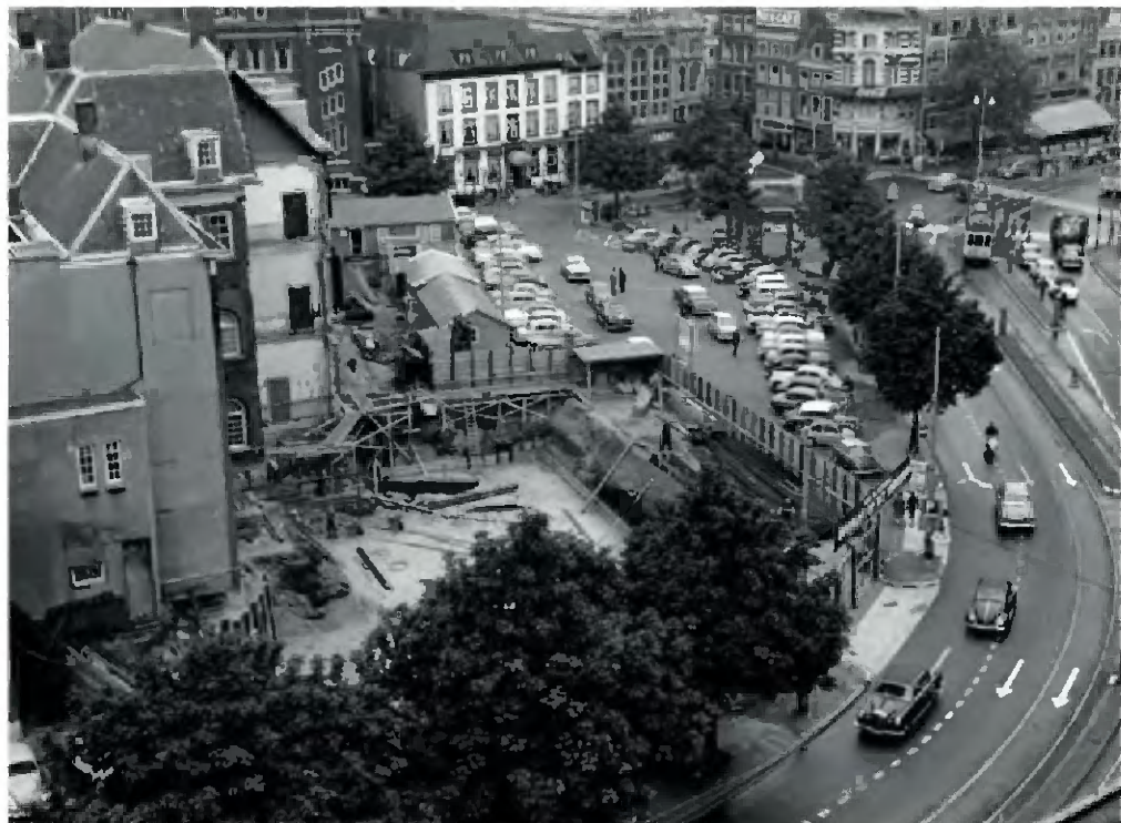
217 Zicht op de bouw van de kelder van de Kortenhorst vleugel, 2 september 1960. (Herkomt: Haags Gemeentearchief, beeldbank, HGA001401684)
