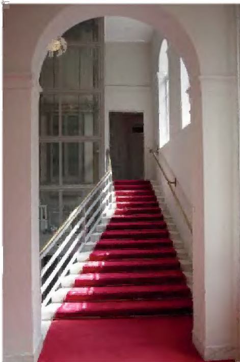
TK-A-76 en TK-A-77 Trapgedeelte uit 1806, vervangen in 1894, naar de Oude Zaal, gezien vanaf en naar het eerste tussenbordes van de hoofdtrap; de trapvlucht is uitgevoerd in cementijzer en bekleed met wit marmer. Trap is in 1988 gedeeltelijk versmald vanwege de inbouw van een lift. De reling aan de rechterzijde is vermoedelijk van de verbouwing in 1894-1895.
