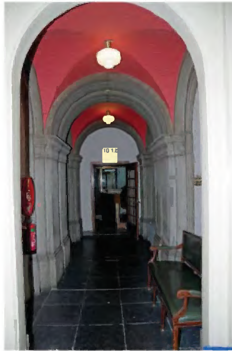
TK-A-9 Interieur van de gang (R.00.0.01) op de begane grond in het voormalig appartement van de stadhouder (thans RvS). De afwerking is gelijk aan die van de arcade (bakstenen gewelven zijn gesausd) en het is mogelijk oorspronkelijk een open galerij geweest.
