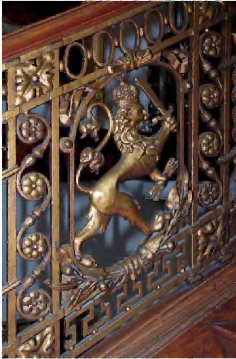
TK-A-82 en TK-A-83 Details gebronsd ijzeren balustrade met houten handlijsten.
