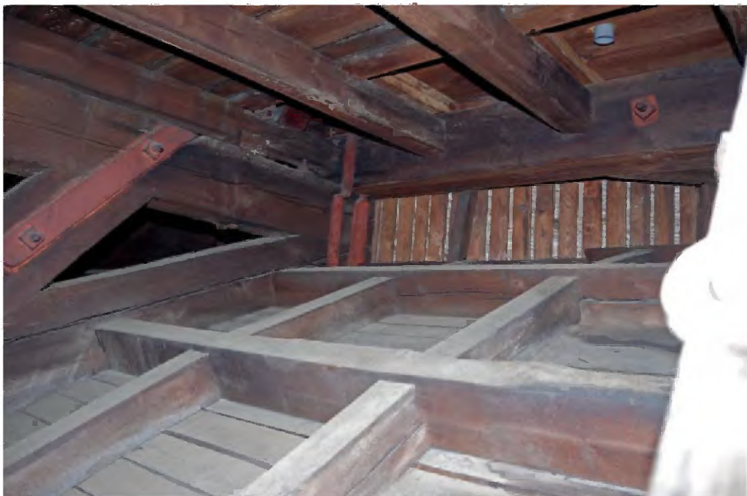
149 Deel van de kapconstructie boven de balzaal met zicht op de verticaal geplaatste planken die aan de andere zijde zijn geplaatst ten behoeve van de draagkracht van de lichtkoepel.
