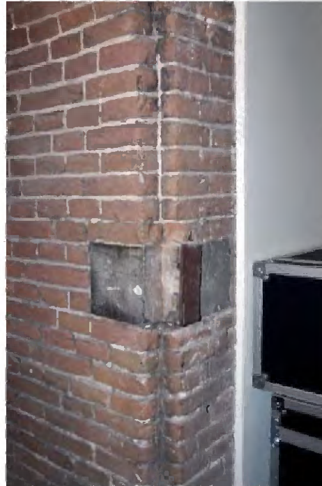
TK-A-35 Detail kozijn met hardsteen blok.
