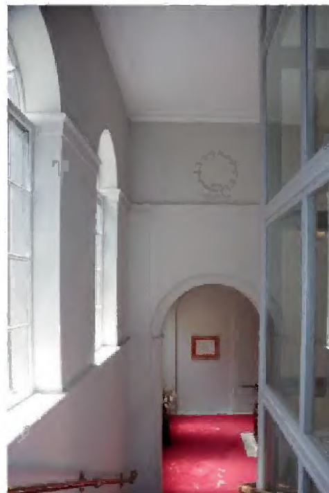
TK-A-76 en TK-A-77 Trapgedeelte uit 1806, vervangen in 1894, naar de Oude Zaal, gezien vanaf en naar het eerste tussenbordes van de hoofdtrap; de trapvlucht is uitgevoerd in cementijzer en bekleed met wit marmer. Trap is in 1988 gedeeltelijk versmald vanwege de inbouw van een lift. De reling aan de rechterzijde is vermoedelijk van de verbouwing in 1894-1895.
