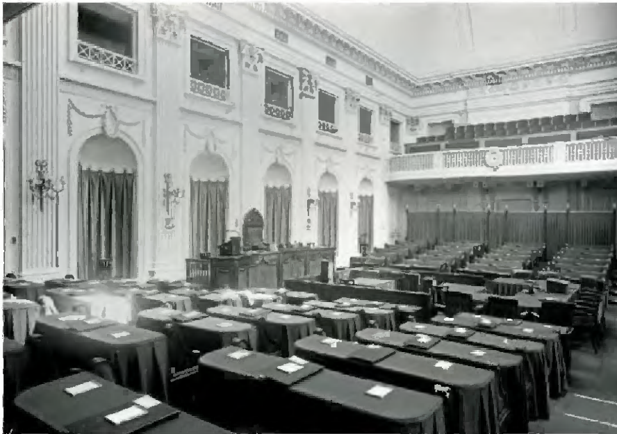
134 De vergaderzaal van de Tweede Kamer rond 1950, gezien naar het oosten. In deze situatie zijn de twee deurpartijen in de noordwand verv angen door nissen. Ook is het balkon aanzienlijk vergroot en is er een tribune aangebracht op het balkon waardoor de klok van de wand op de nieuwe reling is geplaatst (weer in het zicht). (Herkomst: Haags Gemeentearchief, beeldbank, HGA001036876)
