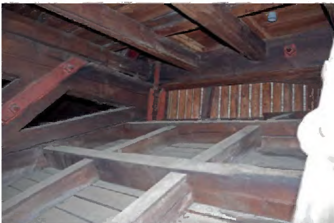
12 Deel van de kapconstructie van de balzaal met bij de verticale planken het later toegevoegde middenlicht.
