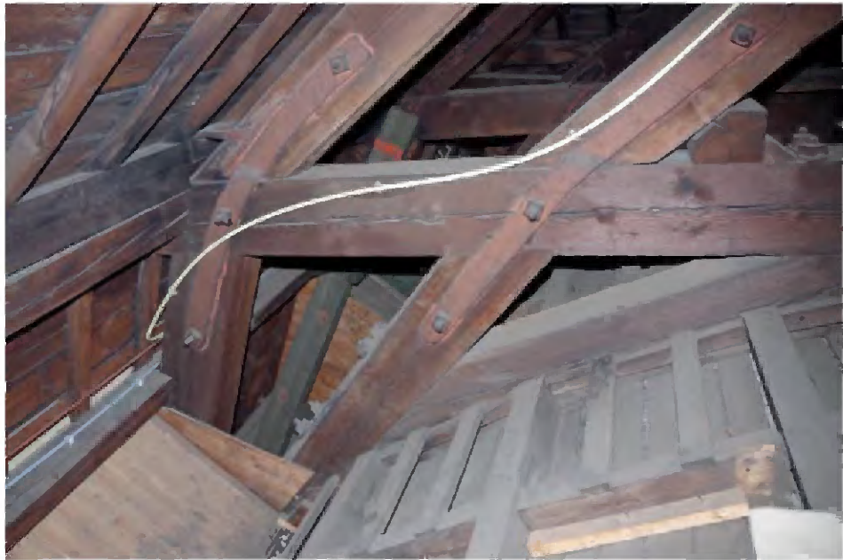
101 Deel van de kapconstructie met horizontaal de jukdekbalk en links bij het dakbeschot het jukbeen, overgaand in de omgekeerde V-vorm. Aan de kant van constructie van het tongwelf de lange schuur die halfhouts in de jukdekbalk is bevestigd en later met ijzer versterkt.
