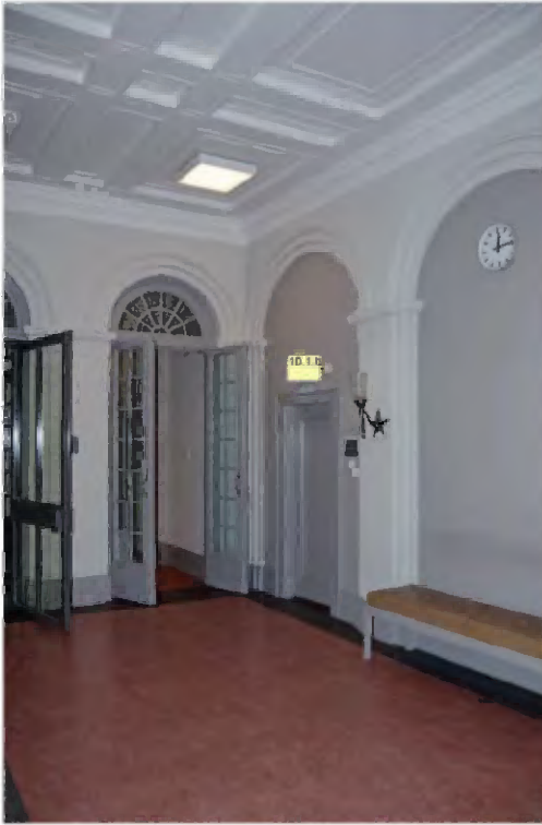
30 Deel van de begin jaren zestig van de twintigste eeuw vormgegeven hal op de begane grond van de Dienstvleugel (waar zich in de achttiende eeuw een deel van de keuken bevond).
