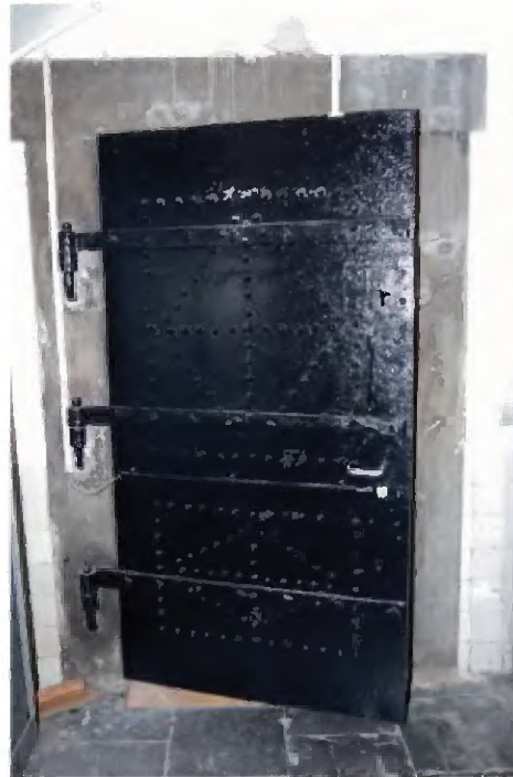
29 De robuuste ijzeren deur, geval in een zandstenen omlijsting, ter afsluiting van een van de kluisdelen in het souterrain van het Comptoir-Generaal.
