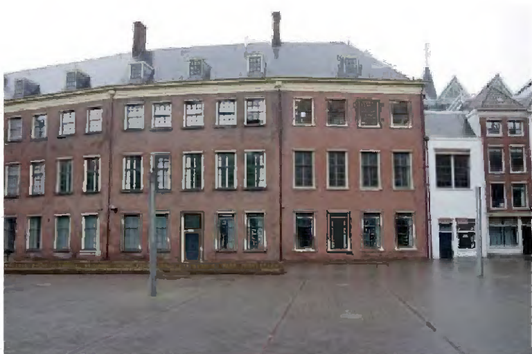
9 Gevels van de Dienst- vleugel van het Nieuw Stadhouders- Kwartier (links), de aanbouw uit 1789 (met deur) en daarnaast de uitbreiding uit 1877 (vier traveeën) en twee van de vier voormalige woningen (rechts) aan de Hofplaats.
