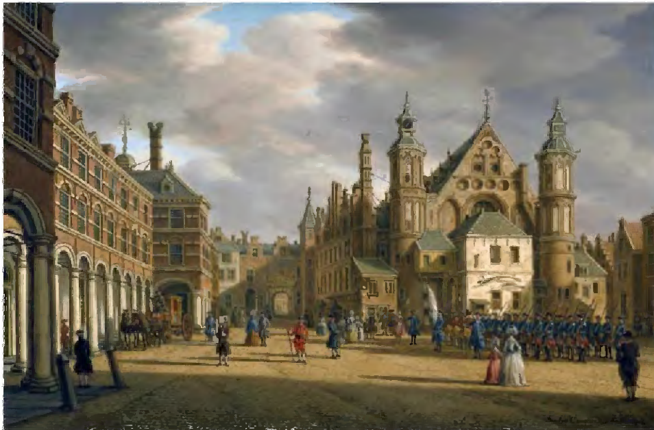
53 De zicht op het Binnenhof en de Ridderzaal door P.C. la Farque, ca. 1773 , met rechts aan de rand de nieuwe gevel van de Landsdrukkerij en links daarvan de gevels van de gebouwen die kort daarna gesloopt werden ten behoeve van de bouw van het Comptoir-Generaal. (Herkomt: commons.wikimedia.org)
