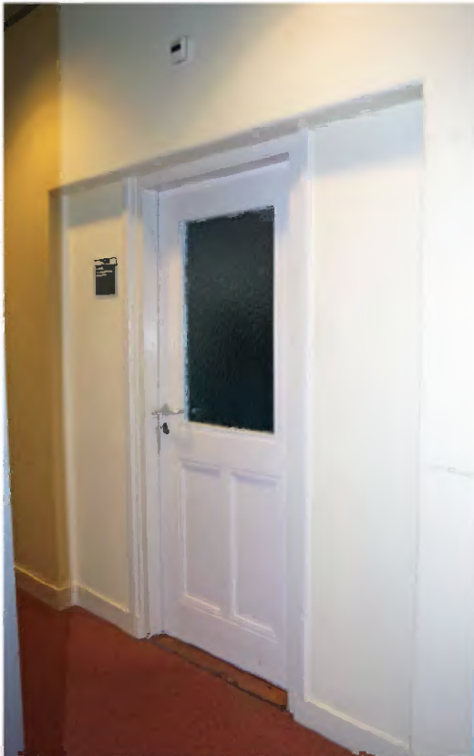
274 Ruimte gang C10.13. In de opening, waar oorspronkelijk twee deuren naast elkaar waren geplaatst, bevindt zich nu één deur uit de bouwtijd die toegang geeft tot kantoor (C0.08a).
