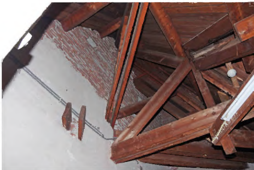
362 Ruimte C2.11a. Aansluiting kapconstructie op de zijmuur van de hal.
