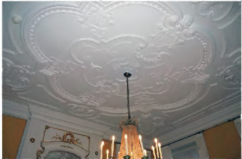
321 Ruimte C1.01. Herplaats achtteende-eeuws stucwerkplafond.
