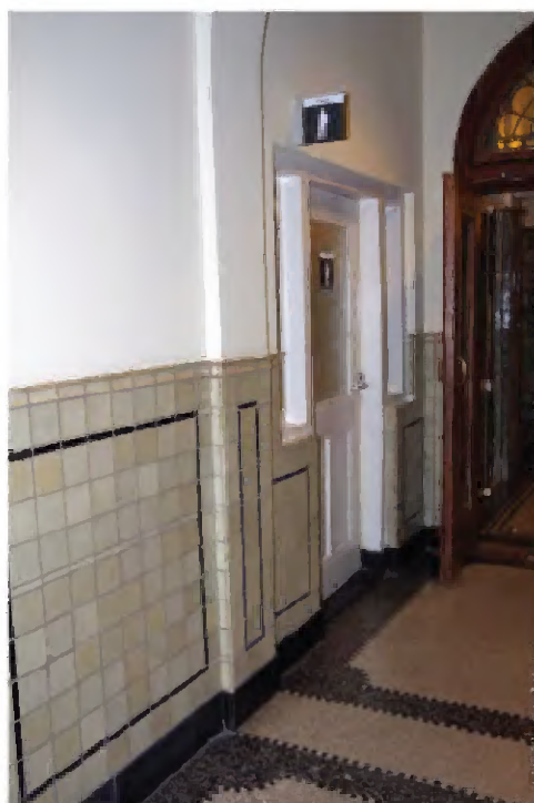
269 Ruimte gang C10.14, met tegellambrisering en granitvloer en een entreepartij opslagruimte (C0.08) aan de westzijde van de gang.
