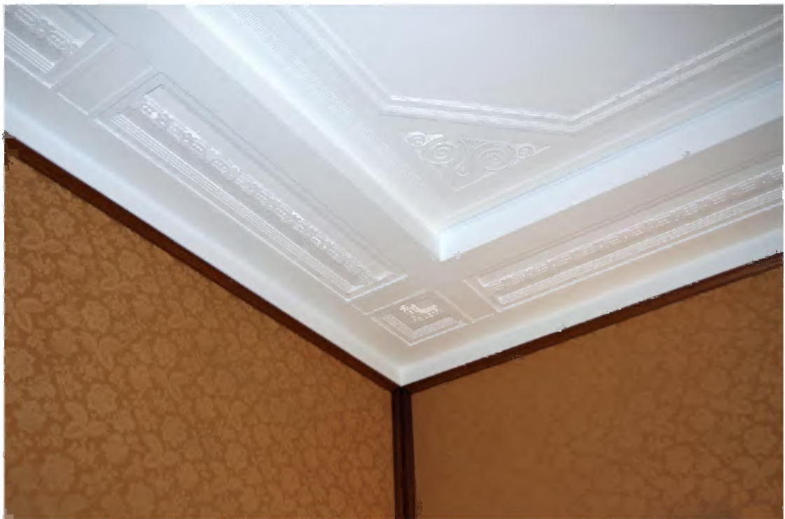
012 Kamersuite Gf.05. Detail en overblijfsel uit de bevestiging.
