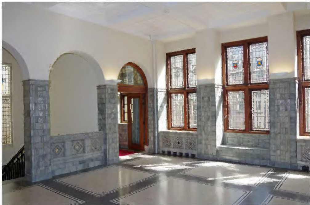
288 Ruimte C11.05, hal met rechts van het trappenhuis de doorgang naar de verbindinggang (C11.16) met het voormalige Ministerie van Koloniën. In het patroon van de granitvloer wordt het cassettenplafond weerspiegeld. Rondom een lambrisering van grijsblauwe tegels. De vensters met houten kruiskozijnen en bovenlichten van deze deur evenals de deuren van de doorgangen naar de zuid- en de oostelijke vleugel zijn voorzien van glas-in-lood met gebrandschilderde ornamenten.
