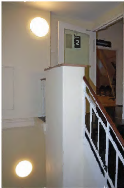
359-360 Ruimte C.12.14, dienststrappenhuis met een betonnen trap en smeedijzeren leuning met houten handlijst; rechthoekige trapspil afgedekt met een plaat Comblarichien kalksteen.
