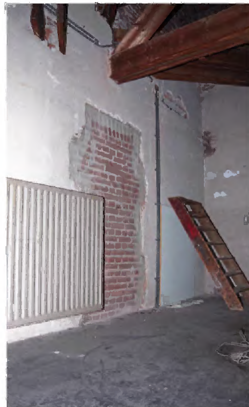
363 Ruimte C2.11. In de zuidelijke (links) zijmuur van de zolder bevindt zich een dichtgezette doorgang naar de hal.
