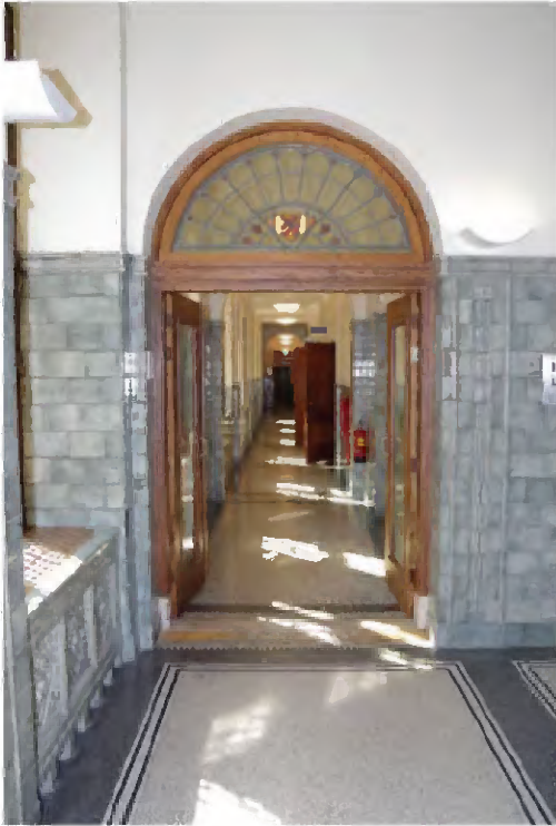
303 Zicht in de gang (ruimte C11.02) in de zuidelijke vleugel, gezien vanuit de centrale hal C11.05 in westelijke richting. De gang heeft een granitovloer en lambrisering van dezelfde grijsblauwe tegels als in de hal. De deuren zijn in gelakt teakhout uitgevoerd. De in vakken verdeelde granitovloer vormt een weerspiegeling van het plafond.
