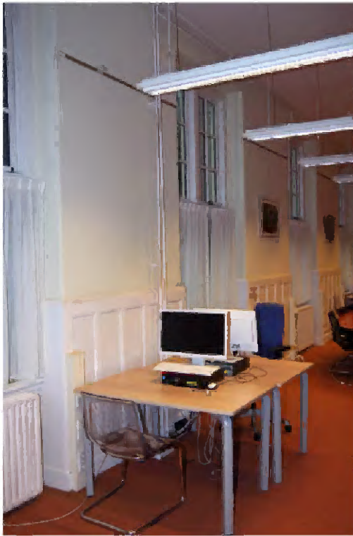
256 Vergaderruimte C10.04. Detail inbouw- ring uit de bouwtijd.
