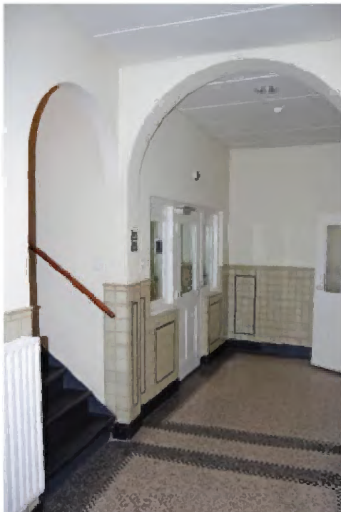
333 Gang, C11.10 met links dienstrap, naar tweede verdieping. De trap, de granitvloer, de betegelde lambrisering en de pui met deuren zijlchten zijn uit de bouw tijd.
