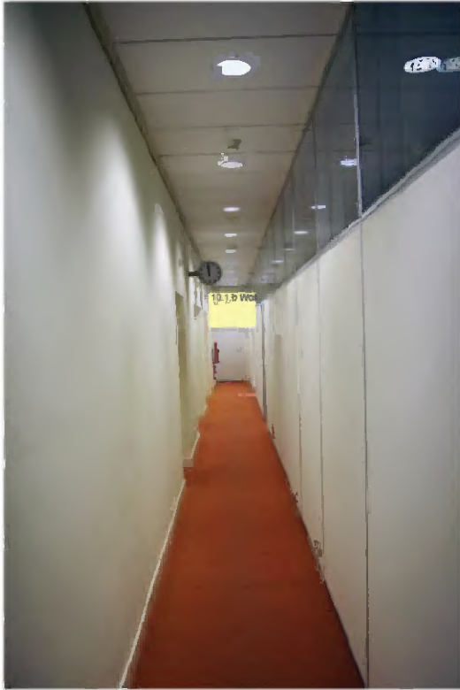
273 Ruimte gang C10.13, met verlaagd systeemplafond; door moderne systeemwand (rechts) afgescheiden van de oorspronkelijk open kantoorruimte. Links oorspronkelijke scheidingswand met entreepuien naar de kantoren aan de westzijde van de oostelijke vleugel die nog uit de bouwtijd dateren.
