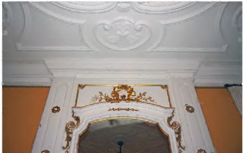
322 Ruimte C1.01. Detail boezem en stucwerkplafond.
