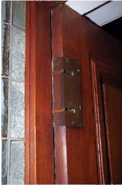
294 Ruimte C11.05, hal, Detail deurscharnier van dubbele deur naar kantoor C11.07, uit de bouwtijd.
