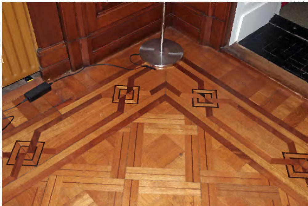
313 Kantoorruimte C1.05. Detail parketvloer uit de bouwtijd.
