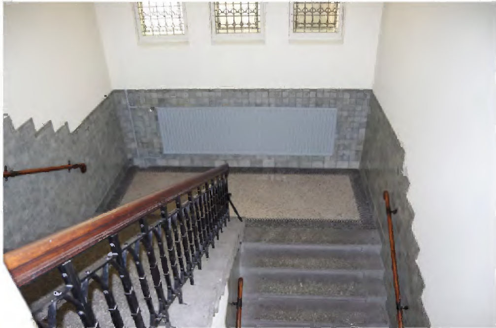
287 Hoofdrappenhuis, ruimte C11.15, met natuurstenen trap, smeedijzeren trapleuning met houten handlijst, granitvloer en betegelde lambrisering, alles uit de bouwtijd.
