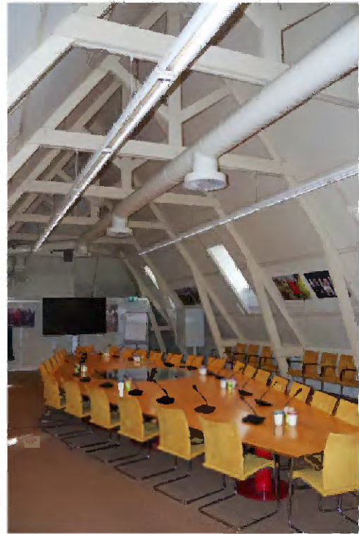
365 Ruimte C2.09, de Grenadierszolder. De kapconstructie uit de bouwtijd van deze zolderverdieping is in het zicht gebleven. De kapconstructie telt zeven spanten met een kreupele stijl, blokkeel, trekplaten en een geschoorde nokstijl. Aan de westzijde zijn er vier dakkapellen en aan de oostzijde drie.
