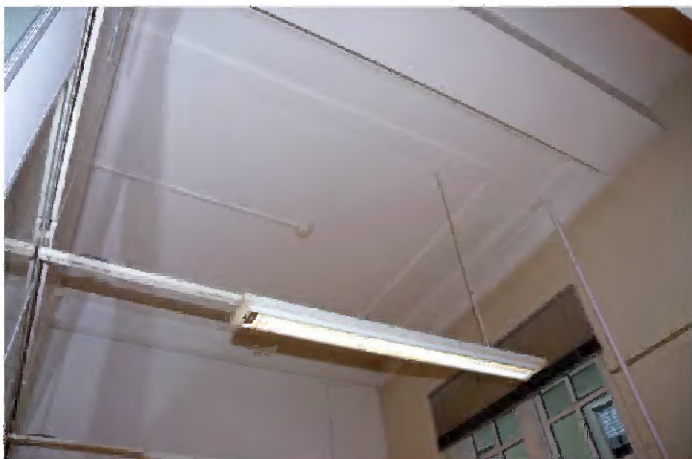
341 Stuworkeleling met geprofileerde randlijst in het oostelijk deel van de oostelijke vleugel uit de bouw tijd.
