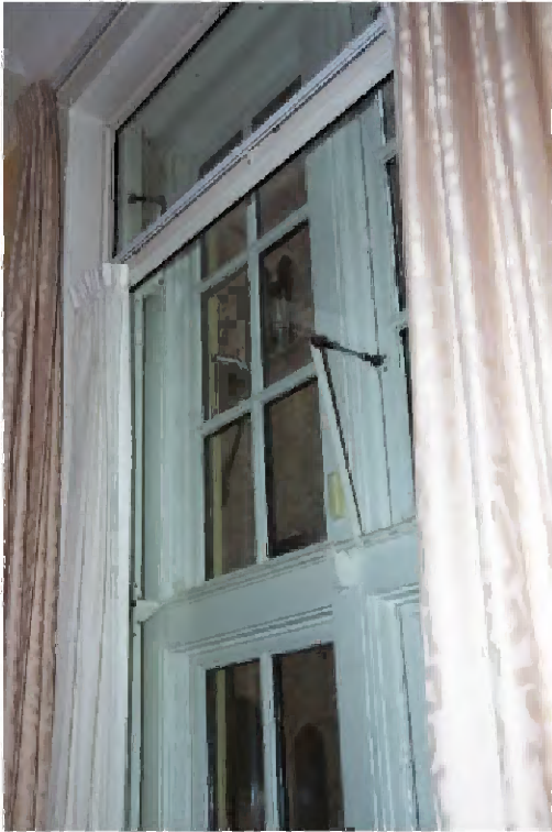
259 Vergaderruimte C10.04. Detail venster met kruiskozijn, bovengedeelte zijn als vakramen uitgevoerd.
