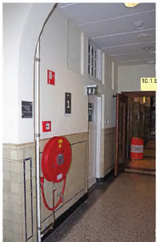
334 Gang C11.10 met links entree toiletten (C11.11); rechts op de achtergrond de houten trapdeuren naar de centrale hal.
