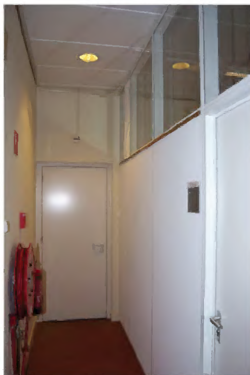
336 Noordelijk uiteinde van de gang C11.09 met deur naar de zolder van het eenlaags bouwdeel (niet toegankelijk).
