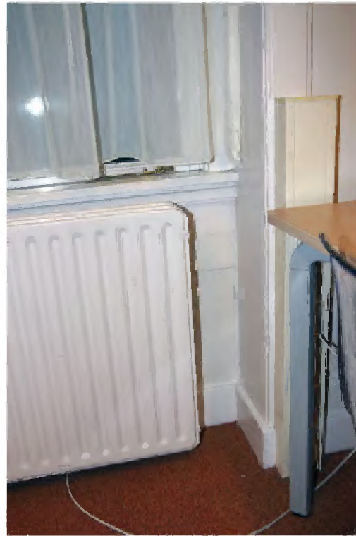
257 Vergaderruimte C10.04. Detail wandaf- werking; onder de vensters een betegeling van wit geschilderde schildpadtegels (vermoed- elijk origineel zoals in de oostelijke vleugel).
