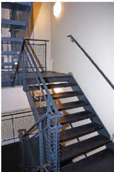
342 Ruimte C11.08, trappenbuis ingebouwd in de castelijke vleugel in de jaren negentig van de vorige eeuw met een stalen trap met houten treden.
