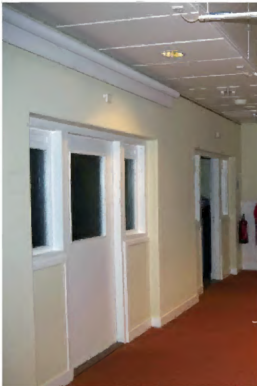
258 Vergaderruimte C10.04. Detail pijl ter plaat- se waar oorspronkelijk twee deuren naast elkaar geplaatst waren.
