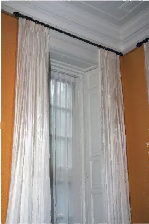
318 Ruimte 01.01. Venster in de noordwand met mogelijk achttiende-eeuwse vouwluiken in de dagkanten.
