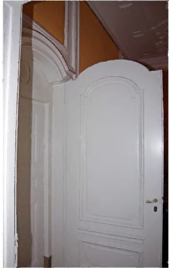
327 Ruimte C1.01. Dubbele deur aan de zuidzijde van het vertrek met een zelfde decoratieve betimmering als in de kast en in de wandnis. De zuidwand bevat ook een schijndeur voor de benodigde symmetrie (zie zijdeafbeelding op de foto).
