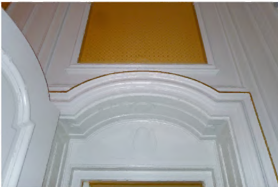
326 Ruimte 01.01. Deurnis (sluisdeur in oostwand) met decoratieve betimmering aan de binnenzijde.
