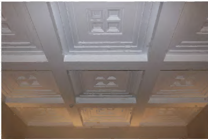
296 Ruimte C11.05, centrale hal, cassettenplafond.
