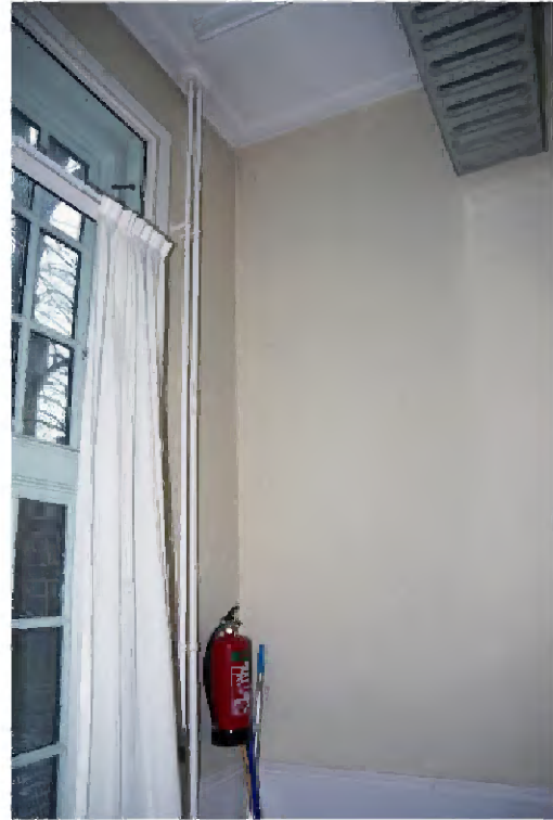
271 Ruimte opslag C10.09, met stucwerk-plafond uit de bouwtijd (met geprofileerde randlijst).
