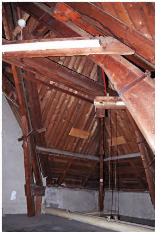
361 Ruimte C2.11a. Zolder boven het hoofdtrappenhuis. De houten kapconstructie met kreupelstijlen en trekplaten als ook het dakbeschot van verticale delen is uit de bouwtijd. De borstwering en zijmuren zijn gedeeltelijk gepleisterd.
