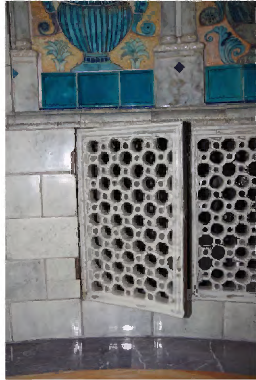
94 Detail van een keramisch paneel voor een verwarmingselement in de voorhal van de Kleine Rechtzaal in het Vredespaleis (foto 2019).
