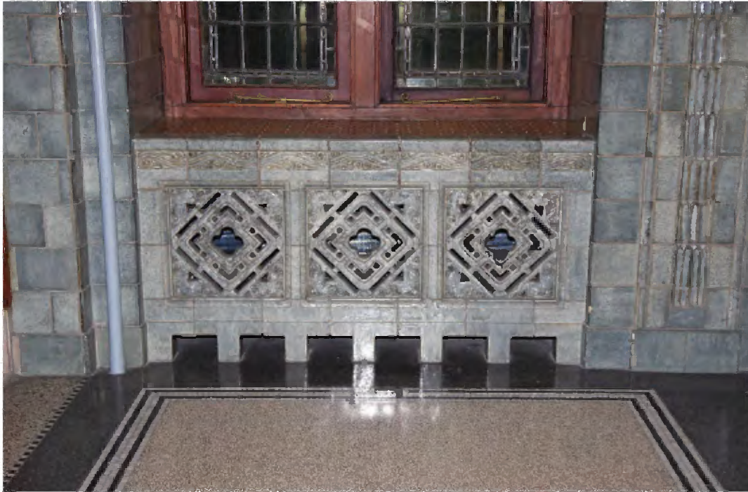
95 Borstweringspanelen op de verdieping van de Uitbreiding Koloniën uitgevoerd in bouwkeramiek van De Porcelyne Fles.
