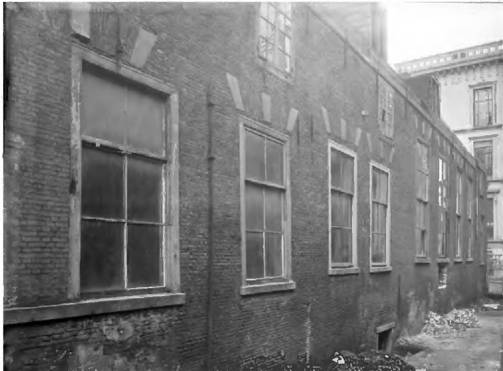
62 De zuidgevel van het gebouw van de Hoge Raad kort voor de sloop in 1915, gezien naar het oosten richting het Ministerie van Koloniën. Halverwege de gevel is een verschrift in de hoogte van de vensters zichtbaar. (Herkomst: RCE)
