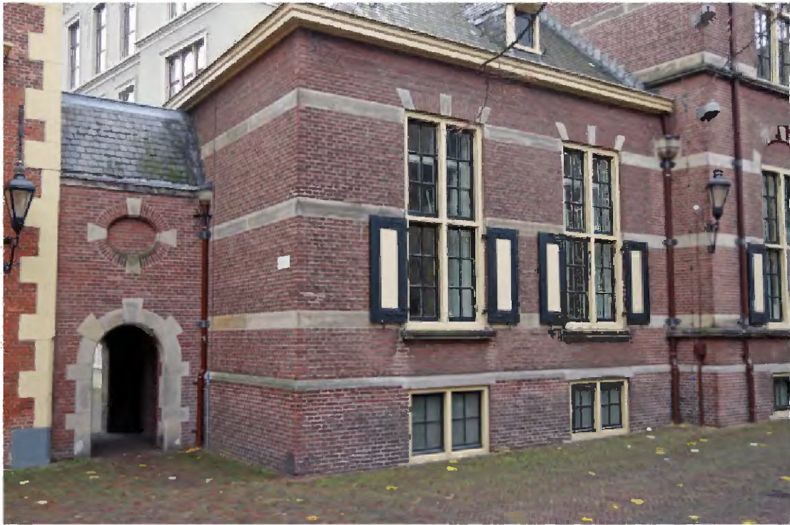
168 De huidige situatie, gezien vanaf ongeveer dezelfde plek.
