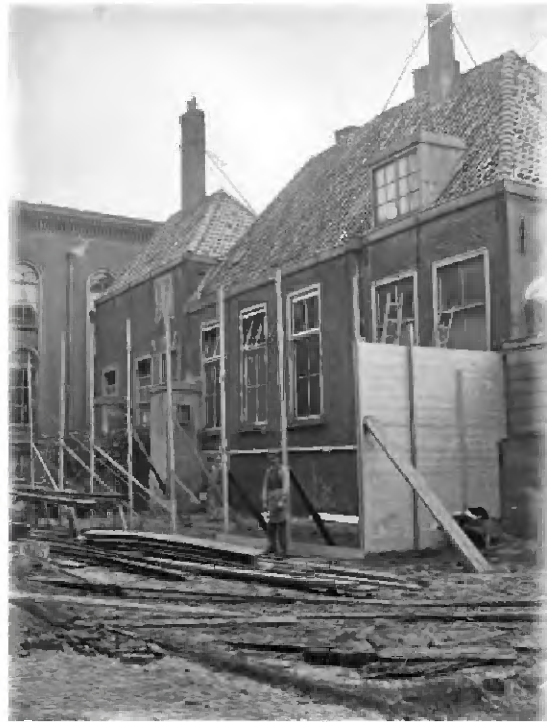
66 De oostelijke gevel van het gebouw van de Hoge Raad (met rondboogvensters ). In het midden is de gepleisterde toiletuitbouw zichtbaar die uitkwam op de inmiddels gedempte Hofgracht, daar waar op de foto de schutting wordt gebouwd. (Herkomst: RCE)
