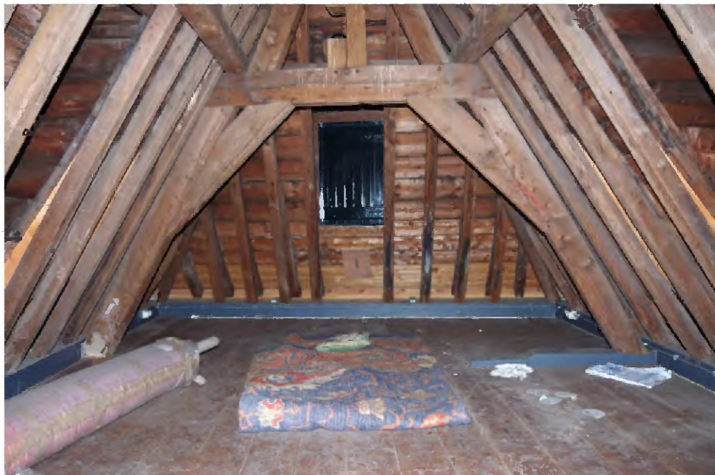
8 De uit de bouwtijd daterende kappconstructie van de Grenadierspoort, gezien naar het zuiden.
