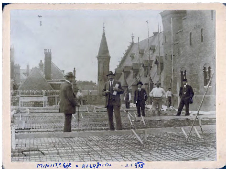
87 Bouw van de Uitbreiding Koloniën met de wapening voor de eerste verdieping vloer in 1916. Waarschijnlijk is een van de afgebeelde personen de assistent-rijksbouwmeester Teunissen. (Herkomst: Haagse Beeldbank)
