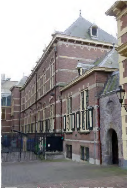
11 De oostgevel van Uitbreiding Koloniën aan de zijde van het Plein, gezien naar de buitenhoek van beide vleugels waar zich ook de verbinding met het voorm. Ministerie van Koloniën bevindt
