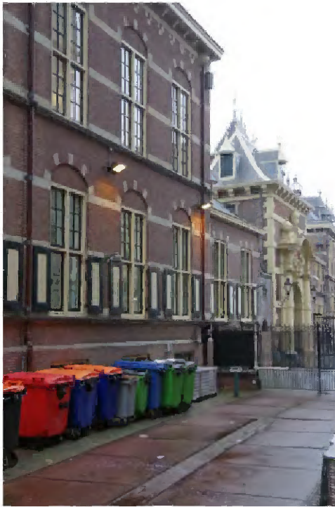
65 De huidige situatie, gezien vanaf ongeveer dezelfde plek.
