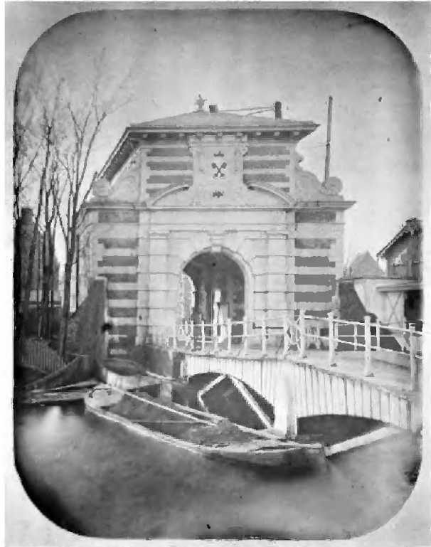
40 Foto genomen kort voor de sloop in 1867 van buitenzijde van de Rijsburgerpoort in Leiden gebouwd in 1632-1633 naar ontwerp van Jan Jacobsz. van Banchett met Dorische pilasters en natuursteenbanden. (Herkomst: RCE)
