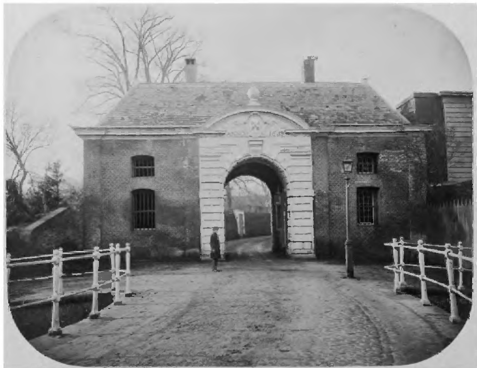
41 Foto genomen kort voor de sloop van de Hogewegspoort in Leiden uit 1659. De buitenzijde van deze poort lijkt sterk op de binnenzijde van de Granadierspoort. (Herkomst: RCE)
