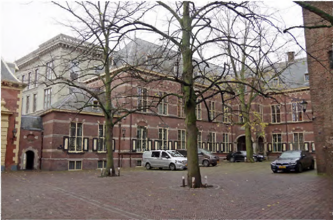
9 De Uitbreiding Koloniën met zijn beide haakvormig geplaatste vleugels met aan de linkzijde een lager deel en in de binnenhoek een uitbouw met de (oorspronkelijke) ingangspartij.
