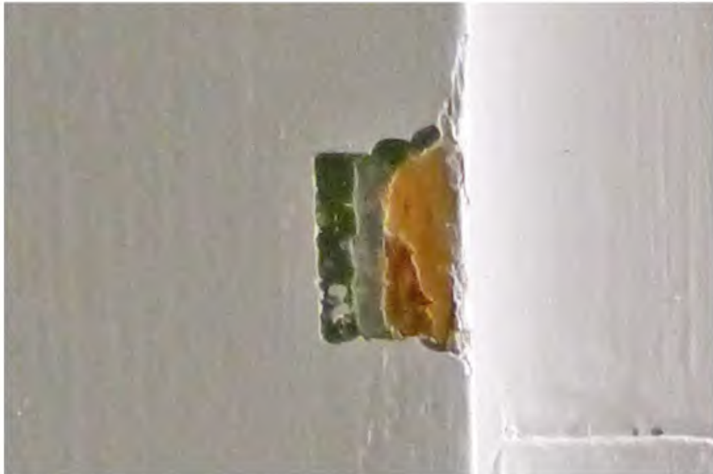
33 Verpakket op de dagkant van het deurkozijn met (v.r.n.l.) als eerste afwerking een houtimitatie, ook hier gevolgd door een groenig grijze en een groene verflaag (NCS S 5040-G40Y). De huidige afwerking is een witte verf.
