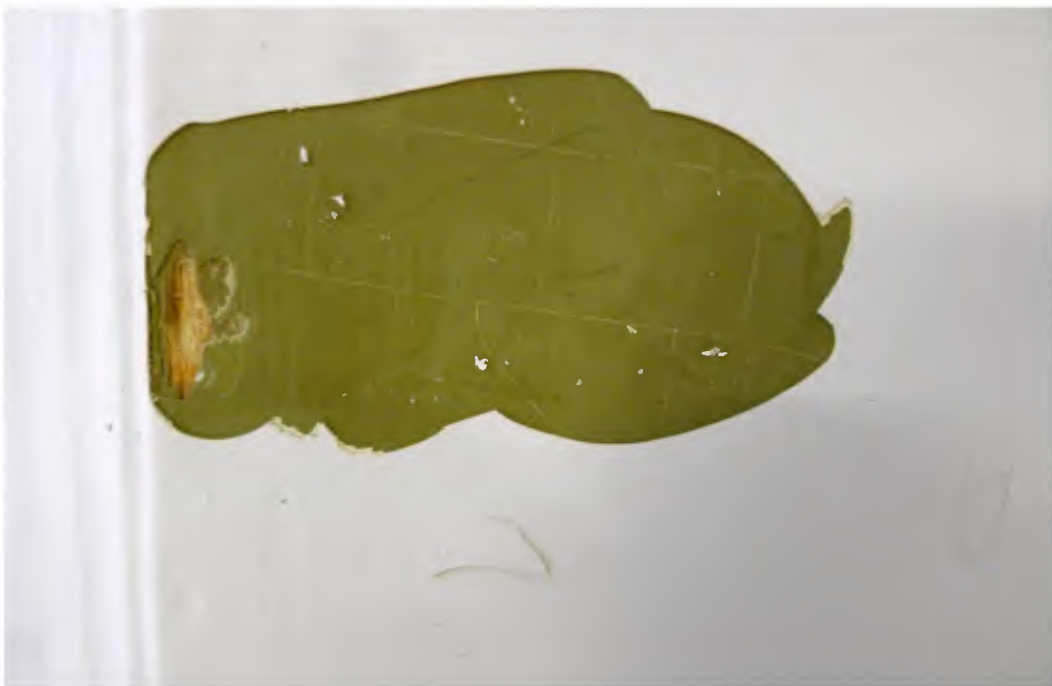
43 Op de stijlen van het houten raam is behalve de huidige witte verfafwerking een olijfgroene verf in twee lagen aangetroffen, die ook op de gietijzeren onderdelen is gevonden. Als eerste is een lichte grondlaag voor een houtimitatie zichtbaar. De bijbehorende vernis is niet vrij gelegd.
