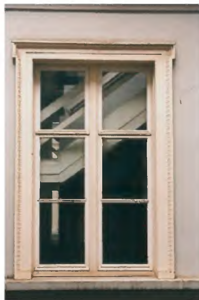
7 Foto 1996. Venster (1859) in zijgevel van het trappenhuis op de tweede verdieping met gietijzeren omlijsting. Het gehele venster is lichtroze van kleur. (Herkomst foto: Kamphuis & Vlaardingebroek 1996)
