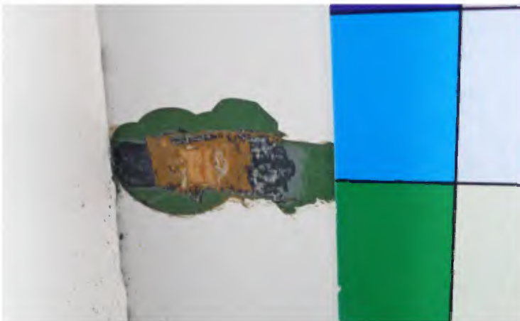
56 Verfpakket op het raam met als eerste afwerking een roodbruine houtimitatie. Verder een donkerbruine verf en een groene verf op een grijze grondlaag. De daarop volgende verflagen zijn niet vrij gelegd.
