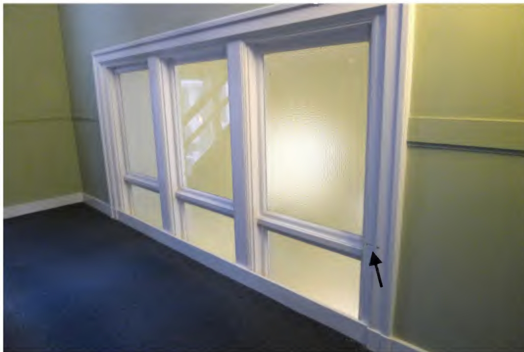
35 Houten kozijn in het trappenhuis; aan de achterzijde bevindt zich het gietijzeren buitenkozijn (1859) dat in 1883 in het interieur is geraakt.
