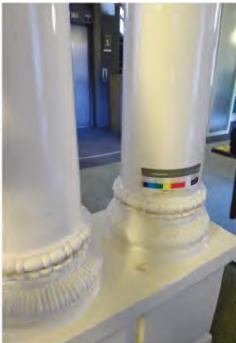
20 Sokkel en voet van de kolommen.
