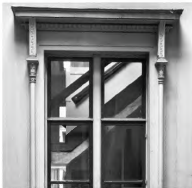
6 Foto ca. 1969. Venster (1859) in zijgevel trappenhuis met oorspronkelijke gietijzeren omlijsting (inclusief kroonlijst en zuiltjes) op de eerste verdieping (jaren zestig van de vorige eeuw). De ramen zijn donker (groen) van kleur. (Herkomst foto: Polderman 2019)
