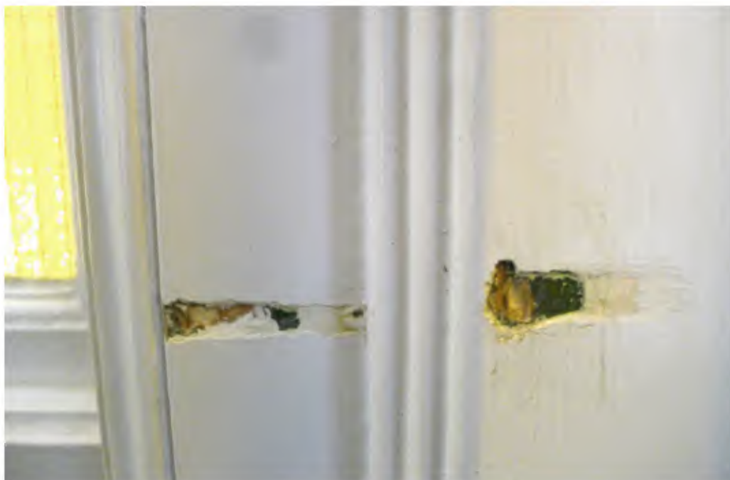
36 Verfpakket op raam en kozijn.
