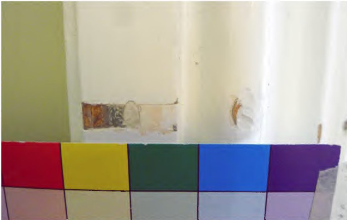
67 Het verfpakket op platstuk van het kozijn bestaat uit roodbruine houtimitatie als eerste afwerking, lichte grondlaag, gelig groene verflaag, groene verflaag (NCS S 5040-G40Y), roomwitte grond- en verflaag, heel lichtroze (grond)laag, als laatste huidige witte verf.
