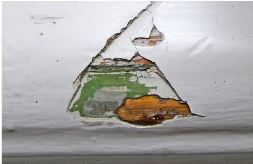
30 In de beschadiging van de verfafwerking op de vensterbank is eveneens een roodbruine houtimitatie als eerste afwerking zichtbaar alsmede een paarsbruine verflaag en groene verflaag (NCS S 5040-G40Y) op een grijze grondlaag als latere afwerking.
