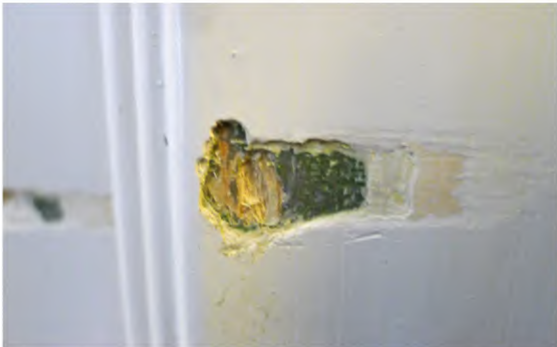
38 De eerste afwerking is een roodbruine houtimitatie (restanten) gevolgd door een grijze grondlaag en een groene verflaag (NCS S 5040-G40Y), vervolgens een pakket van witte verflagen in diverse tinten. De laatste (huidige) afwerking is een witte verf op een witte grondlaag.
