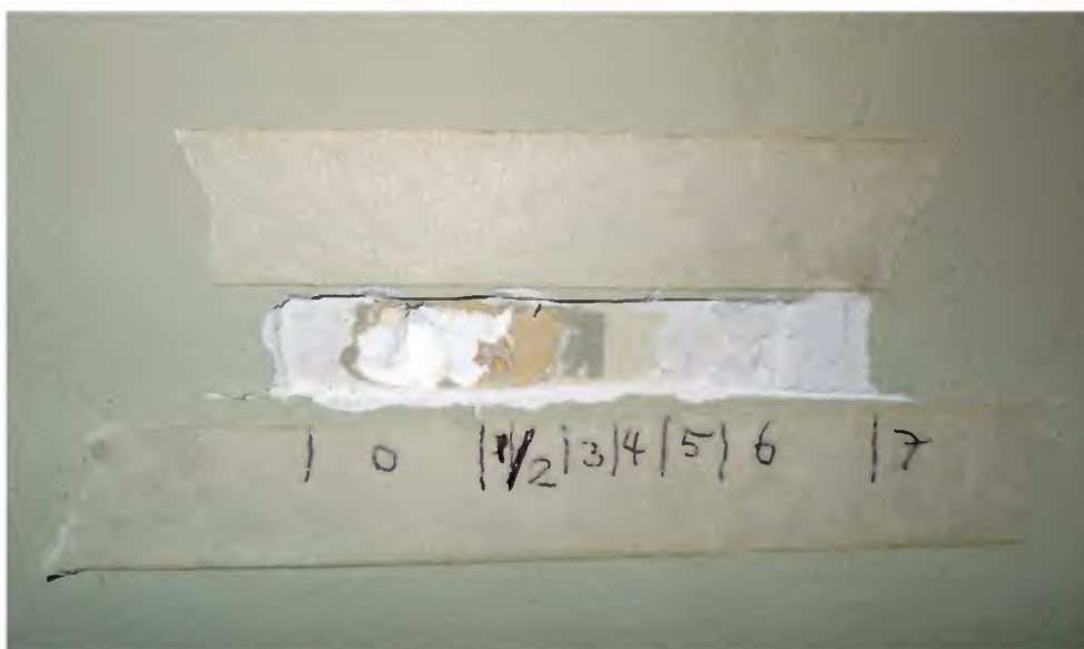
47 De afwerking van de wand bestaat uit gips stucwerk (0), dat meerdere malen gesausd is (muurverf). De eerste afwerking (1/2 moeilijk vrij te leggen) is een okerkleurige verflaag en een iets grijzere verflaag, (3) lichtgrijze verflaag, (4) roomwitte verflaag, (5) heel lichtroze (hecht)laag, (6) dikkere laag gipsstuc en (7) huidige groenige grijze afwerking.
