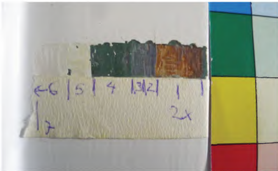
58 Het verpakket op het kozijn bestaat uit (1) roodbruine houtimitatie, (2/3) grijze grondverf, (4) groene verf, (5) roomwitte verf, (6) witte (grond)verf en (7) als laatste een witte verf.
