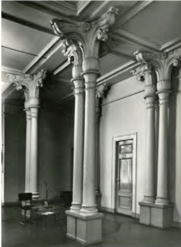
10a De hal op de eerste verdieping in 1969 met viertal gietijzeren kolommen uit 1859. Basement is donkerder van kleur dan de kolom. (Herkomst foto: Polderman 2019)
