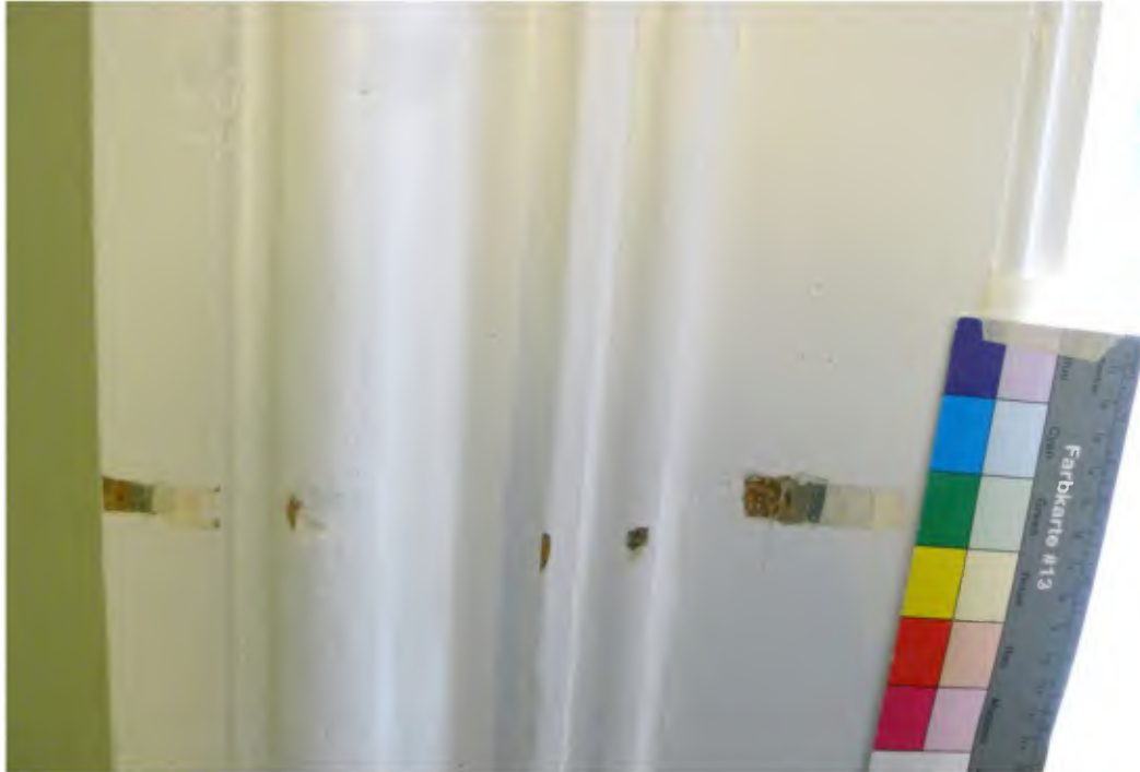
65 Verschillende onderzoekspunten op het kozijn.
