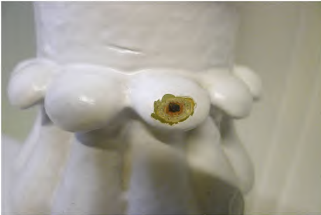
42 Toverbal op bladuiteinde van de voet van de kolom. De eerste afwerking op een rode menie is een roze verf; deze komt later nog een keer, iets lichter, terug voordat een olijfgroene verf werd aangebracht; de laatste afwerkingen zijn een witte, lichtgrijze en witte verf.
