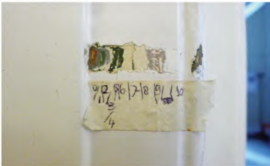
49 Uitgebreid verfpakket op het deurkozijn bestaande uit een roodbruine houtimitatie als eerste afwerking (1/2), tweemaal een groene verf op een grijze grondlaag (3 t/m 6), een roomwitte verf op een witte grondlaag (7 en 8), een grijze grondlaag (9) en als laatste een witte verflaag (10).
