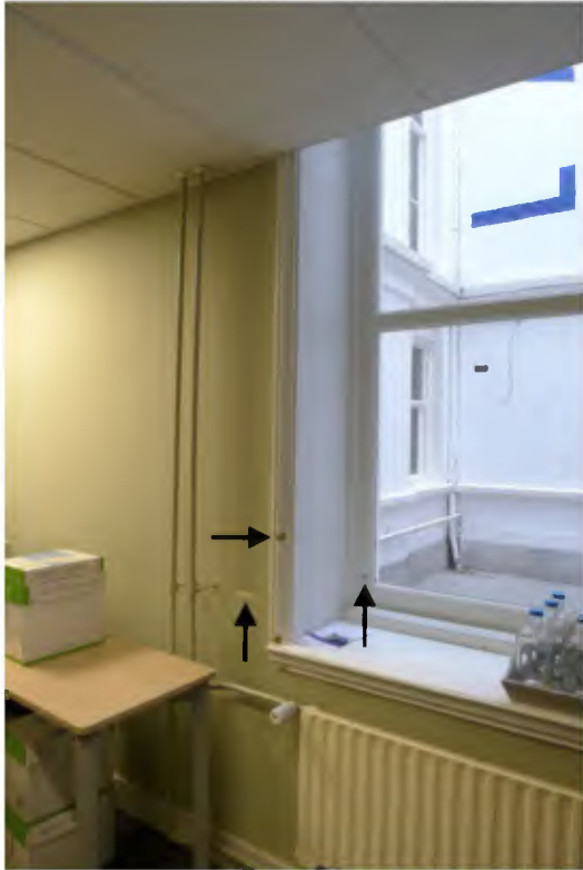
12 Interieur begane grond met onderzoekspunten wand (1) en venster (2) aan oostzijde van noordelijke binnenplaats. De wand (1859) is altijd een binnenwand geweest. De vensterpartij is in aanleg uit de bouwtijd. Mogelijk is het raam of zijn delen ervan vernieuwd.
