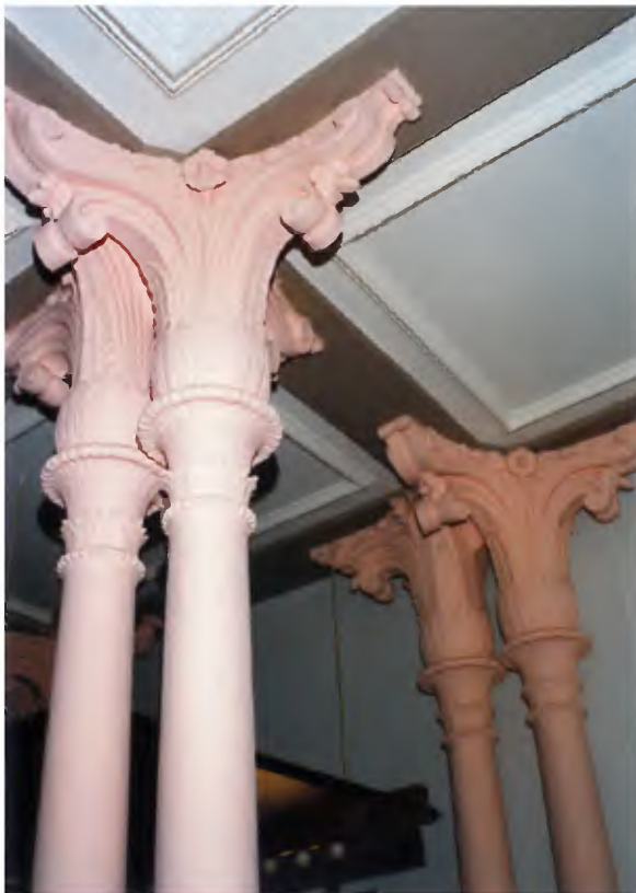
10b De hal in 1997. De kolommen zijn roze geschilderd. Of dit een op dat moment bestaande afwerking is of een grondlaag voor een toekomstige afwerking is onduidelijk. Het plafond heeft een polychrome afwerking. (Herkomst foto: Kamphuis & Vlaardingbroek 1996)
