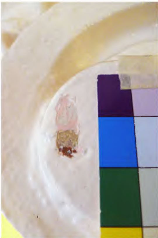
24 Voluut van kapiteel. Het verfpakket op een rode ijzermolie bestaat uit meerdere lagen; als eerste een lichtgrijze (grond)laag, een roze verflaag (NCS S 1515-Y40R), een lichte okergele verflaag, een witte (grond)laag, een roze verf- of grondlaag en een dikke witte verflaag (huidige afwerking).
