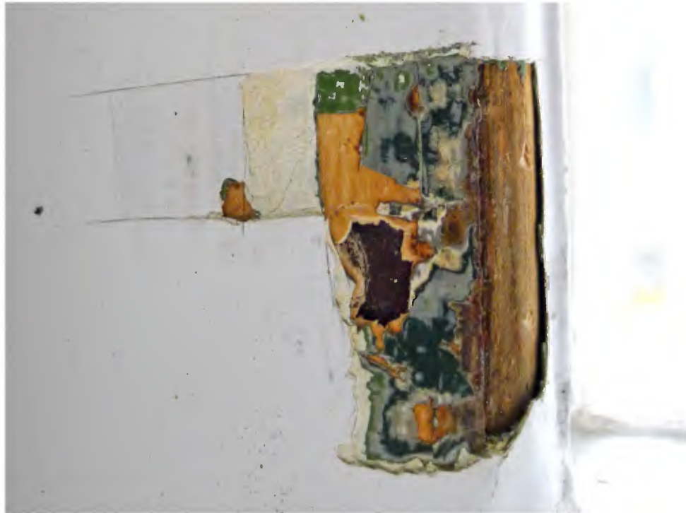
29 Op het raam bestaat het verfpakket uit meerdere lagen. Met een roodbruine houtimitatie als eerste afwerking, gevolgd door paarsbruine verf (tweede houtimitatie?), een zeer donkergroene verf op grijze grondlaag, een groene verf op grijze grondlaag, een roomwitte verf en de huidige witte verf op witte grondlaag.
