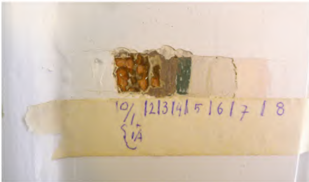
66 Het verfpakket bestaat uit (1/1a) roodbruine houtimitatie als eerste afwerking, (2) lichte grondlaag, (3) gelig groene verflaag, (4) groene verflaag (NCS S 5040-G40Y), (5, 6) roomwitte grond- en verflaag, (7) heel lichtroze (grond)laag, (8) als laatste huidige witte verf.
