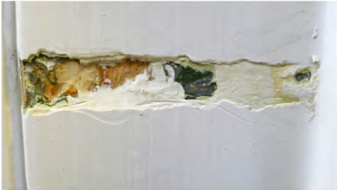
37 Het verfpakket bestaat uit meerdere lagen. Er is als eerste afwerking een roodbruine houtimitatie (restanten) aangetroffen (links op de foto), twee groene verflagen (een wat lichtere en wat donkerder groen NCS S 5040-G40Y en NCS S 5040-G20Y) op een grijze grondlaag en een tamelijk dikke laag stuc of grondering mogelijk om een beschadiging uit te vlakken, vervolgens een pakket van witte verflagen in verschillende tinten. De laatste (huidige) afwerking is een witte verf op een witte grondlaag.
