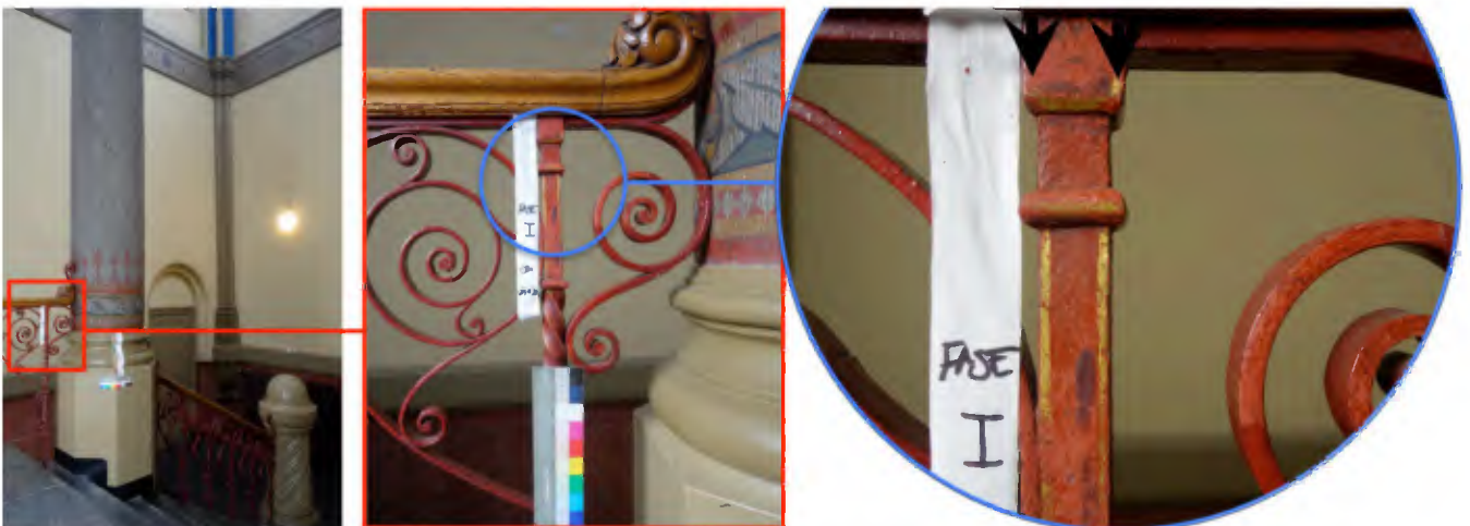
63. locatie kleuronderzoek smeedijzeren trapbalustrade, bibliotheek trappenhuis, J.03.1.12, met rode rechthoek aangegeven door auteur 64. detail doorlopende kijkvenster trap uitvergroting met blauwe cirkel door auteur aangegeven, trapbalustrade, bibliotheek trappenhuis 65. uitvergroting fase I: rood met gouden biezen en donkerrode patinering, trapbalustrade, bibliotheek trappenhuis, foto's auteur
