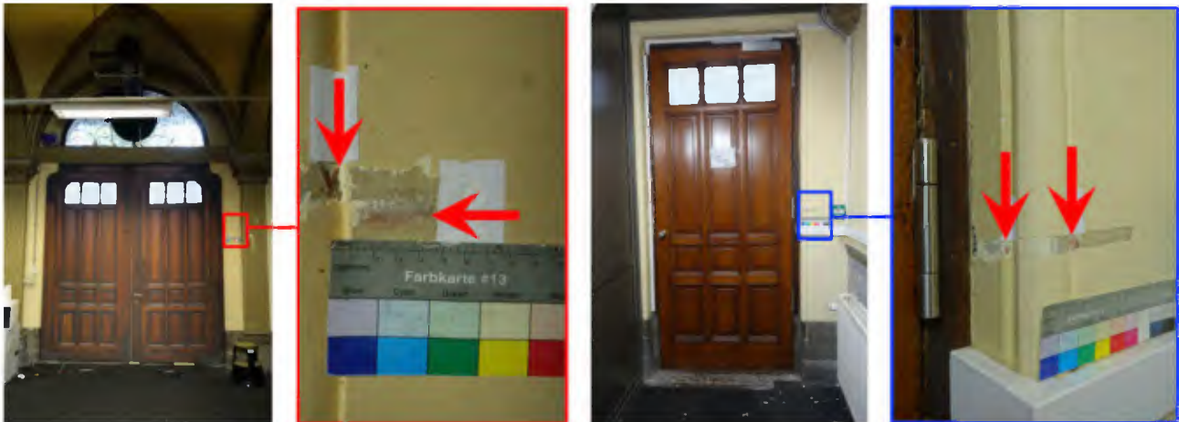
105. locatie kleuronderzoek natuurstenen deurkozijn, dubbele deur, vestibule, J.00.0.01b, met rode rechthoek aangegeven door auteur 106. detail kijkvenster natuurstenen deurkozijn, vestibule, J.00.0.01b, roodbruine bies met rode pijlen aangegeven door auteur 107. locatie kleuronderzoek natuurstenen deurkozijn, enkele deur, vestibule, J.00.0.01b, met blauwe rechthoek aangegeven door auteur 108. detail kijkvenster natuurstenen deurkozijn, vestibule, J.00.0.01b, roodbruine bies met rode pijlen aangegeven door auteur, foto's auteur
