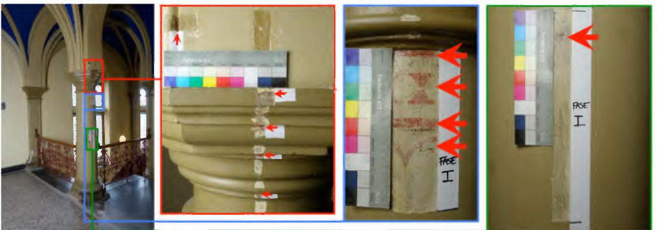
50. locatie kleuronderzoek stenen zuil, vestibule trappenhuis, J.03.1.30, met rode, blauwe en groene rechthoeken aangegeven door auteur 51. detail doorlopende kijkvenster, kapiteel van zuil, J.03.1.30, rode biezen met rode pijlen aangegeven door auteur 52. detail doorlopende kijkvenster schacht van zuil, boven, J.03.1.30, uitsparing bolornamenten en cannelures met rode pijlen aangegeven 53. detail kijkvenster schacht van zuil, midden, J.03.1.30, resten onduidelijke decoratie met rode pijl aangegeven door auteur, foto's auteur
