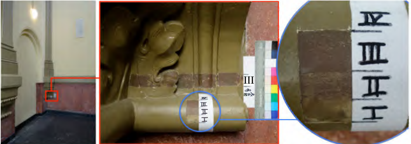
60. locatie kleuronderzoek natuurstenen console, bordes, bibliotheek trappenhuis, J.03.1.12, met rode rechthoek aangegeven door auteur 61. detail doorlopende kijkvenster en kleurtrap, uitvergroting met blauwe cirkel aangegeven door auteur, natuurstenen console, bordes 62. detail kleurtrap wand, in totaal 4 fasen, fase I: onbeschilderd natuursteen, console, bordes, foto's auteur
