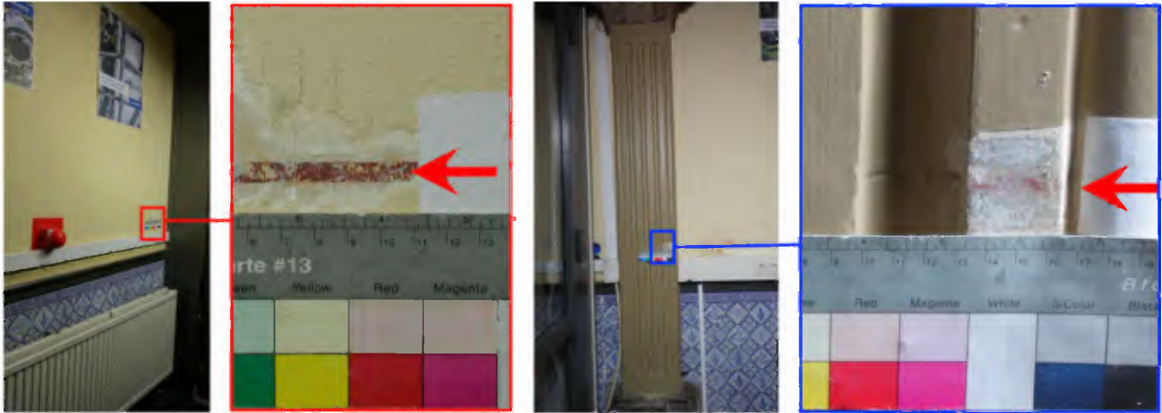
109. locatie kleuronderzoek gepleisterde wand, vestibule, J.00.0.01b, met rode rechthoek aangegeven door auteur 110. detail kijkvenster gepleisterde wand, vestibule, J.00.0.01b, roodbruine schijnvoeg met rode pijl aangegeven door auteur 111. locatie kleuronderzoek gepleisterde wand, vestibule, J.00.0.01b, met blauwe rechthoek aangegeven door auteur 112. detail kijkvenster gepleisterde wand, vestibule, J.00.0.01b, roodbruine schijnvoeg met rode pijl aangegeven door auteur, foto's auteur
