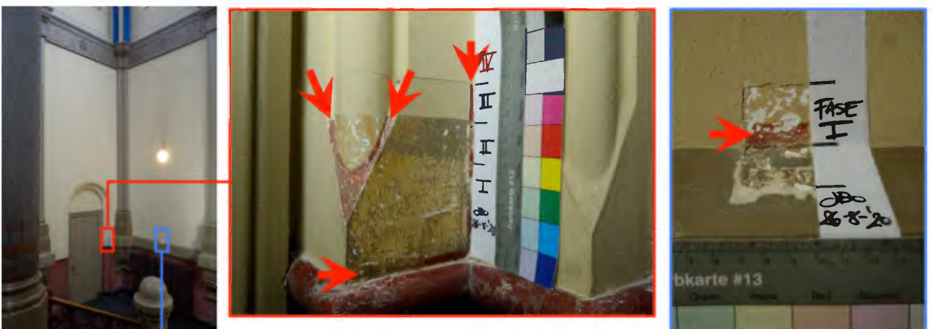
57. locatie kleuronderzoek deurkozijn en wand, bibliotheek trappenhuis, J.03.1.12, met rode en blauwe rechthoeken aangegeven door auteur 58. detail doorlopende kijkvenster natuurstenen deurkozijn, in totaal 3 fasen, fase I: okergeel met rode biezen langs randen 59. detail kijkvenster wand, fase I: okergeel met rode bies langs de rand en donkerbruin, foto's auteur
