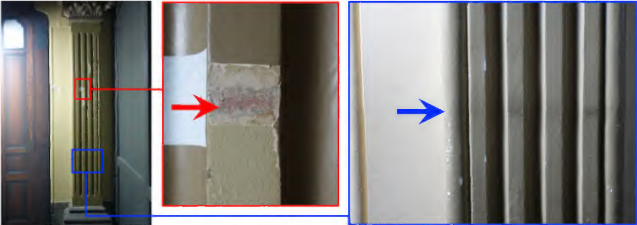
95. locatie kleuronderzoek natuurstenen pilaster, in strijklicht, vestibule, J.00.0.01b, met rode en blauwe rechthoek aangegeven door auteur 96. detail kijkvenster roodbruine voeg, natuurstenen pilaster, vestibule, J.00.0.01b, met rode pijl aangegeven door auteur 97. detail aftekening voeg, natuurstenen pilaster, in strijklicht, vestibule, J.00.0.01b, met blauwe pijl aangegeven door auteur, foto's auteur
