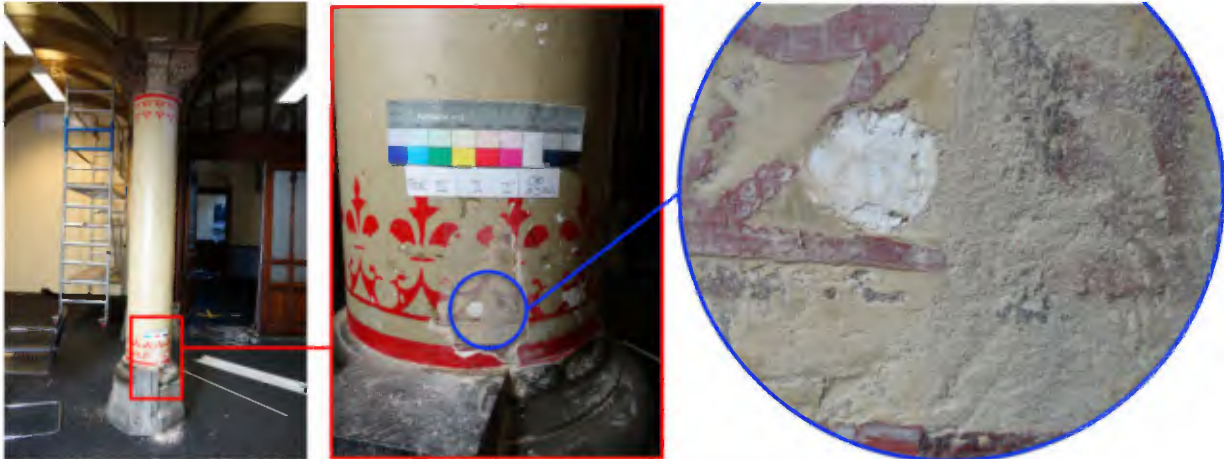
102. locatie kleuronderzoek natuurstenen zuil, vestibule, J.00.0.01b, met rode rechthoek aangegeven door auteur 103. detail kijkvenster natuurstenen zuil, vestibule, J.00.0.01b, uitvergroting met blauwe cirkel aangegeven door auteur 104. uitvergroting kijkvenster fase I: roodbruine sjablonering op natuurstenen drager (rechts) fase II: okerbruine overschildering met dikke roodbruine sjablonering (links), vestibule, J.00.0.01b, foto's auteur
