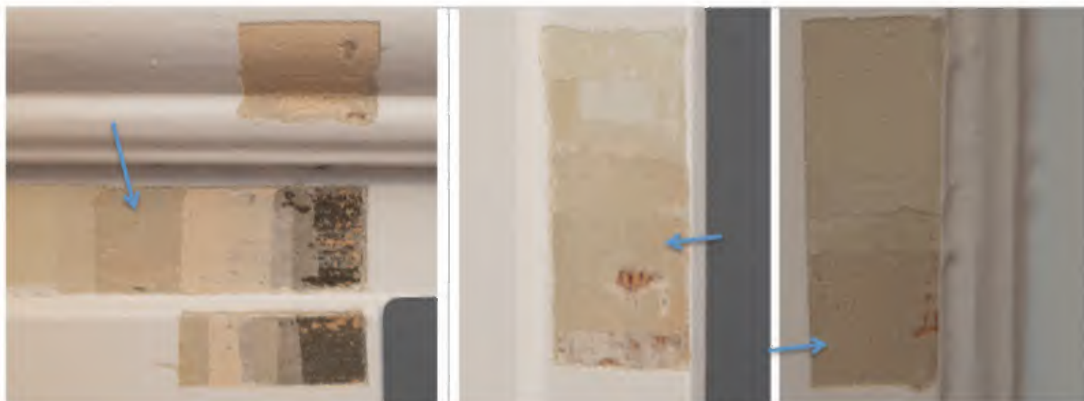
afwerking uit 1915 op v.l.n.r lambrisering, kozijn naar gang en binnenzijde luiken
