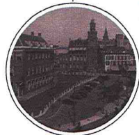
Na verbreding van de Hofweg ontstaat het Hofcingelplein (huidige Hofplaats)
