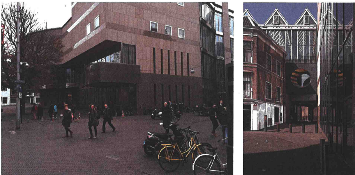
Afb. 29/30 Hoek Lange Poten/Hofplaats met uitkragend balkon (l) en doorgang naar de Hofpoort met 'oculus' (r).
