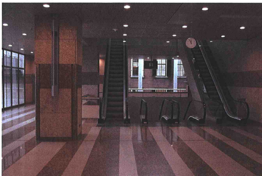
Afb.31/32 Natuurstenen bekleding in algemene ruimten met verlichtingsarmaturen (l) en achtergevel Hotel Central (r).
