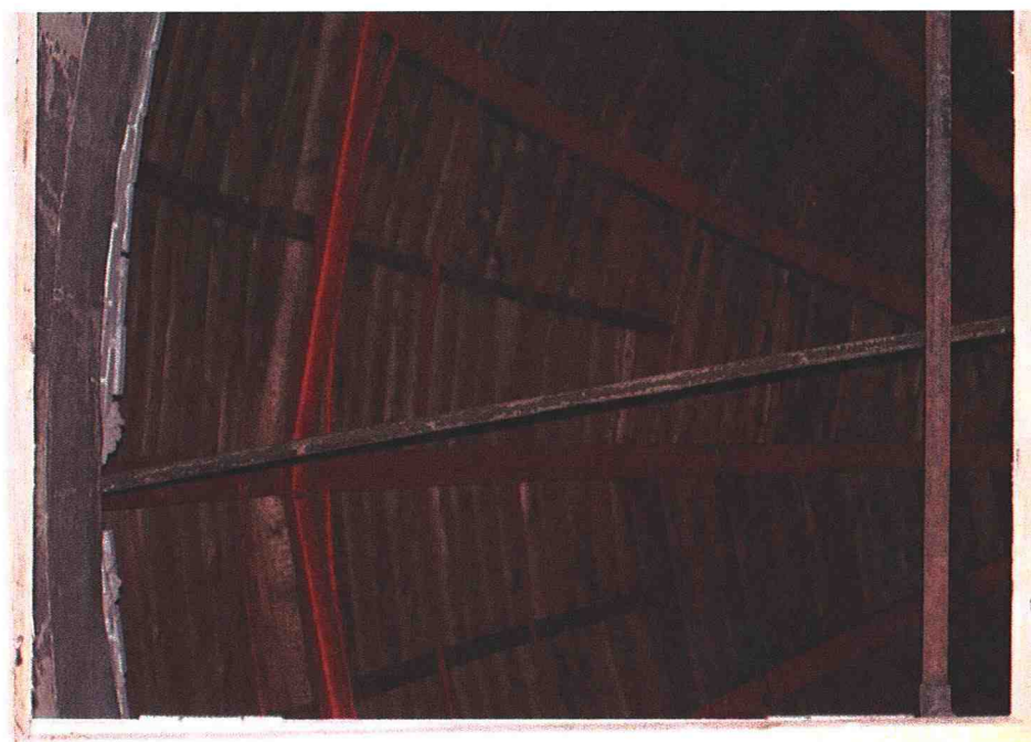
24. Zicht op de staalconstructie van de koepel in het midden van de voorgevel, na verwijdering van het verlaagde plafond in ruimte [REDACTED] zichtbaar geworden. Het glas van de koepel is in 1955 vervangen door een houten dakbeschot en een leibedekking. De koepel is niet toegankelijk.
