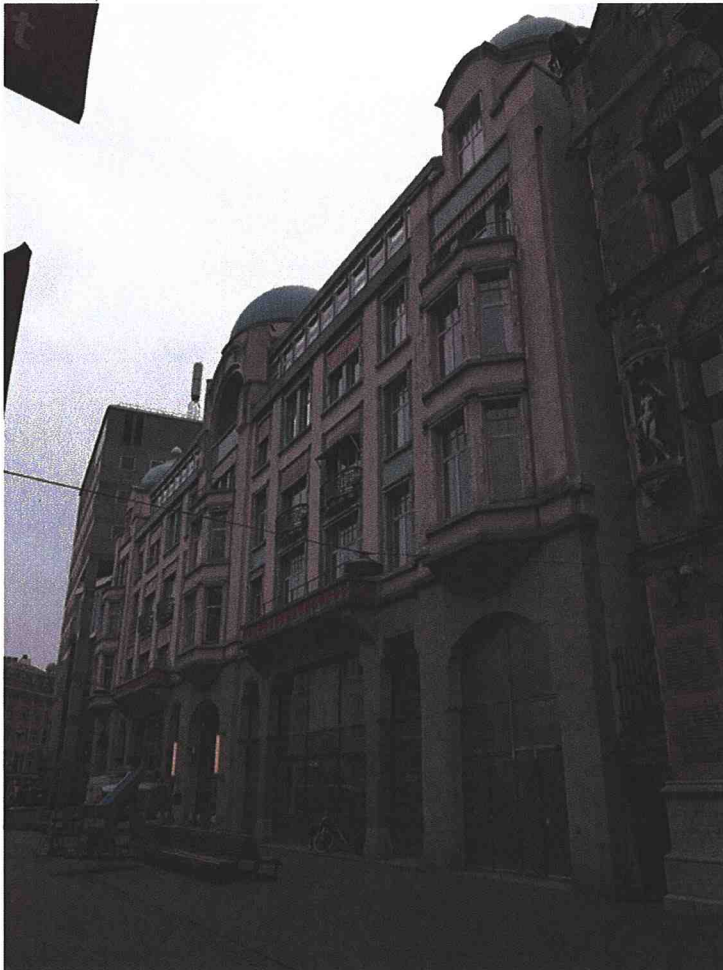
4. Overzichtsfoto van de voorgevel georiënteerd op het zuidoosten (in dit rapport als de zuidgevel benoemd). Door het vrij smalle profiel van de Lange Poten komt de gevel van Hotel Central nooit helemaal tot haar recht.
