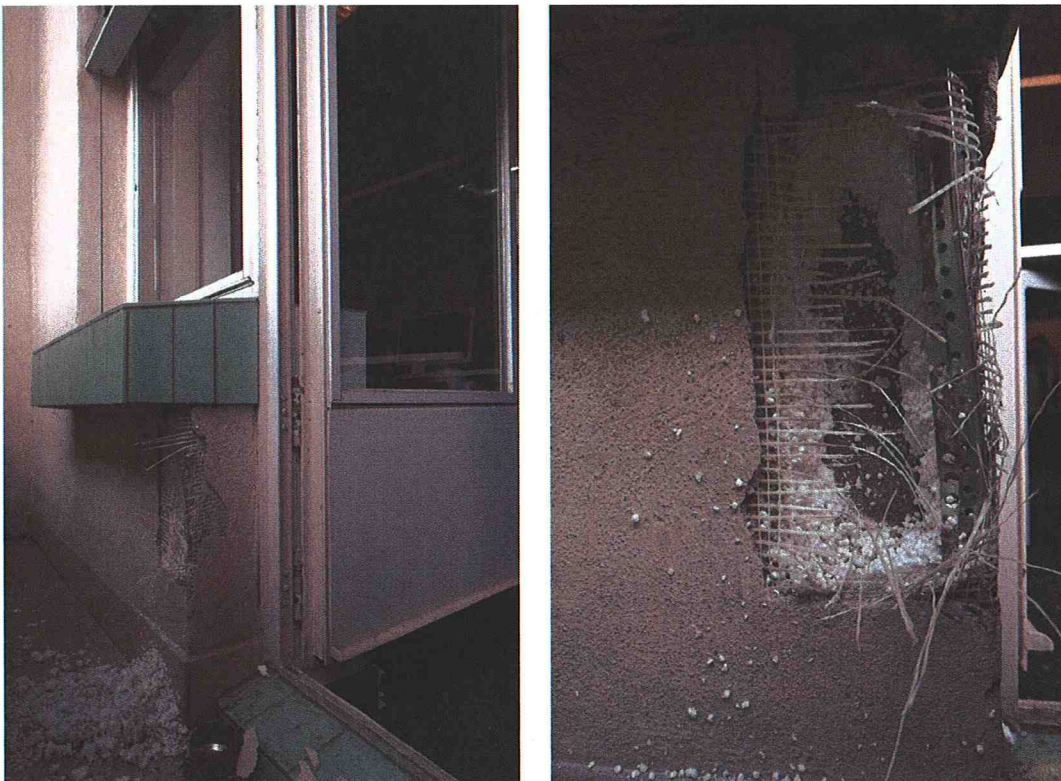
10. Destructief onderzoek aan de stucafwerking toont aan dat een polystyreen isolatielaag aan de buitenzijde op de betonnen gevel is aangebracht. Eronder is geen oorspronkelijke afwerking aangetroffen.
