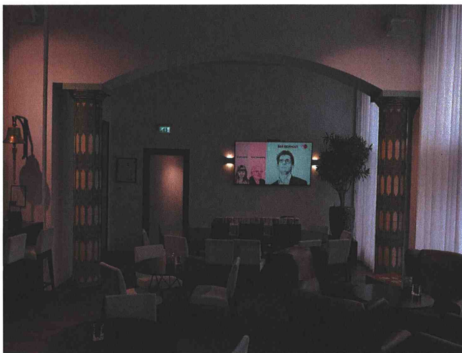
16. Twee van de vier zuilen met de originele aardewerken afwerking van De Porceleijne Fles in het restaurant van Nieuwspoor. Het vloerpeil ter plekke van de zuilen was oorspronkelijk op straatniveau, deze is later gelijk getrokken met het vloerpeil van de rest van de begane grond. De basementen van de zuilen bevinden zich onder het vloerniveau.
