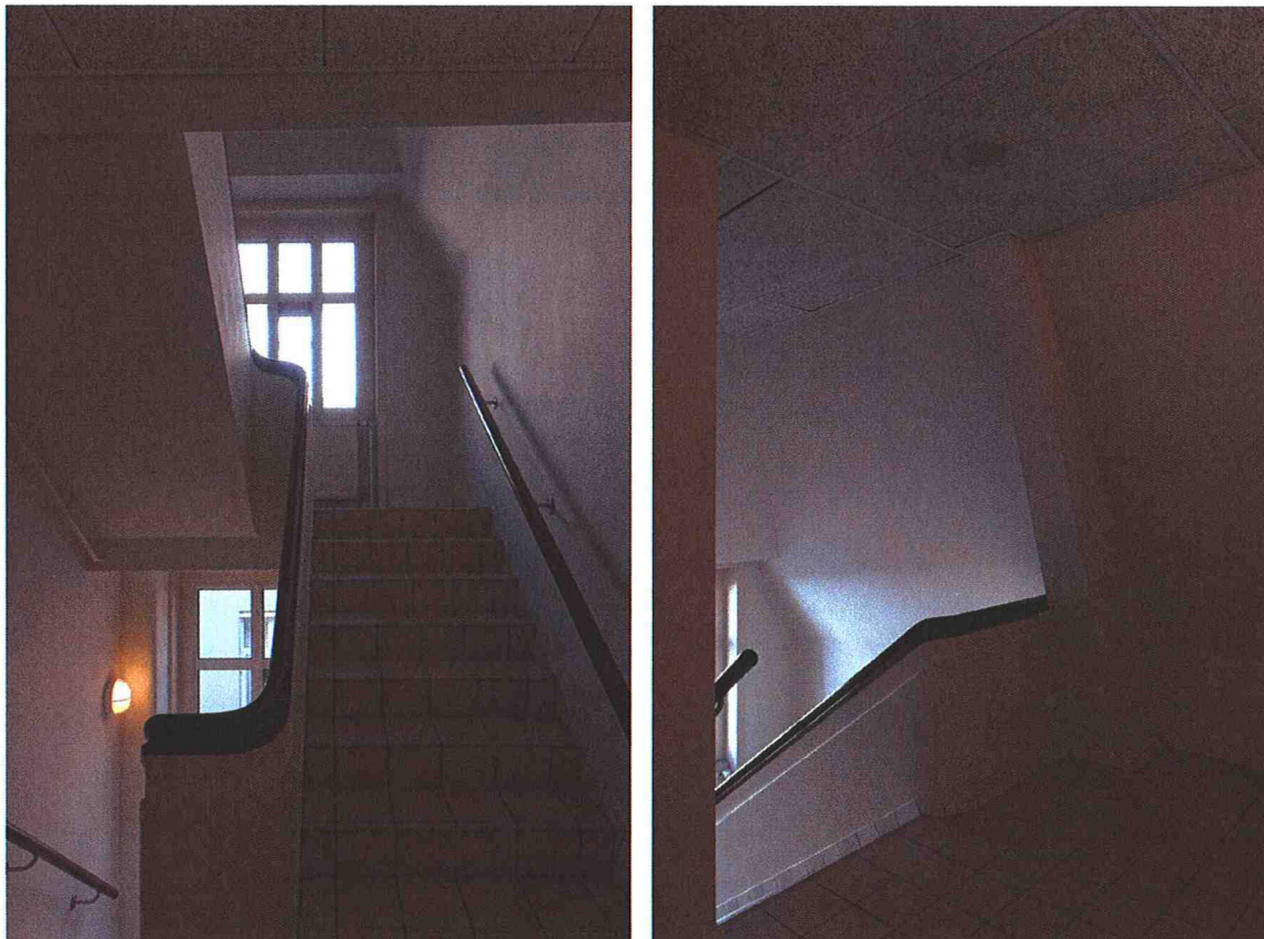
32. en 33. Deze betonnen trap stamt uit de bouwtijd, de treden en de vloeren zijn afgewerkt met gele tegels van later datum. De gesloten balustrade is afgewerkt met een stuclaag en heeft een houten handlijst. Op de rechter foto (verdieping 4) staat een ingepakt houten spant; ter plekke van dit trappenhuis is nog een deel van de originele kapconstructie aanwezig.
