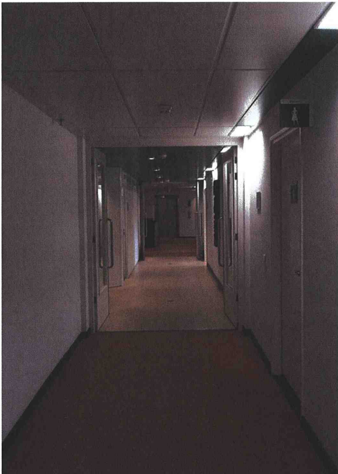
20. De huidige afwerking van de gangen bestaat uit een linoleum vloerafwerking, wanden met gesausd glasvlies en een verlaagd plafond van afwisselend MDF-platen en metalen platen (de groene platen ter plekke van de gele vloerafwerking).
