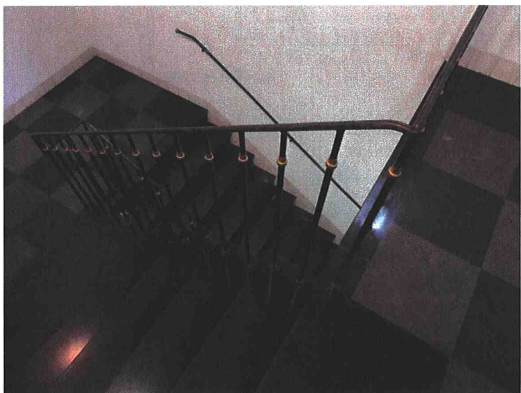
Afb. 23. De twee trapvluchten met bordes en tussenbordes waarop zerken van hardsteen en marmer in dambordpatroon.
