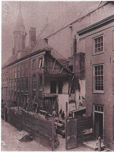
Afb. 45 en 46. Links sloop van de aanbouwen tegen de zuidgevel van de Grote Zaal tijdens de restauratie van 1896-1904. Rechts een oorspronkelijk kruisvenster in een van de traveeën van de zuidgevel van de Grote Zaal die tijdens de sloop van de aanbouwen in het zicht is gekomen. (Haags Gemeentearchief, ca. 1900)
