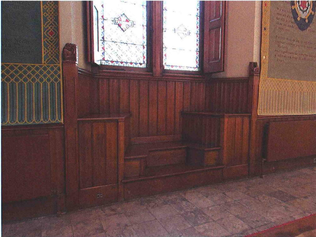
Afb. 50 en 51. Eikenhouten betimmering met vensterbanken uit ca. 1900 in een van de vensternissen van de noordgevel van de Grote Zaal. Links detail van het siersnijwerk.
