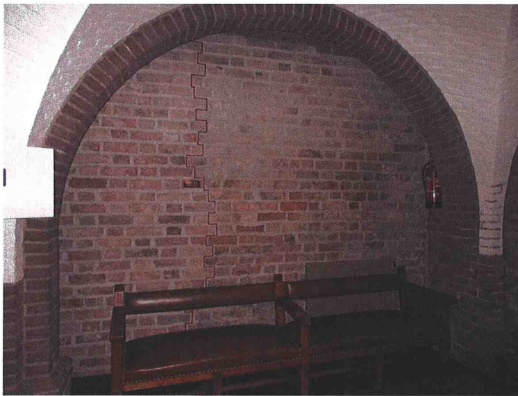
Afb. 19. Detail noordmuur Garderobekelder met muurwerk uit ca. 1230. Links van de met een rode lijn gemarkeerde bouwnaad het in 1971 aangevulde metselwerk.
