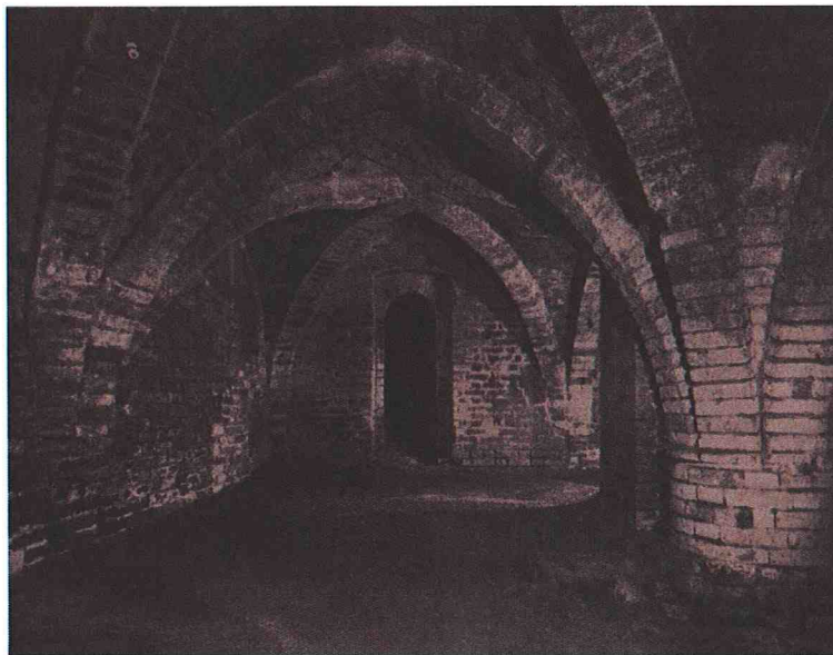
Afb. 3. De oudste kelder midden onder de Grote Zaal. Opname uit 1899. (Beschrijving 1907)
