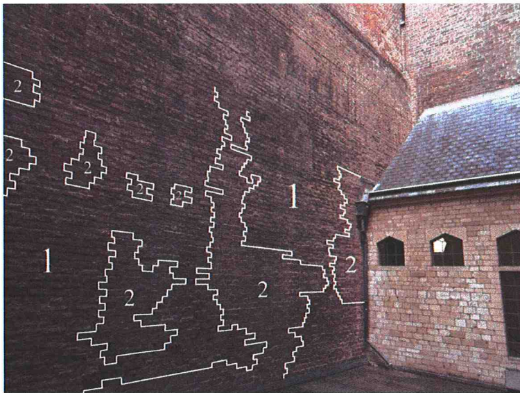
Afb. 30. Detail van de oostgevel van de Grote Zaal (westgevel binnenplaats) waarin met cijfers de verschillende soorten metselwerk is aangegeven. 1. Oorspronkelijk metselwerk uit ca. 1295, uitgevoerd in Vlaams verband. 2. Restauratiewerk van 1968-1971.
