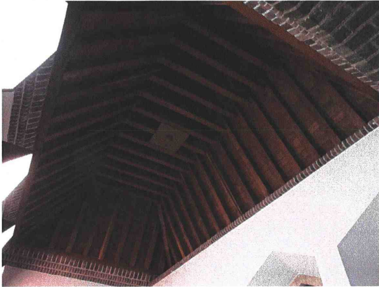
Afb. 21. Interieur van het trapportaal uit 1968-1971 met de eikenhouten sporenkap met hanebalken op een uitkragende lijst van geprofileerde baksteen.
