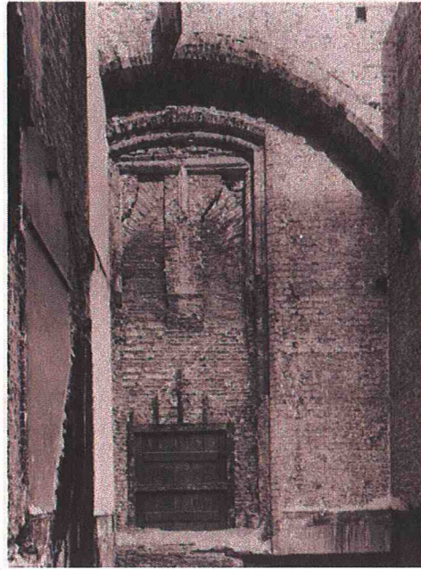
Afb. 45 en 46. Links sloop van de aanbouwen tegen de zuidgevel van de Grote Zaal tijdens de restauratie van 1896-1904. Rechts een oorspronkelijk kruisvenster in een van de traveeën van de zuidgevel van de Grote Zaal die tijdens de sloop van de aanbouwen in het zicht is gekomen. (Haags Gemeentearchief, ca. 1900)
