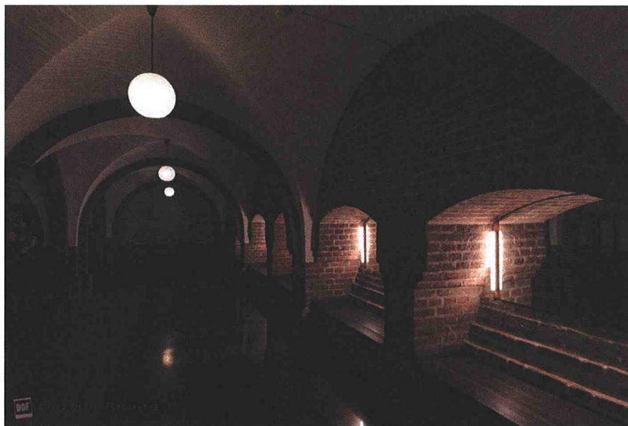
Afb. 25. Garderobekelder met een overwelling van kruisgraatgewelven tussen gordelbogen. De gewelven zijn van een witte verflaag voorzien. (D. Otten Fotografie)
