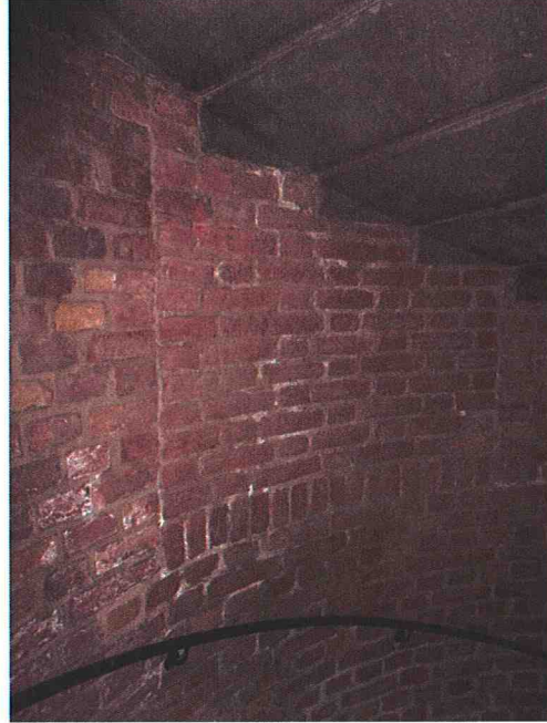
Afb. 6 en 7. Links de bovenzijde van de dichtgezette oorspronkelijke doorgang naar de binnentuin in de ronde traptoren van het Rolgebouw. Rechts de onderzijde. Tijdens de restauratiecampagne van 1896-1904 is de wenteltrap in gewijzigde vorm gereconstrueerd i.v.m. de jongere entree in de zuidgevel van de toren, zodat de trapvlucht nu voor de dichtzetting van de doorgang loopt.
