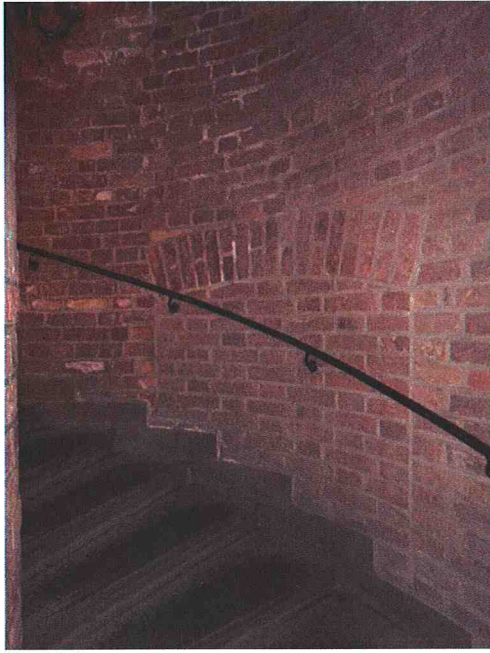
Afb. 6 en 7. Links de bovenzijde van de dichtgezette oorspronkelijke doorgang naar de binnentuin in de ronde traptoren van het Rolgebouw. Rechts de onderzijde. Tijdens de restauratiecampagne van 1896-1904 is de wenteltrap in gewijzigde vorm gereconstrueerd i.v.m. de jongere entree in de zuidgevel van de toren, zodat de trapvlucht nu voor de dichtzetting van de doorgang loopt.
