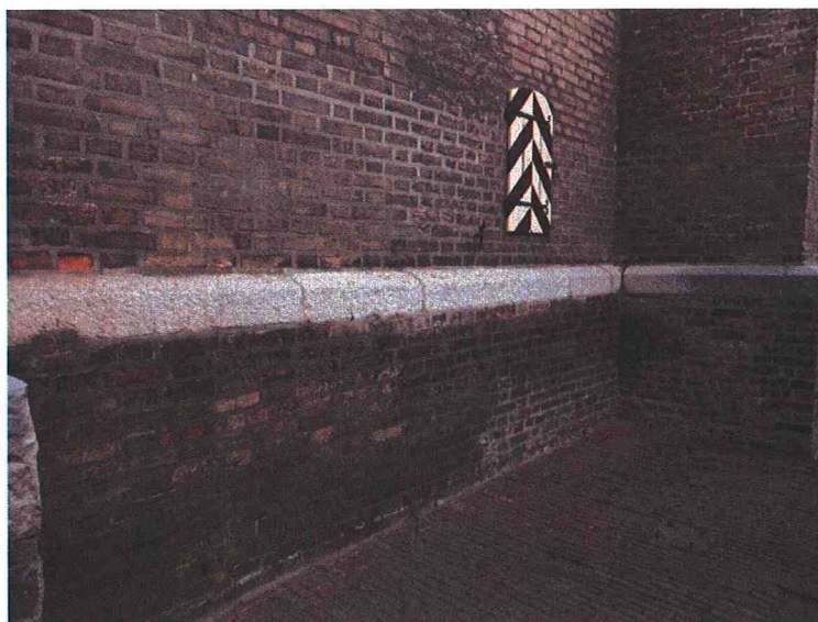
Afb. 41. Meest westelijk gevelvlak van de zuidgevel naast de originele kelderentree uit ca. 1295. 1. Origineel metselwerk uit ca. 1295 met sporadisch ingeboete bakstenen uit ca. 1900. 2. Recent inboetwerk. 3. Gevelhoek van de originele kelderentree uit ca. 1295. 4. Versnijdingen (overgang van funderingswerk naar opgaand gevelwerk). Markeert tevens het originele maaiveldniveau. 5. Doornikse steen uit ca. 1295. 6. Arduin (Namense steen) uit ca. 1900.
