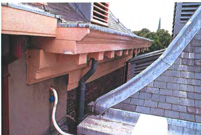
242 Detail natuurstenen gootlijst en bakgoot op klossen van het gebouw van de Statenzaal ter hoogte van de overgang naar het oostelijk deel van de noordvleugel.
