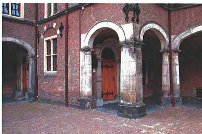
236b Entree uitbouw grote trappenhuis.
