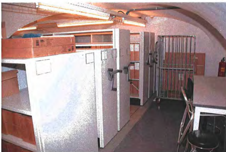
283 Archiefkelder overdekt met kruisgewelven met een kolom in het midden als ondersteuning.
