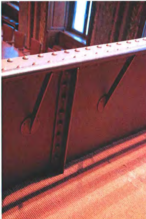
264 Statenzaal, oostzijde, binnenzijde van de balustrade van de geklonken vollewandligger uit 1881; in 1994 is de geornamenteerde betimmering aan de buitenzijde vervangen door bespanning van stof (zie afb. 260 en 261).
