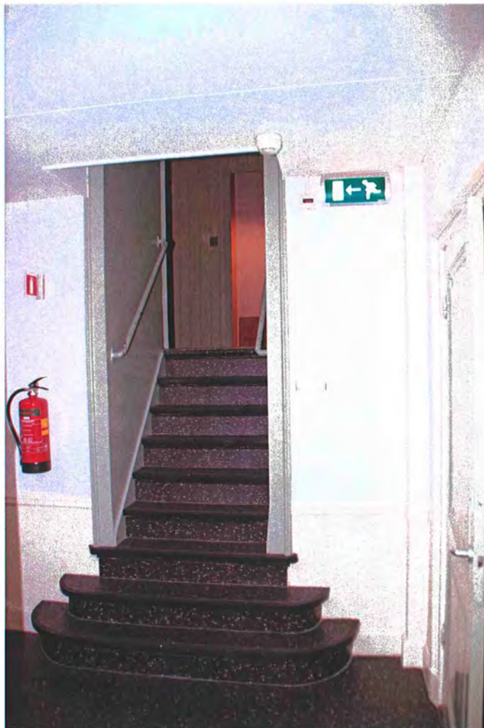
295 [REDACTED] Trap aan de westzijde vanaf omloop naar hoger gelegen tweede verdieping van het westelijk bouwdeel met Statenzaal (1913).
