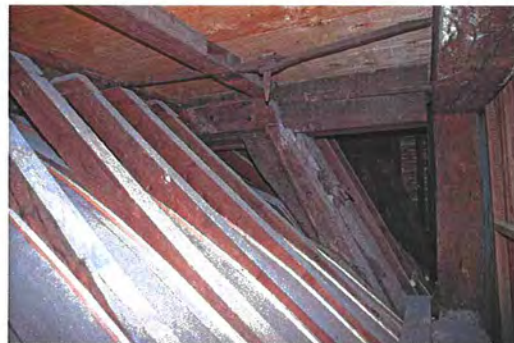
246a-b Detail van op de zolder ingebouwd gewelf boven vergaderzaal van de Staten van Holland uit 1655.
