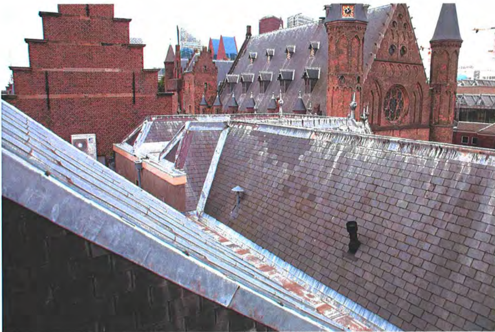
288 Zadeldak boven de galerij aan de zuidzijde en rechts op de achtergrond het omlappend schilddak van het paviljoen/de uitbouw met kabinet Mary Stuart.
