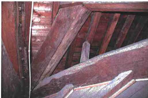
246a-b Detail van op de zolder ingebouwd gewelf boven vergaderzaal van de Staten van Holland uit 1655.
