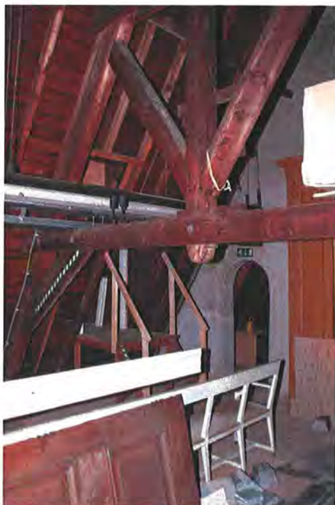
359 Deel van de grote kapconstructie [redacted] van Buitenhofvleugel.
