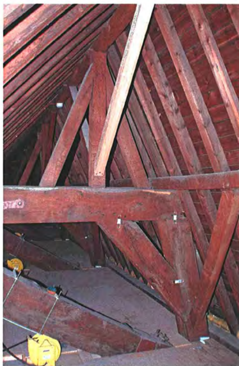
247 Halfspant aan de zuidoostzijde van de zolder.
