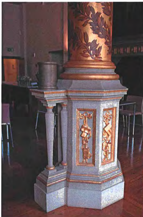
271 XXXXXXXXXX Het basement van de kolom heeft een baluster van de oorspronkelijke balustrade tussen de kolommen behouden, nu als 'zijtafel' in gebruik.
