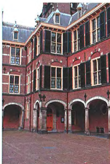
236a Uitbouw grote trappenhuis (zie beschrijving Buitenhofvleugel, cluster 1, Mauritsdeel).
