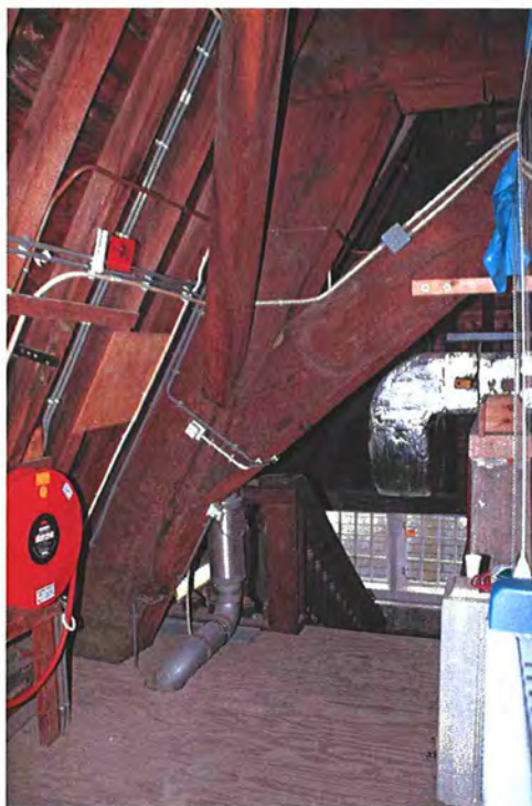
245 Geschoorde nokstijl bij het omlopende schilddak.
