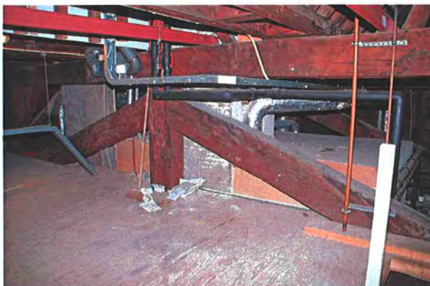
244 Spant met aan de bovenzijde geschoorde stijl.
