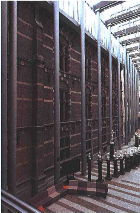
Twee beelden van het meest westelijke deel van de noordvleugel, gezien vanuit de Statenpassage. De gevelwand is niet geopend naar de Statenpassage. De nieuwe kolommen hebben een afwijkend ritme ten opzichte van de gevelopeningen.
