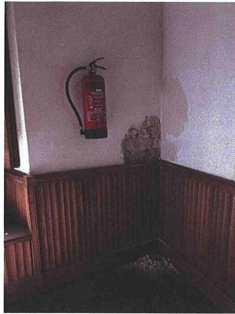
Afb. 17 en 18. Links de westmuur van de Weeskamer tijdens de ontpleisteringswerkzaamheden. Vanwege de flinterdunne cementlaag onder de witte pleisterlaag is de ontpleistering (3 uur machinaal afbikwerk) beperkt tot een smalle strook. Rechts de binnenhoek van de west- en zuidmuur van de Weeskamer met in de hoek van de zuidmuur afgefallen pleisterwerk met erachter origineel metselwerk uit circa 1250.
