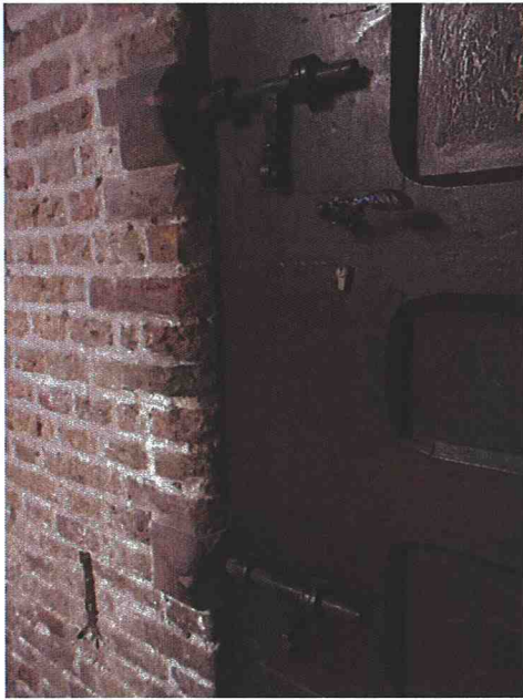
Afb. 30 en 31. Links detail van de kelderdeur met twee smeedijzeren grendels en grendelblokken van rode zandsteen. Het onderste grendelblok is origineel en het bovenste dateert uit 1896-1904. Rechts een console van het keldergewelf, opgebouwd uit twee blokken natuursteen, de onderste van tufsteen en de bovenste van rode zandsteen. Rechts van de console is een rollaagje van de bodem van een recent dichtgezette kaarsnis herkenbaar.
