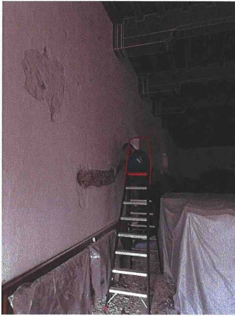
Afb. 17 en 18. Links de westmuur van de Weeskamer tijdens de ontpleisteringswerkzaamheden. Vanwege de flinterdunne cementlaag onder de witte pleisterlaag is de ontpleistering (3 uur machinaal afbikwerk) beperkt tot een smalle strook. Rechts de binnenhoek van de west- en zuidmuur van de Weeskamer met in de hoek van de zuidmuur afgefallen pleisterwerk met erachter origineel metselwerk uit circa 1250.
