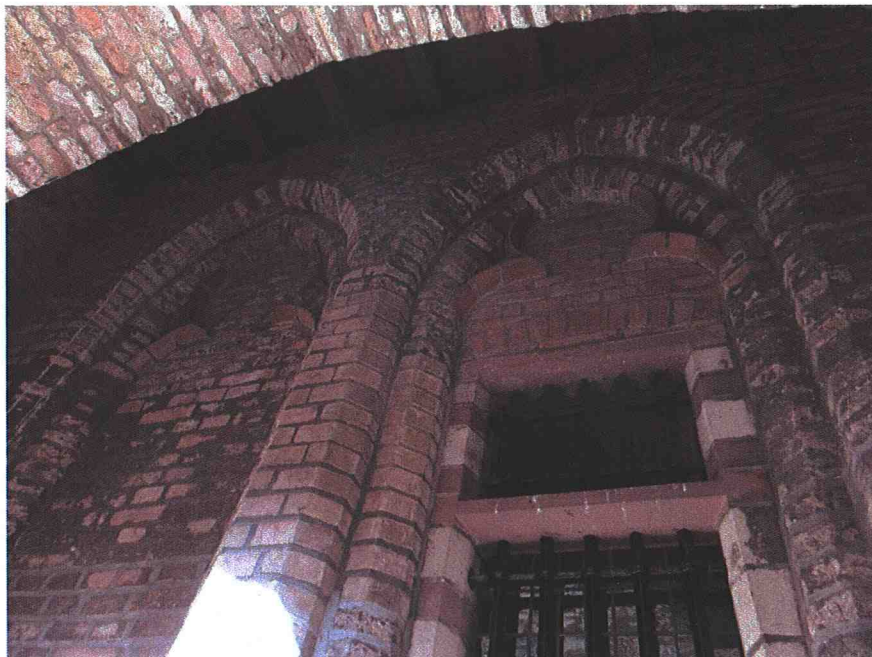
Afb. 32. Detail van de keldergevel met recent inboetwerk en de vernieuwde driepassen. De kinderbinten uit 1896-1904 vertonen afgeschuinde kanten, een biljoen genaamd, die eindigen met een kappelletje (Zie: E.J Haslinghuis – H. Janse, Bouwkundige termen, Verklarend woordenboek van de westerse architectuur- en bouwhistorie , Leiden 1997, p. 75). Het natuursteenwerk van tufsteen en rode zandsteen en het traliwerk van het venster dateren uit 1896-1904, op de bovenste zandstenen latei na, die origineel is.
