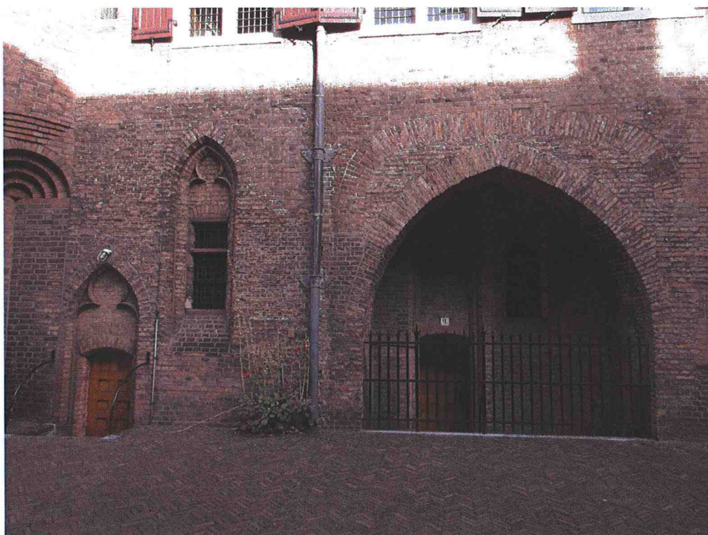
Afb. 20. Detail van de zuidelijke gevel van het De Lairessegebouw met rechts onder de spitsboog en achter het hekwerk, enigszins verborgen, de terugliggende keldergevel. Boven de later toegevoegde spitsboog is de hoge korfboog zichtbaar.
