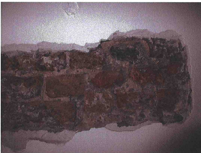
Afb. 19. Detail van het ontpleisterde muurwerk met links het originele geelkleurige metselwerk uit circa 1250 en rechts het rood/oranje kleurige metselwerk uit 1896-1904.
