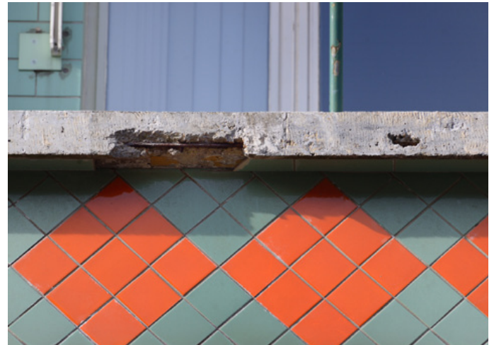
Afbrokkelend beton
