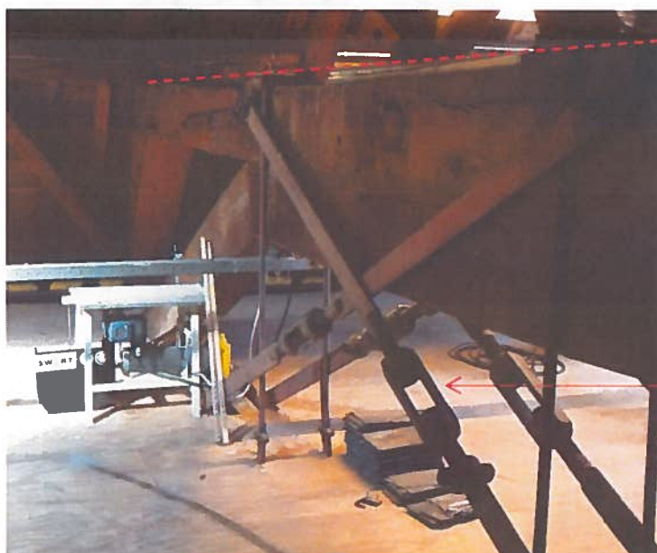
Foto 4- spant III- vervorming dekbalk
