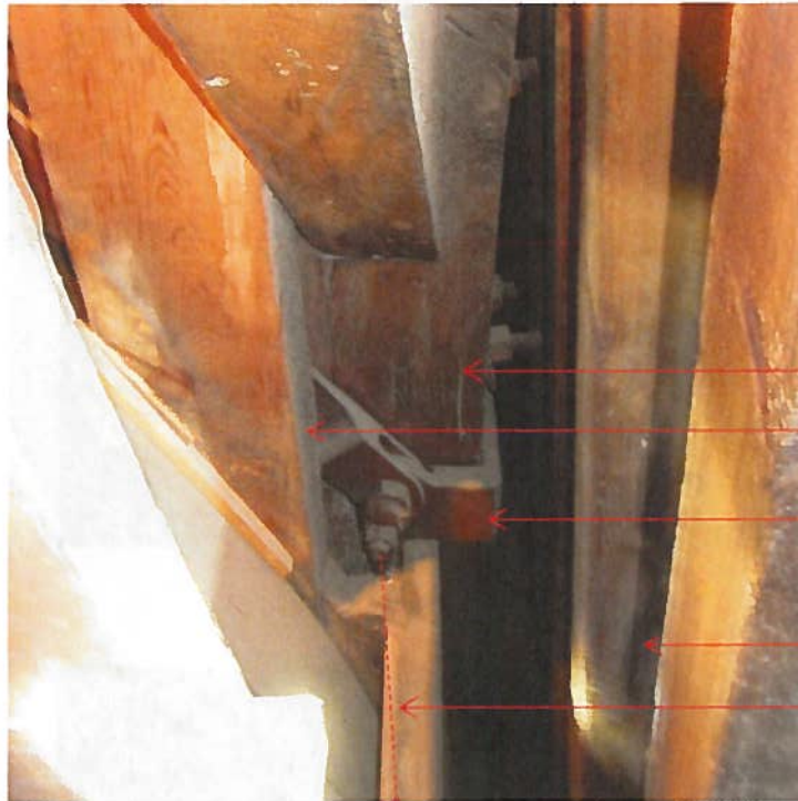
Foto 1- spant V- spantbeen hofvijver zijde- onderaansluiting staalconstructie
