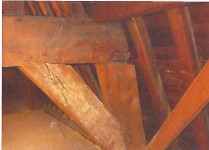
Foto 8- Spant V- hoekverbinding spantbeen met dekbalk
