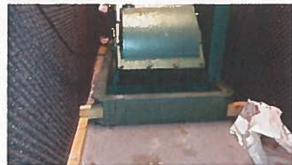
opstelling in ruimte
