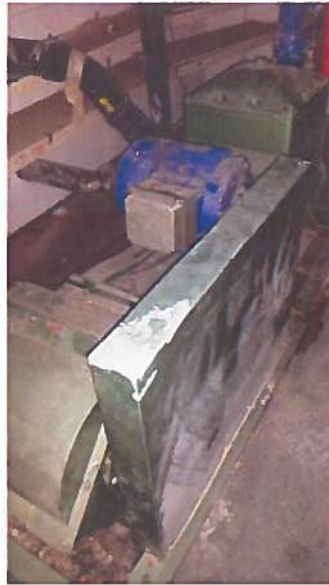
opstelling in ruimte
