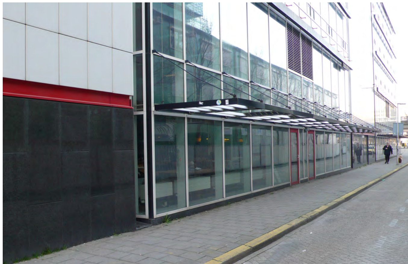
AANSLUITING TRANSPARANT GEVELDEEL OP DICHT GEVELDEEL
