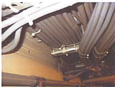
Foto: onderaanzicht kabel tracé
