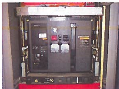
Foto: Automaat Merlin Gerin (Groupe Schneider) type Masterpact M12H1/M25H1 serie
