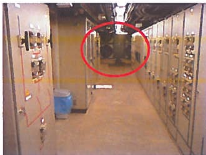
Foto: afzuigventilatoren in de laagspanningsruimte
