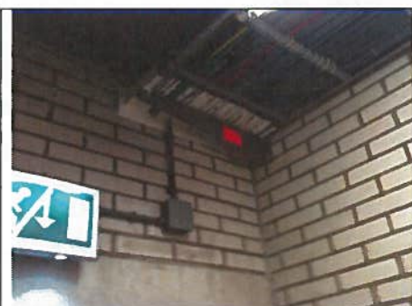
Foto 67 – Nieuwbouw brandwerende doorvoering kabelgoot
