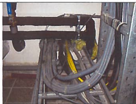
Foto 16 – [REDACTED] Doorvoering brandwerend?
