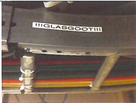
Foto 71 – Nieuwbouw glasvezelkabelgoot
