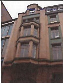
Foto 35 – Verwijderde tegels gevel
