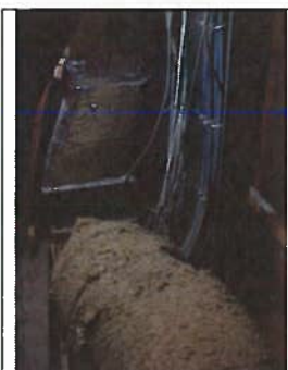
Foto 11 – [redacted] Doorvoering brandwerend?
