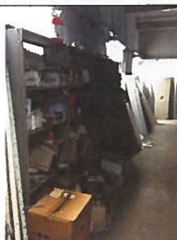
Foto 66 – Nieuwbouw opslag in technische ruimte
