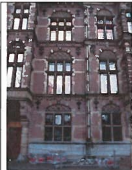
Foto 39 – Bouwmaterialen op straat voor de gevel
