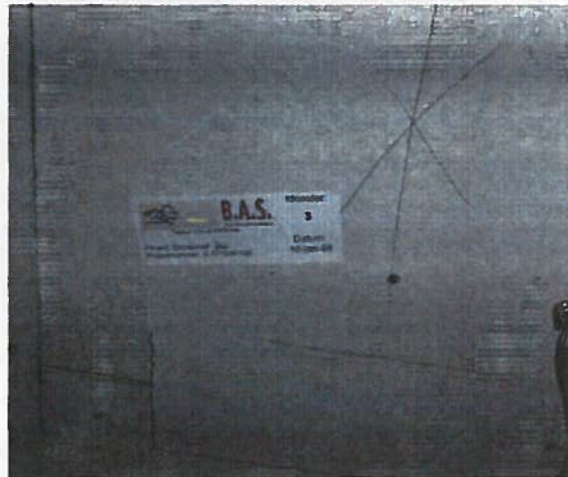
Foto 3, plaatmateriaal, bevat 20-40% Amosiet en 0,5-5% Chrysotiel.
