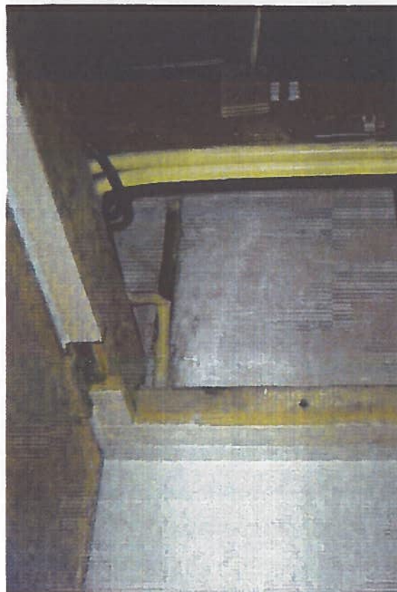
Foto 1, M-1 Plaatmateriaal, bevat 20-40% Amosiet.
