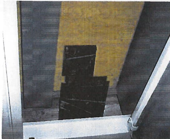
Foto 3, M-3 plaatmateriaal, bevat geen asbest.
