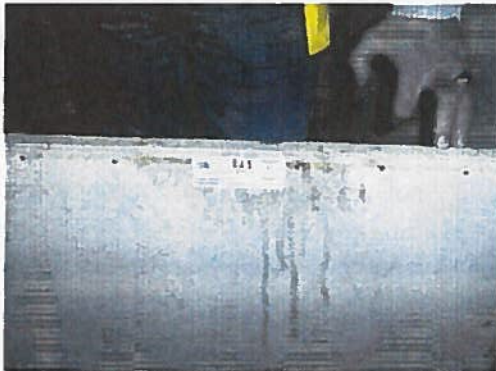
Foto 19, M-17 plaatmateriaal, bevat 20 – 40% Amosiet.
