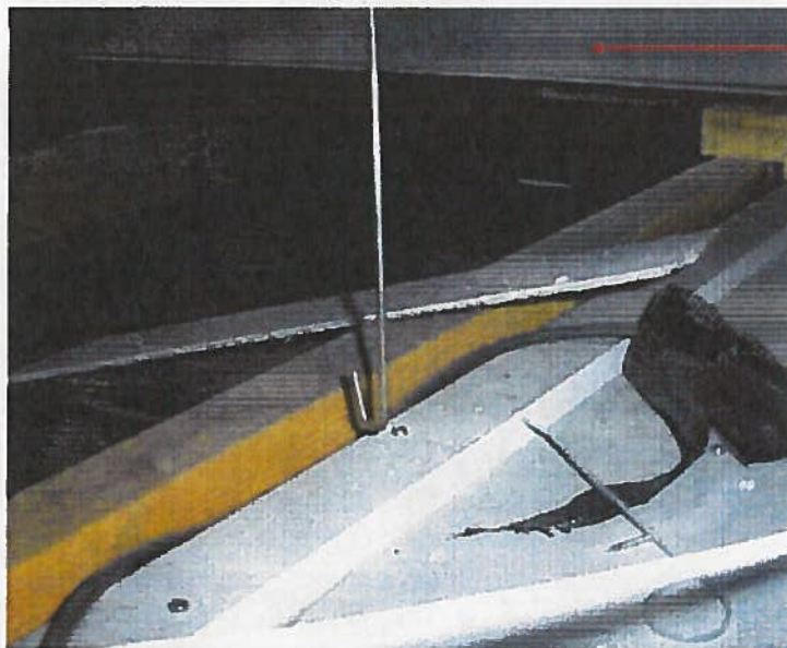
Foto 1, M-1 plaatmateriaal bevat 20 – 40% Amosiet en 0,5 – 5% Chrysotiel
