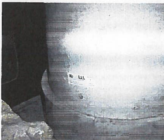
Foto 9, M-7 pilaar, bevat 10 – 20% Crocidoliet en 10 – 20% Chrysotiel.
