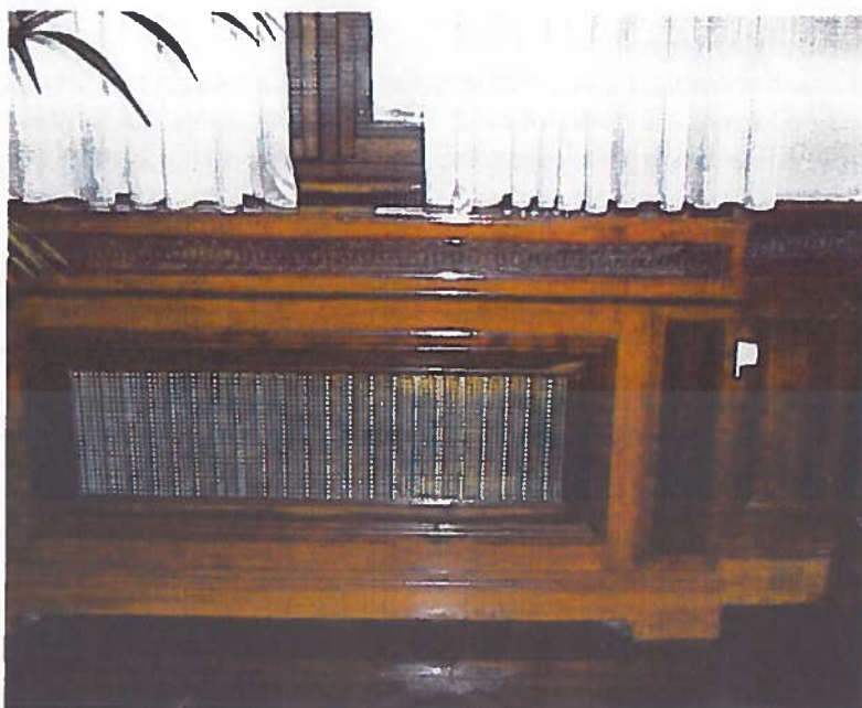
Foto 4, M-4 plaatmateriaal in de convectorkast, bevat 20 – 40% Chrysotiel.
