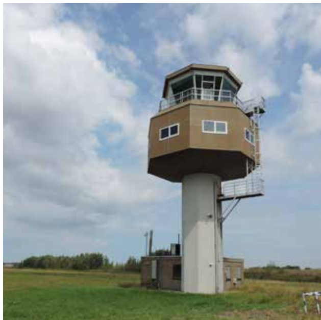
Bestaande verkeerstoren - voormalig Marine Vliegveld Valkenburg
