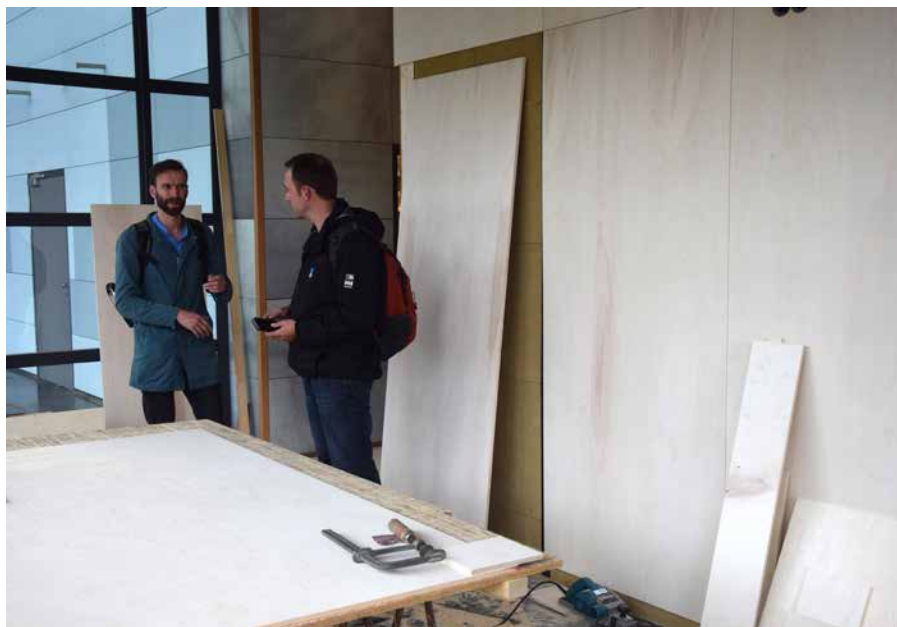
Biobased binnenwanden in rijkskantoor Graadt van Roggenweg 500 Utrecht
