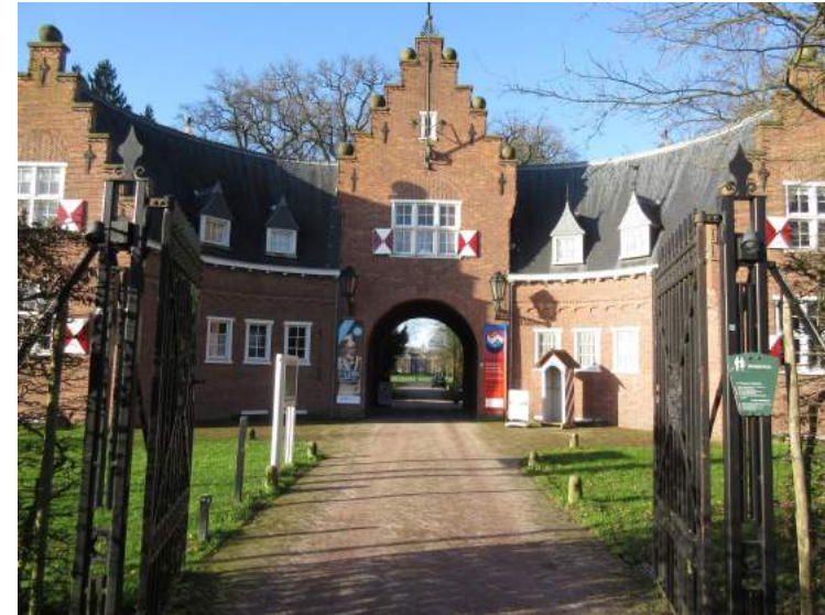
Poortvleugel gezien vanaf de Langbroekerweg
