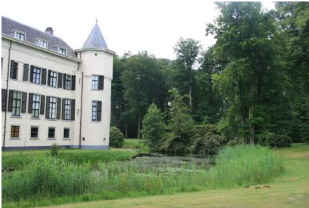
Zicht op het Huis vanaf het Achtergazon
