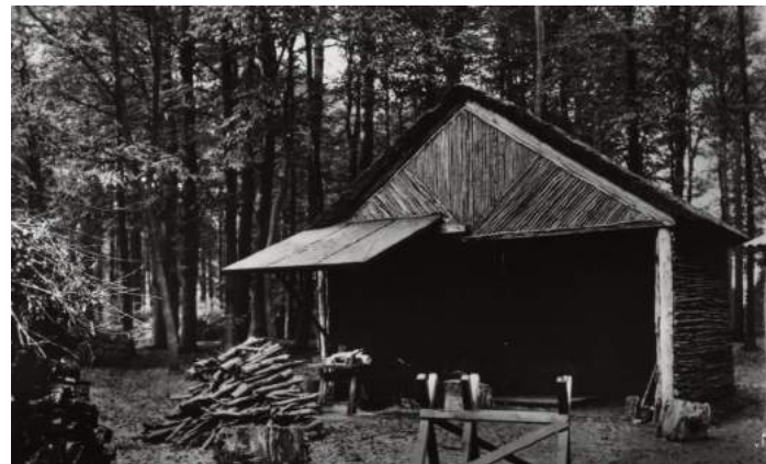
De originele schuur op de houtplaats, ca. 1935
