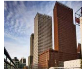
Het nieuwe Rijkskantoor aan Turfmarkt 147, te Den Haag.
