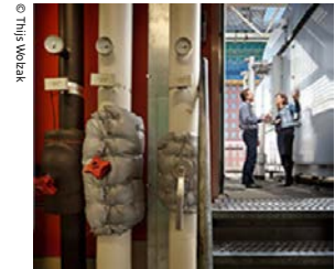
Integrale inspectie levert grote efficiencywinst.
