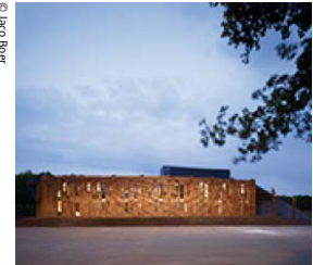
Kantoor Rijkswaterstaat niet alleen voorbeeldkantoor; je kunt er ook heel prettig werken.
