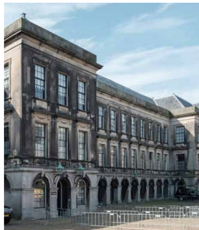
Locatie thermografische opname
