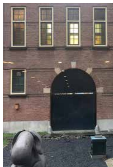
Zicht op poort zonder doorgang, bestaand
