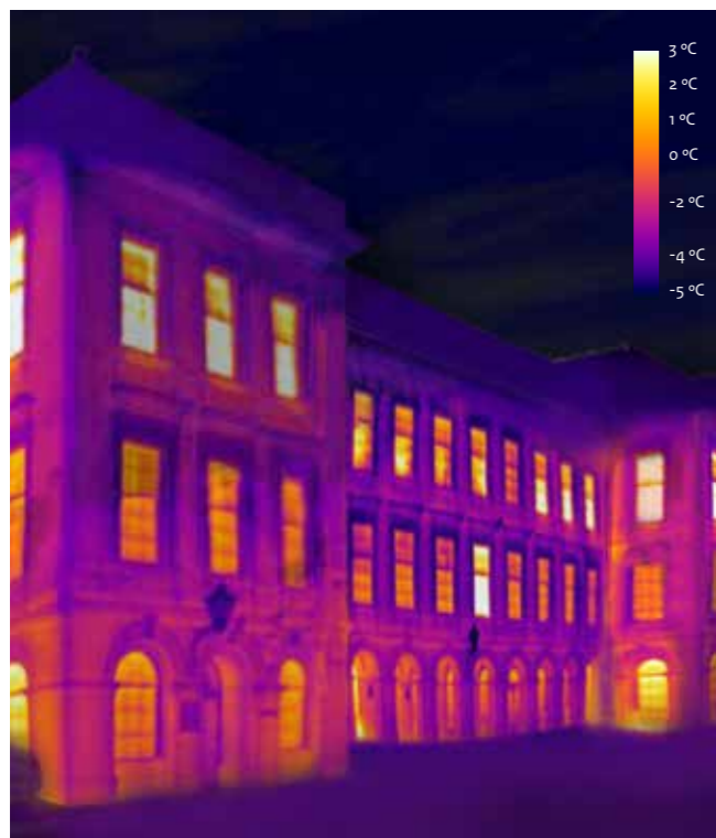
Thermografische opname Gebouw A ten behoeve van analyse warmteverlies
