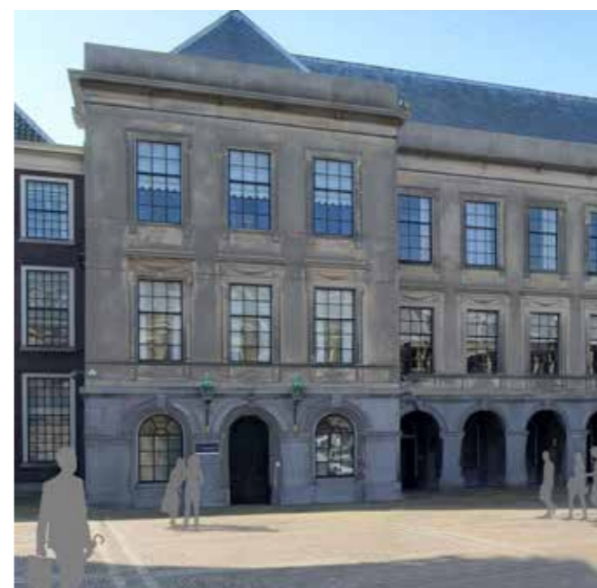
Gerenoveerde en gereinigde gevel
