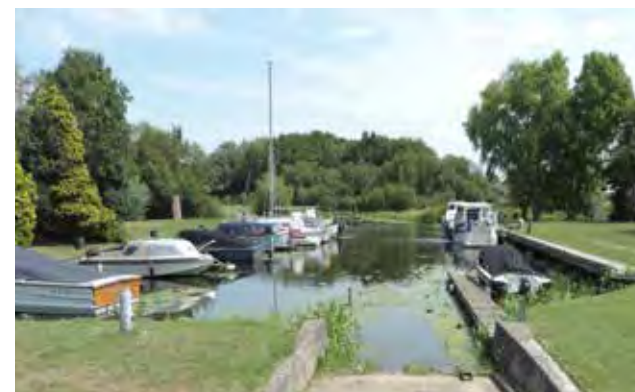
Insteekhaven ter hoogte van het gemaal
